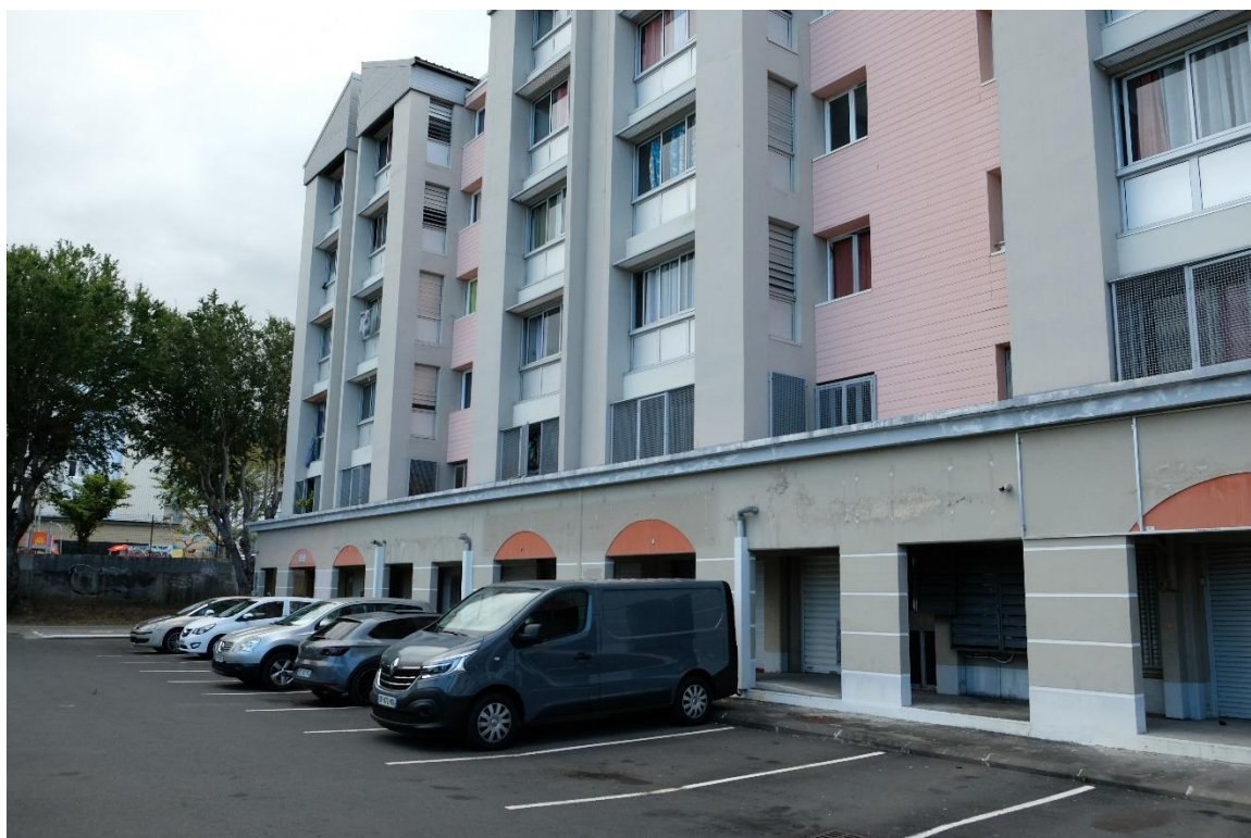
Photo 11 : Emplacement de la maison du projet à Vauban (© Tanika Join, septembre 2022)
