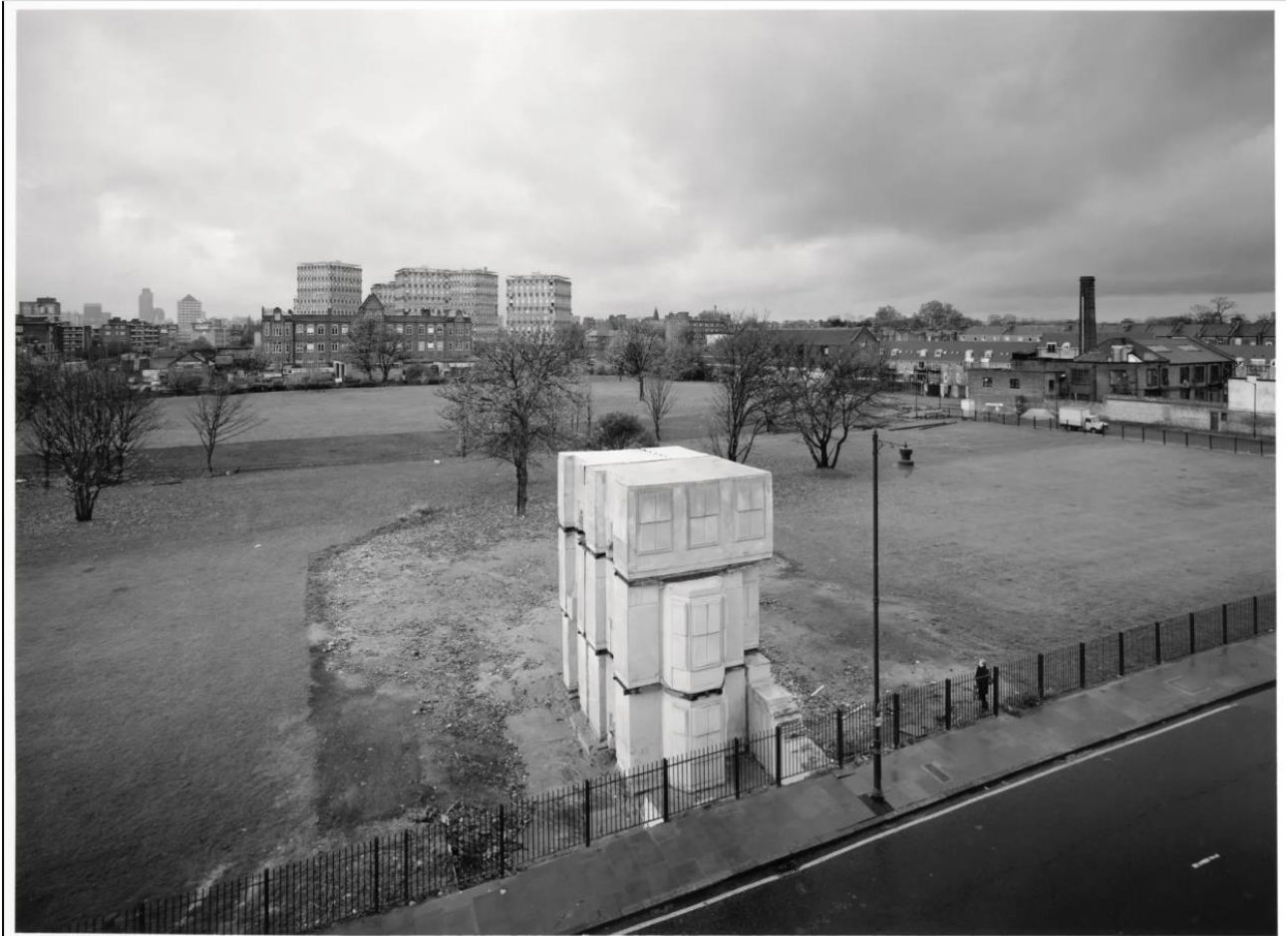
Figure 10 – Rachel Whiteread, « House », 1993, Grove Road, Mile End, Tower Hamlets, photographié par John Davies.
