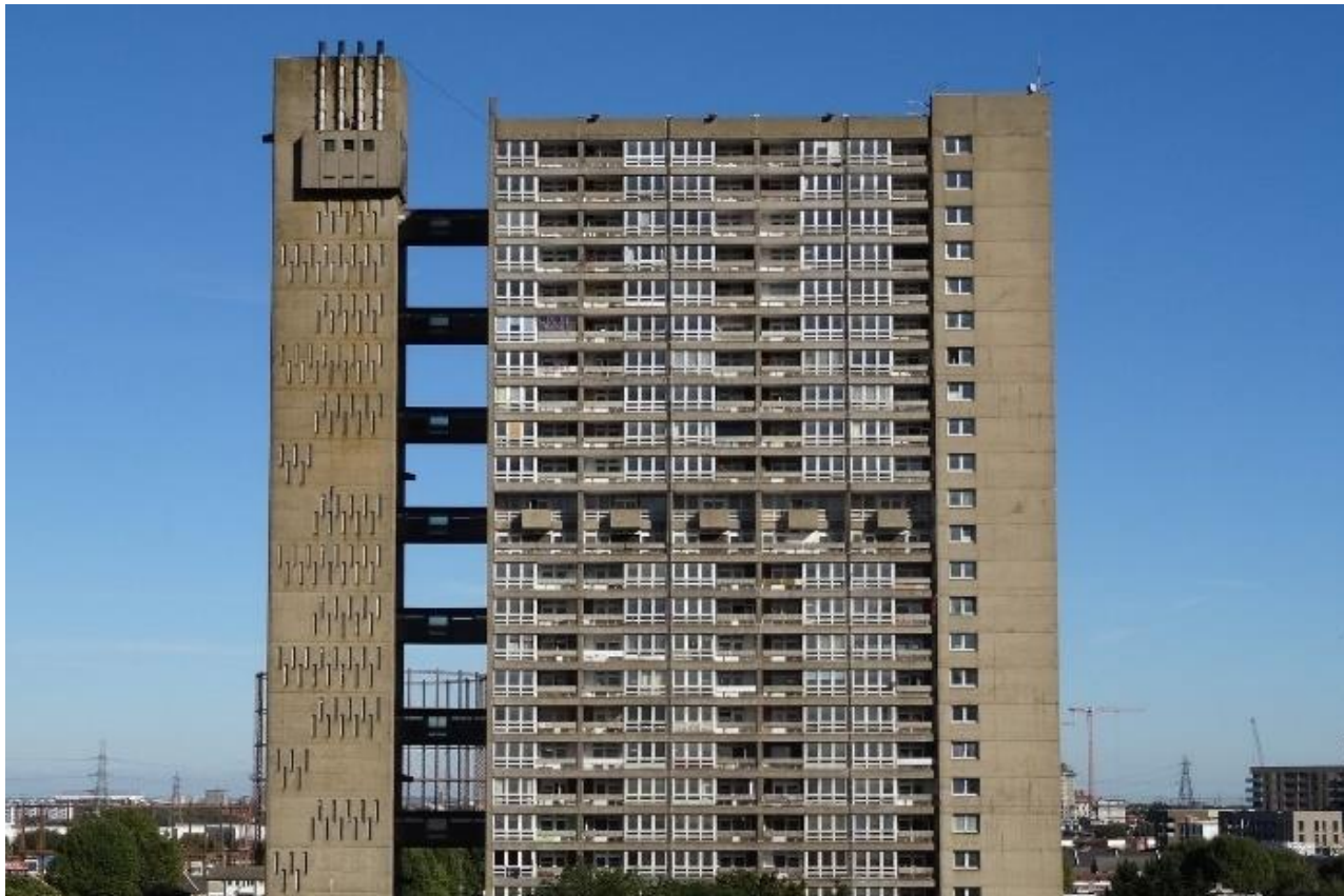
Figure 7 – Balfron Tower, Brownfield Estate, conçu par Ernö Goldfinger, 1965-1967.
