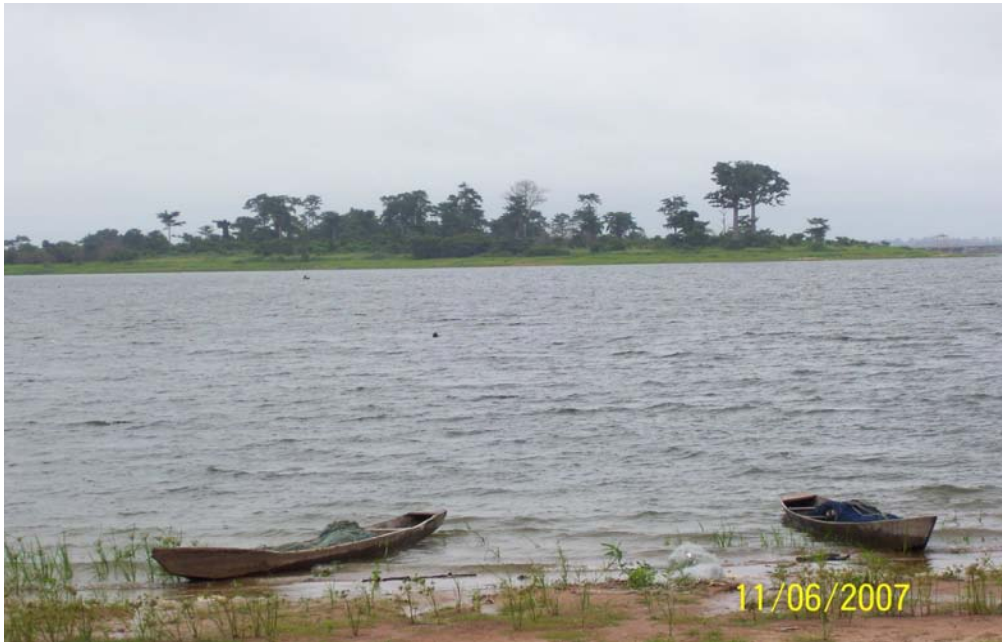
Photographie 10. Vue partielle de la station de Taabo-Cité, zone lacustre / côté droit de la digue.
