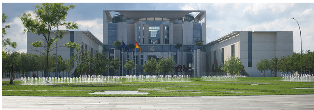
Figure 38 - Vue de l'intégralité de la façade de la nouvelle Chancellerie
