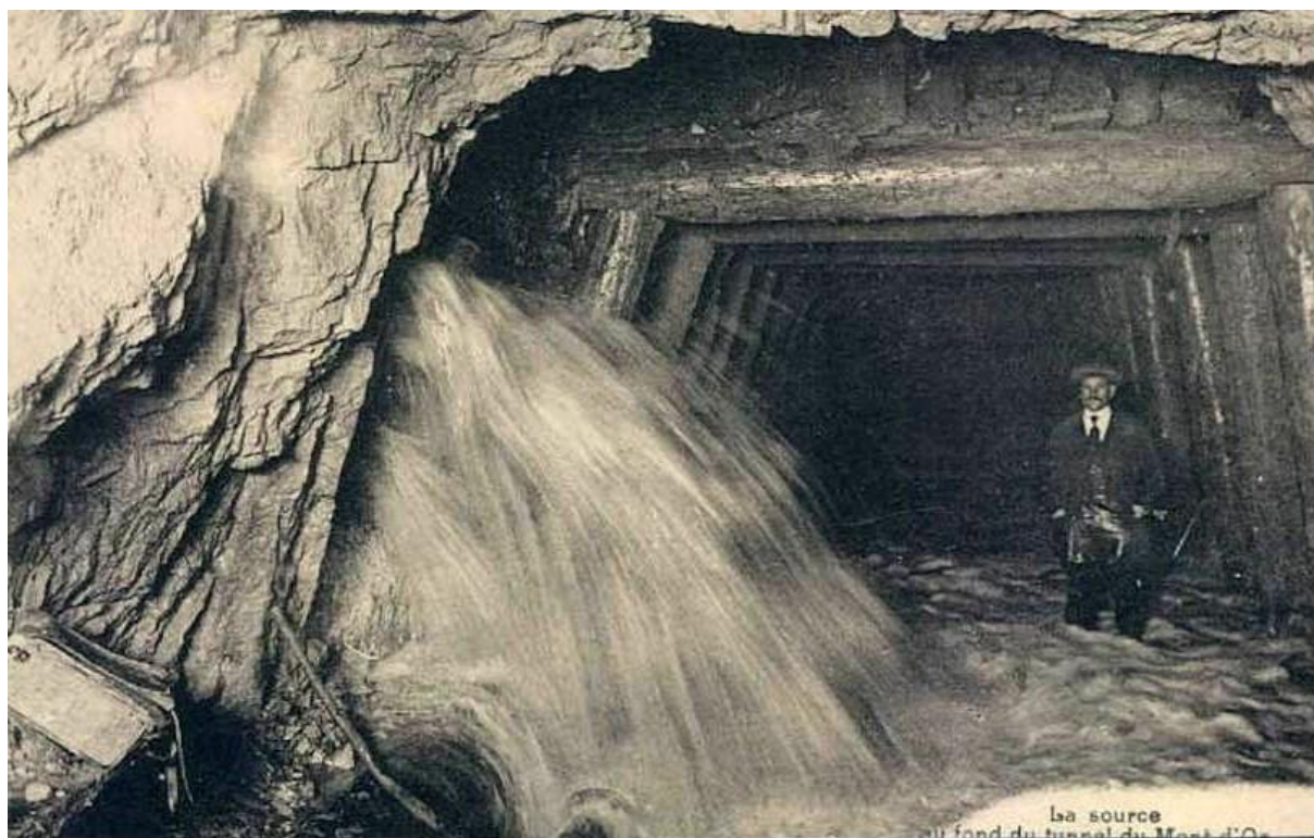
Figure 33 : Carte postale montrant une résurgence d'eau dans le cœur de l'anticlinal du Mont d'Or lors des travaux du tunnel ferroviaire sous le Mont d'Or dans les années 1910.
