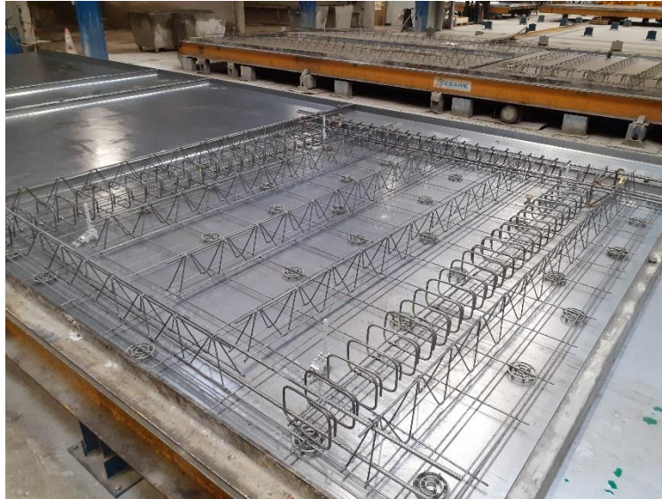
Figure 2.70 Table équipée prête pour le coulage du béton
