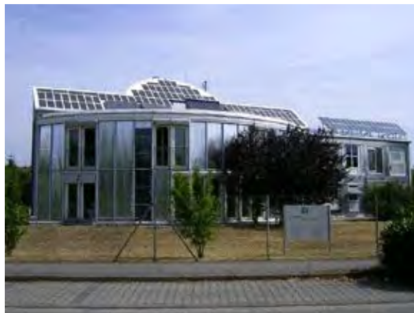
Fig 1-47 : Maison énergétiquement autonome de Freiburg
