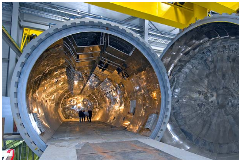
FIGURE 1.8 – Installation autoclave pour Airbus [16]
