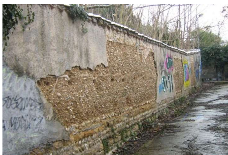
Illustration 124: Mur situé le long du passage Nièpce (Lyon 4 e , CL-136). Photo : service des Balmes de la ville de Lyon.
