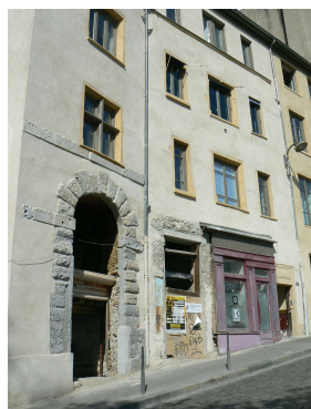
Illustration 105, 106 et 107 : Bâtiment de quatre niveaux situé au 24, montée Saint-Sébastien (CL-006, Lyon 1 er ). Pisé visible en façade sur rue pendant la réfection des enduits, trace de nombreuses modifications avec des matériaux variés : brique, moellon de pierre, bois. Photo de droite : pisé également repéré en niveau bas du mur de refend sud. Photos : A. Ménager (gauche) et E. Mille
