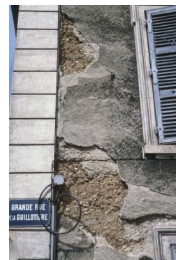
Illustrations 188 et 189 : Maison située au 255, Grande rue de la Guillotière (Lyon 7 e , CL-273). Élévation sur rue : vue générale et détail d'une lacune d'enduit (état en 1981). Photos : Inventaire général (à gauche) et A-S. Cléménçon (à droite).
