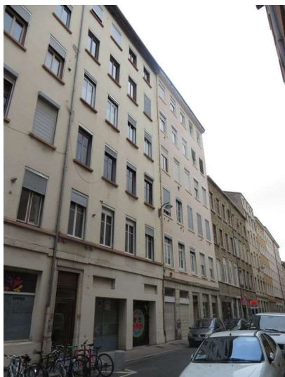
Illustration 151 : Façade sud des immeubles de 6 niveaux situés aux 1 et 3 rue de Nuits (Lyon 4 e , CL-166 et 168). Photo : E. Mille.
