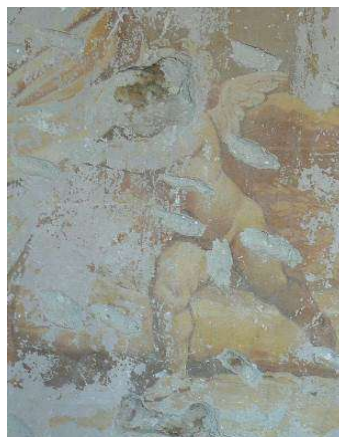
Illustration 41 : Clos de la Haye. Lacune du décor peint de la galerie rendant visible le support en pisé de terre. Photo : E. Mille (état en 2016).
