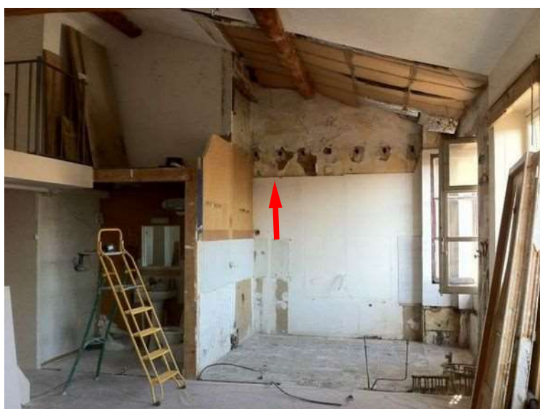
Illustrations 65 et 66 : Immeuble de trois étages situé au 12, rue Jacquard (Lyon 4 e ). Si la façade sur rue, très ouverte avec ses trumeaux fins et élancés, est vraisemblablement en pierre, des travaux menés à l'intérieur en 2015 ont relevé la présence de pisé de terre dans les murs mitoyens perpendiculaires à la rue.
