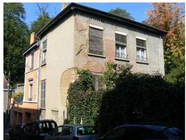
Illustration 60 : Maison située au 17, rue Royer, dans le Quartier Bissardon, à Caluire-et-Cuire. Pisé rendu visible par la chute de l'enduit, état en 2015.
