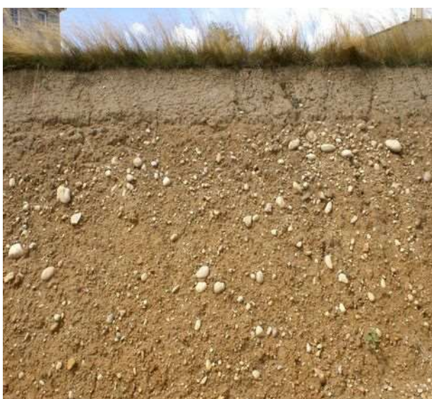
Illustration 7 : Coupe d'un terrain en Isère, présentant la superposition des différentes couches : végétation et terre organique en partie haute (quelques dizaines de centimètres), moraines glaciaires (mélange d'argile, de silts, de sables, de graviers et de cailloux) en partie basse (Photo : Patrice Doat, CRAterre).
