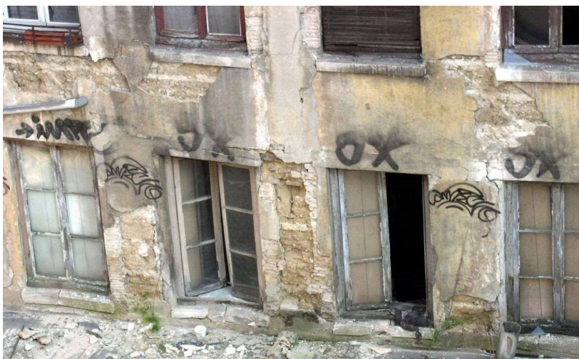
Illustration 136 : Immeuble situé au 17, rue Burdeau (Lyon 1 er , CL-008). Malgré la finesse des trumeaux, la façade semble entièrement en pisé. Photo : Service des Balmes de la ville de Lyon, état vacant avant destruction vers 2010, 200 ans environ après sa construction.
