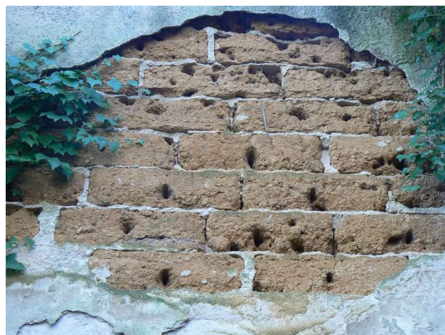
Illustration 163 : Détail d'un mur de clôture de l'ancienne clinique de Champvert (Lyon 5 e , CL-228). Photo : E. Mille.
