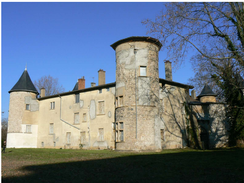
Illustration 90 : Façades extérieures Ouest et sud du château de la Motte, situé au 37, rue du Repos, dans le 7 e arrondissement de Lyon (CL-296). Photographie : E. Mille.
