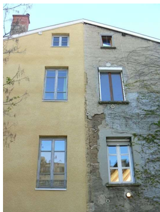
Illustration 256 : Pisé de terre visible en pignon sud des immeubles situés aux n°6 et 8. Photo : E. Mille.
