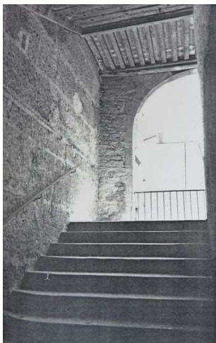
Illustration 144 : Immeuble du 4-6 rue Dumenge. Pisé du mur de la cage d'escalier visible lors de la réfection des enduits. Photo : Th. Monnet, 1990, p. 233.
