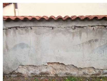
Illustration 96 : Mur de clôture au droit d'une limite parcellaire existant au XVIII e siècle et donnant sur l'actuel hôpital de la Croix-Rousse (103 Grande Rue de la Croix-Rousse, Lyon 4 e , CL-091). Photo : E. Mille
