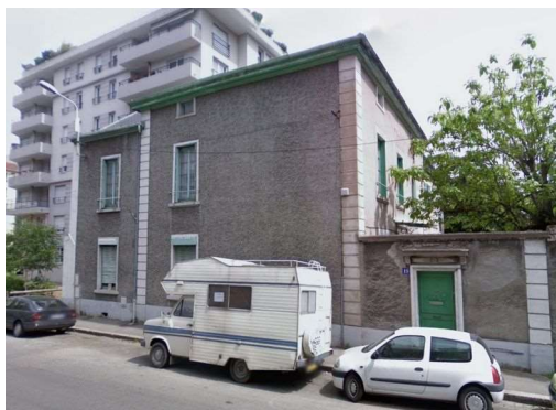
Illustration 187 : Maison située au 19, rue Cazeneuve (Lyon 8 e , CL-314). Photo : Google
