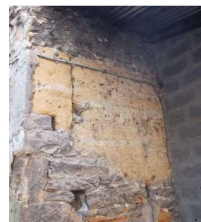
Illustration 125: Utilisation de loess dans un mur situé au 87 G de rue de la Croix-Rousse (CL-121).
