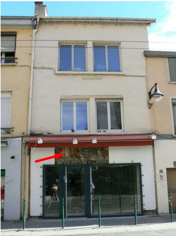
Illustration 57 : Maison située au 40, Grande rue de la Croix-Rousse, Lyon 4 e . Pisé rendu visible lors de la réfection de la devanture du commerce en 2016.
