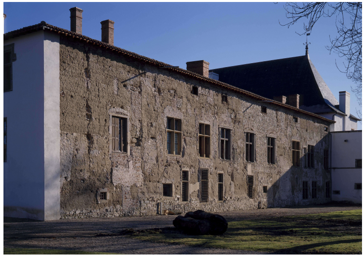
Illustration 31 : Saint-Étienne-le-Molard (42), château de la Bastie d'Urfé (XIV e -XVI e s.). Vue de la façade Est après piquage des enduits lors des travaux de restauration en 2000. Photographie : Eric Dessert, Inventaire général du patrimoine culturel, Région Auvergne-Rhône-Alpes
