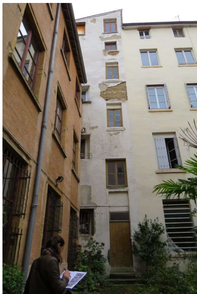
Illustrations 181 et 182 : Immeuble de trois étages situé au 15, rue Raymond (Lyon 1 er , CL-020). A gauche, façade sur rue (matériaux non identifiés). A Droite : façade sur cour avec des allèges de baies en pisé. Photos : M. Aulas.
