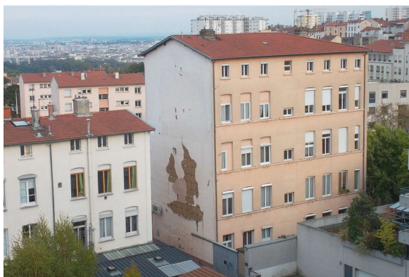
C : Immeuble de 5 niveaux, 43 rue Coste, Caluire (Photo : E. Mille).
