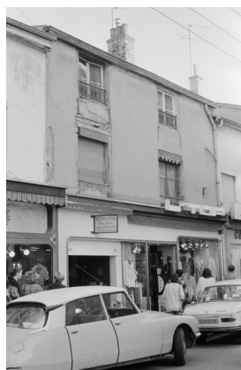
Illustration 103 et 104 : Bâtiment de deux niveaux situé au 38, Grande Rue de la Croix Rousse, Lyon 4 e (CL-97), dont l'emprise est datée de la fin du XVII e s. (Inventaire général). Les photos de 1983 montrent des encadrements en pierre au premier étage, et en bois au second. Photos : A-S. Cléménçon, in Bertin, Cléménçon, 1983, p. 88.
