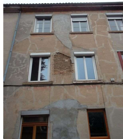
Illustration 137 : Immeuble de 3 niveaux situé au 2, montée de l'Observance (Lyon 5 e , CL-218). Façade sur rue, détail d'un trumeau en pisé. Photo : E. Mille.
