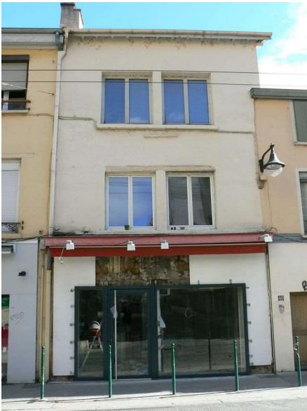
Illustration 108 et 109 : Bâtiment de trois niveaux situé au 40, Grande Rue de la Croix Rousse, Lyon 4 e (CL-098), dont l'emprise est datée de la fin du XVII e s. La réfection de la devanture montre le pisé et les traces (poutre métallique et bouchement en maçonnerie) de la reprise en sous-œuvre réalisée au XIX e ou au XX e siècle) afin d'agrandir la baie commerciale. Photos : E. Mille.
