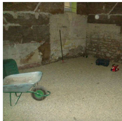
Illustration 257 : Pisé visible lors de travaux en rez-de-chaussée du n°4. Photo : IPPL.
