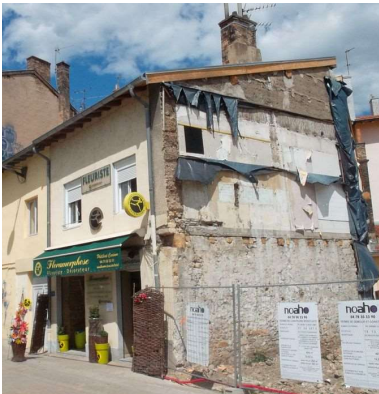
Illustration 128 : Bâtiment d'un seul étage situé au 9, rue des Tanneurs (Lyon 4 e , CL-349). Photo : E. Mille
