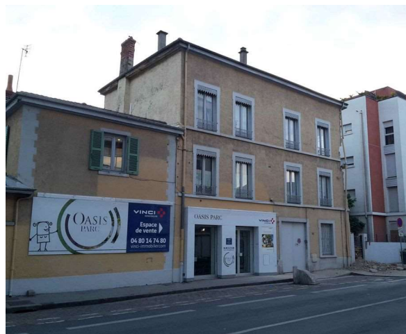
Illustration 175 : Immeuble de deux étages situé au 166, route de Vienne (Lyon 8e, CL-312). État avant démolition en 2017. Photo : G. Paccoud, CRA-terre.
