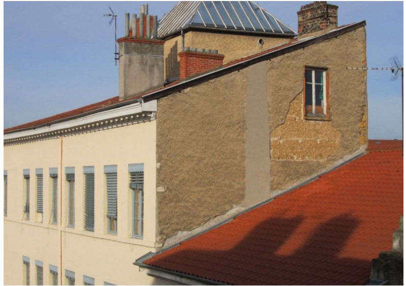
Illustrations 206 et 207 : Immeuble situé au 1, rue Pailleron (Lyon 4 e , CL-201). A gauche, façades ouest (sur la Grande rue de la Croix-Rousse) et sud (sur la rue Pailleron), photo : E. Mille. A droite, détail du pisé visible en pignon est, photo : Service des Balmes de la Ville de Lyon.
