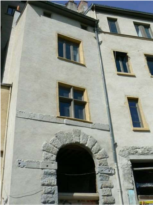
Illustration 69 : Immeuble situé au 24 montée St-Sébastien (Lyon 1 er ). Vue en 2017, après restauration.
