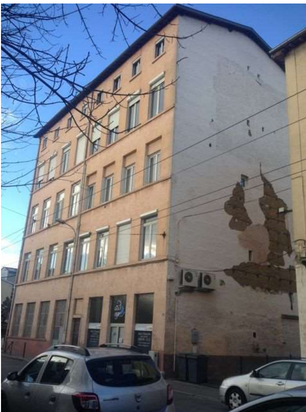
Illustration 71 : Immeuble au 43 rue Coste (Caluire-et-Cuire). Façade sur rue et pignon nord (photo : L. Fontaine, CRAterre, 2016).
