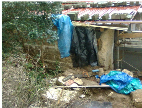
Illustration 273 : Élévation en pisé de terre d'un mur de clôture en partie médiane d'un îlot, situé au 10, rue Gigodot (4 e arr., CL-167).
