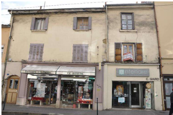
Illustration 112 : Immeuble situé au 32-34, Grande rue de la Croix-Rousse (CL-096). Photo : Inventaire général du patrimoine.
