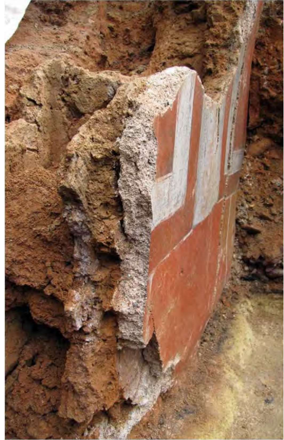
Illustration 23 : Détail d'une cloison en terre, Lyon, Clos de la Solitude. Source : Clément B. 2016, p. 414).
