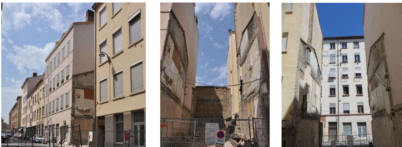
Illustrations 196, 197 et 198 : Ensemble d'immeubles situés aux 23, 25 et 27, rue du Mail (CL-178, 179 et 180). A gauche, élévation sur rue (photo : A-S. Cléménçon). Au centre, état des murs mitoyens après démolition des bâtiments du n°25 (photo : A-S. Cléménçon). A droite, pignons des n°23 et 27 ; en face, immeuble du 1, rue de Nuits, dont le pignon nord présente également du pisé (Photo : E. Mille).
