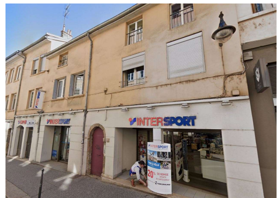
Illustration 113 : Immeuble situé au 84, Grande rue de la Croix-Rousse (CL-119). Photo : Google.
