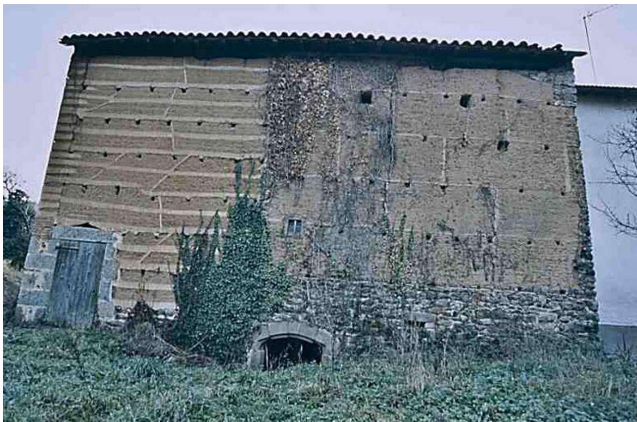
Illustration 43 : Juxtaposition de deux types de mise en œuvre du pisé à deux époques différentes. A droite, joints verticaux et lits de chaux, probablement du XVII e siècle. A gauche, joints inclinés et multiplication des lits de chaux dans les angles et à mi-hauteur de banchée, vers 1900. Grange située à Débats-Rivière-d'Orpra (plaine du Forez, département de la Loire). Photographie : C. Guibaud , Inventaire général du patrimoine culturel, Région Auvergne-Rhône-Alpes (Guibaud, 2005).
