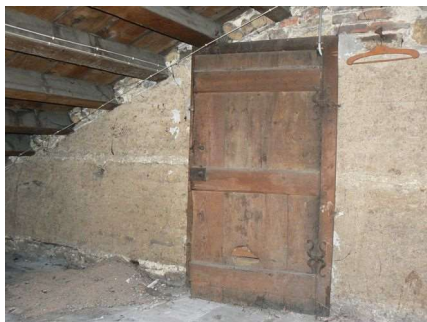
Illustration 168 : Bâtiment ouest de l'ancienne clinique de Champvert (Lyon 5 e , CL-226). Détail d'un mur de refend en pisé situé dans les combles. Photo : E. Mille.
