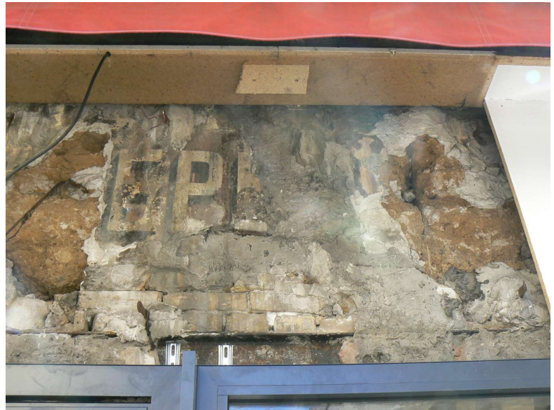
Illustration 108 et 109 : Bâtiment de trois niveaux situé au 40, Grande Rue de la Croix Rousse, Lyon 4 e (CL-098), dont l'emprise est datée de la fin du XVII e s. La réfection de la devanture montre le pisé et les traces (poutre métallique et bouchement en maçonnerie) de la reprise en sous-œuvre réalisée au XIX e ou au XX e siècle) afin d'agrandir la baie commerciale. Photos : E. Mille.
