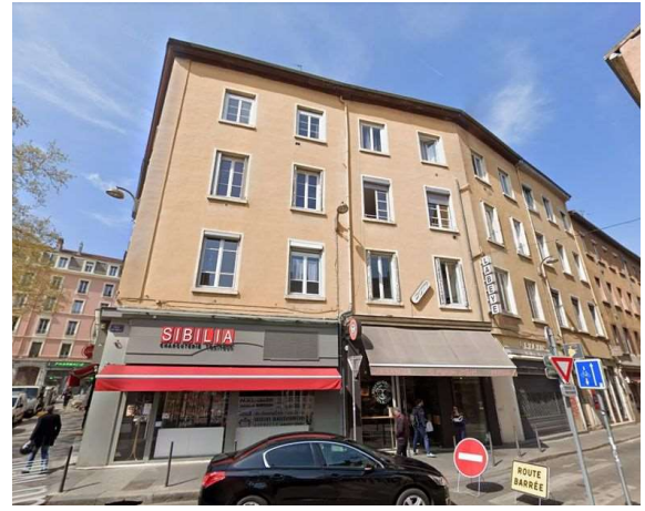
Illustration 147 : Vue depuis la rue du Mail. Façade latérale du 12, place de la Croix-Rousse et façade du 1, rue du Mail. Photo : Google
