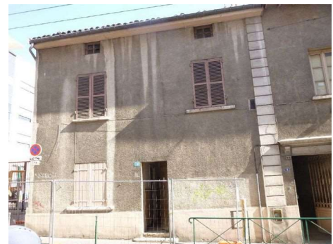
Illustration 133 : Bâtiment de deux niveaux avec entrée centrale situé au 10, rue Hénon (Lyon 4 e , CL-192). Photo : Service des balmes de la ville de Lyon.
