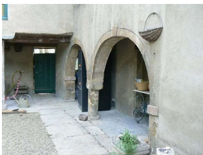
Illustration 97 : Maison bourgeoise (ancienne maison de vigneron ?) dont la majeure partie des murs est en pisé, située au 12 rue Fayolle, Lyon 9 e (CL-357). Photo : E. Mille
