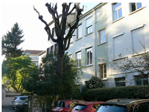
Illustration 253 : Façade sud des immeubles situés aux numéros 1 et 3 de l'impasse Dubois (Photo : E. Mille).
