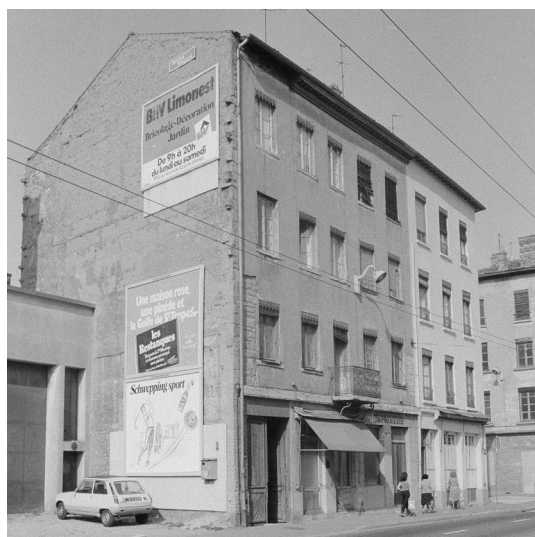
Illustration 139: Immeuble de 4 niveaux situé au 56, rue Marietton (Lyon 9 e , CL-366). Pignon ouest (en pisé) et façade sur rue. Photo : A-S. Cléménçon.
