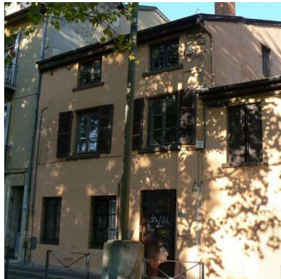
Illustration 129 : Bâtiment de deux étages situé au 28, rue de Cuire (Lyon 4 e , CL-159). Photo : E. Mille
