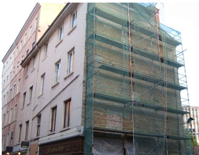
Illustration 138: Immeuble de 4 niveaux situé au 8, rue d'Austerlitz (Lyon 4 e , CL-154). Pignon ouest (en pisé) et façade sur rue. Photo : Inventaire général du patrimoine.
