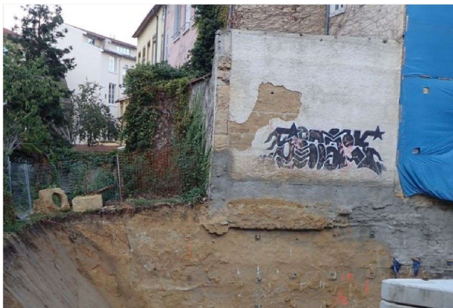
Illustration 272 : Élévation mitoyenne en pisé de terre du rez-de-chaussée d'un ancien bâtiment en fond de cour situé au 16, rue Duroc (1 er arr., CL-016). Photo : St. Gaillot, SAVL.
