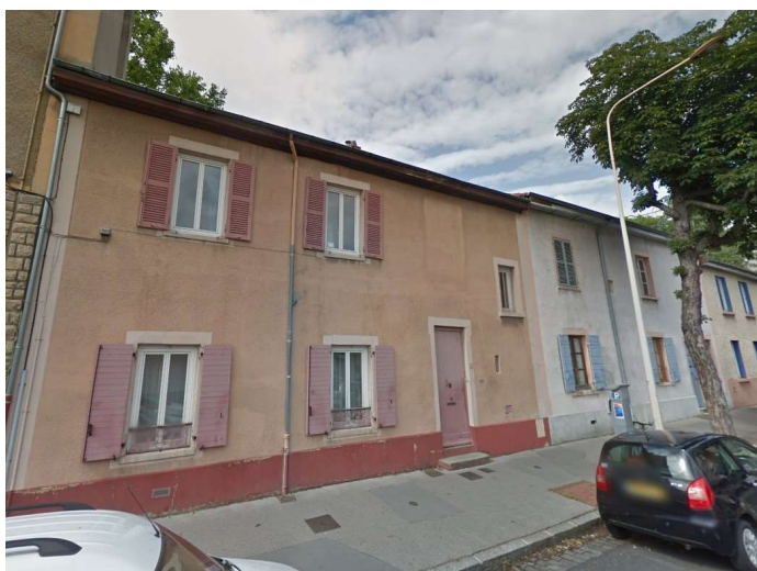
Illustration 238: Bâtiment situé au 10, rue Trouilhet (Lyon 8 e , CL-327). État en 2014, avant surélévation d'un étage. Photo : Google.
