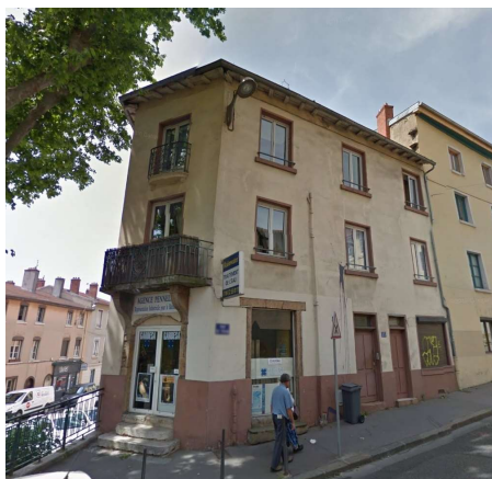
Illustration 117 : Ancien Hôtel des Macchabées, construit par Cointeraux, situé au 2, rue des Macchabées, Lyon 5 e (CL-244). Photo : Google.
