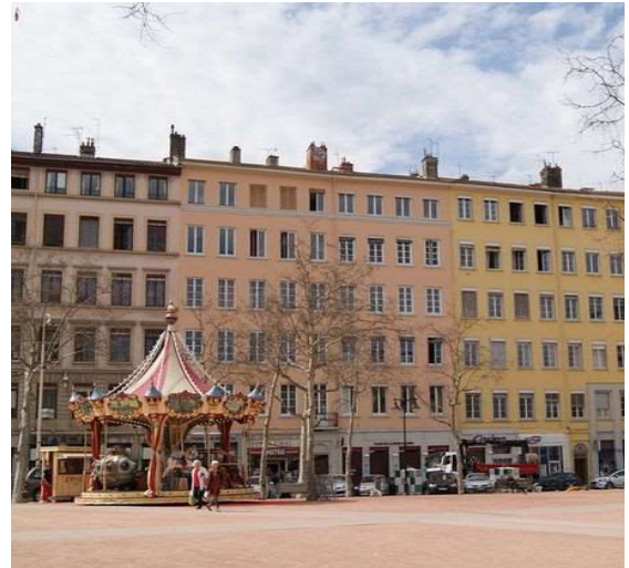
Illustration 141: Immeuble de 6 niveaux situé au 1, place de la Croix-Rousse (Lyon 4 e , CL-138). Photo : E. Mille.
