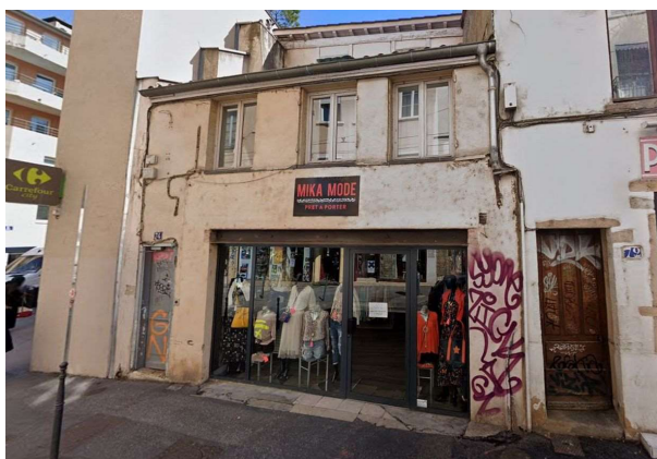
Illustration 102 : Bâtiment de deux niveaux situé au 74, Grande Rue de la Croix Rousse, Lyon 4 e (CL-111), dont l'emprise est datée du XVI e s. (Barre, 1988), malgré d'évidentes modifications de façade (notamment la poutre métallique en rez-de-chaussée). Photo : Google.
