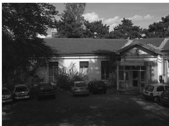
Illustration 227 : Bâtiment V de l'Hôpital de la Croix-Rousse, situé au 103, Grande rue de la Croix-Rousse (Lyon 4 e , CL-090). Photo : SRI.
