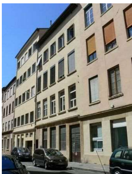
Illustrations 65 et 66 : Immeuble de trois étages situé au 12, rue Jacquard (Lyon 4 e ). Si la façade sur rue, très ouverte avec ses trumeaux fins et élancés, est vraisemblablement en pierre, des travaux menés à l'intérieur en 2015 ont relevé la présence de pisé de terre dans les murs mitoyens perpendiculaires à la rue.
