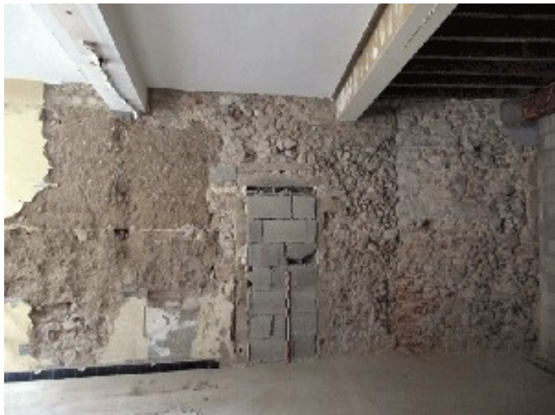
Illustration 39 : Site de l'Antiquaille : Angle nord-ouest de l'ancienne maison des Buatier (fin du XVI e siècle) et mur en pisé englobés dans le couvent des Visitandines (XVII e siècle). Source : Service Archéologique de la Ville de Lyon.
