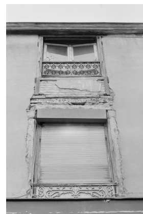
Illustration 103 et 104 : Bâtiment de deux niveaux situé au 38, Grande Rue de la Croix Rousse, Lyon 4 e (CL-97), dont l'emprise est datée de la fin du XVII e s. (Inventaire général). Les photos de 1983 montrent des encadrements en pierre au premier étage, et en bois au second. Photos : A-S. Cléménçon, in Bertin, Cléménçon, 1983, p. 88.
