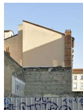
Illustrations 191 et 192 : Immeuble de trois niveaux situé au 24, rue Saint-Michel (Lyon 7 e , CL-297). Vue aérienne et détail du pisé en pignon sud. Photos : Google (à g.) et Inventaire général (à dr.).
