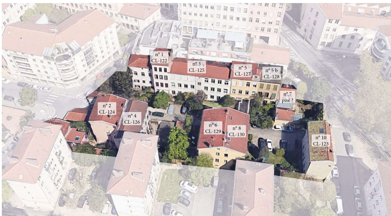
Illustration 252 : Vue aérienne depuis le sud (source : Google) de l'impasse, présentant les dispositions du bâti et repérant les numéros de voirie et de fiches de corpus.
