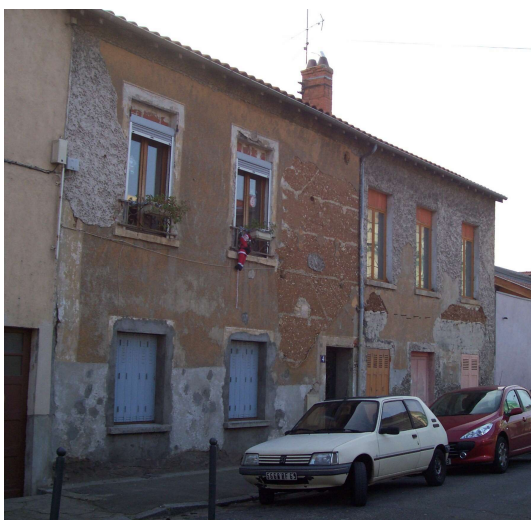
Illustration 237: Façade sur rue en pisé au 4, rue Jean Cardona (Lyon 3 e , CL-059). Photo : Inventaire participatif du patrimoine en pisé lyonnais.
