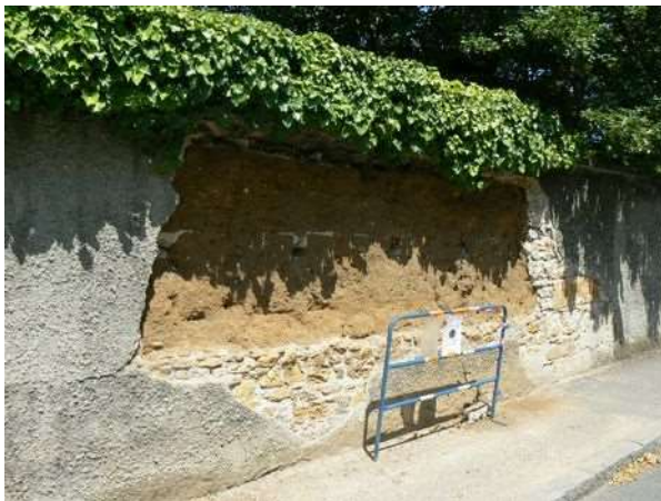
Illustration 59 : Mur situé rue de la Gare, dans le quartier de Cuire-le-haut, à Caluire-et-Cuire. Pisé identifié en 2015 lors de la chute de l'enduit.
