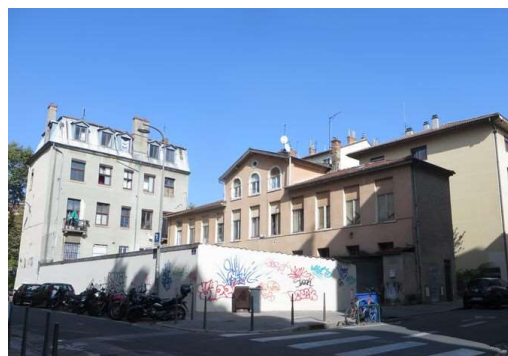
Illustration 190 : Immeuble de deux niveaux situé au 1, rue de Crimée (Lyon 1 er , CL-009). Photos : E. Mille
