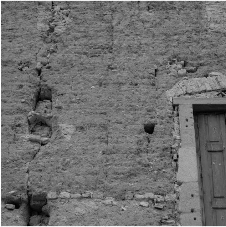
Illustration 32: Saint-Étienne-le-Molard (42), château de la Bastie d'Urfé, détail de la façade ouest, pisé daté du XIV e s. Joints verticaux et absence de lits de chaux, trou de clef de banche. Photographie : Jean-Marie Refflé, Inventaire général du patrimoine culturel.
