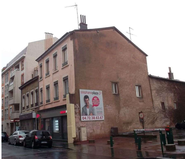
Illustration 172 : Immeuble de deux étages situé au 75, rue de Trion (Lyon 5 e , CL-239). Photo : E. Mille
