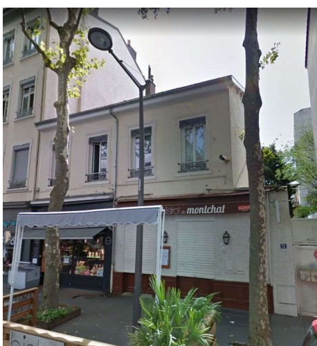
Illustration 232: Bâtiment d'un étage situé au 72, cours du Docteur Long (Lyon 3 e , CL-025). Photo : Google.
