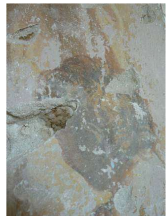
Illustration 42 : Clos de la Haye. Lacune du décor peint de la galerie rendant visible le support en pisé de terre. Photo : E. Mille (état en 2016).
