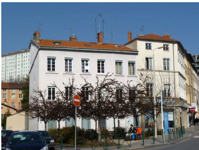
Illustration 174 : Immeuble de deux étages situé au 16, rue Benoist-Mary (Lyon 5e, CL-225). Photo : S. Moriset, CRA-terre.
