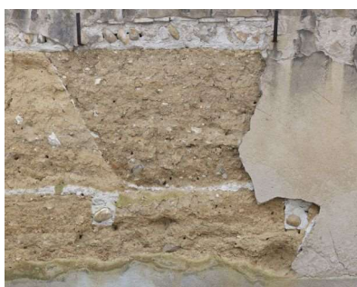
Illustration 94 : Détail du mur de clôture de l'ancien prieuré de Génovéfains, au droit d'une limite parcellaire existant au XVIII e siècle (montée des Génovéfains, Lyon 5 e , CL-224). Photo : Inventaire général du patrimoine.
