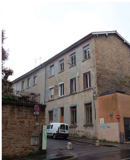
Illustration 158 : Immeuble de 3 niveaux situé au 2, montée Loyasse (Lyon 5e, CL-218). Photo : E. Mille
