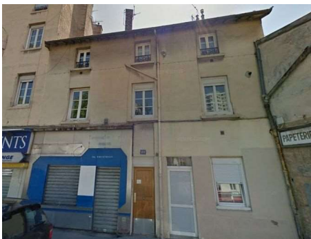
Illustration 131 : Immeuble de trois niveaux situé au 160, Grande rue de la Guillotière (Lyon 7 e , CL-265). Photo : Google.
