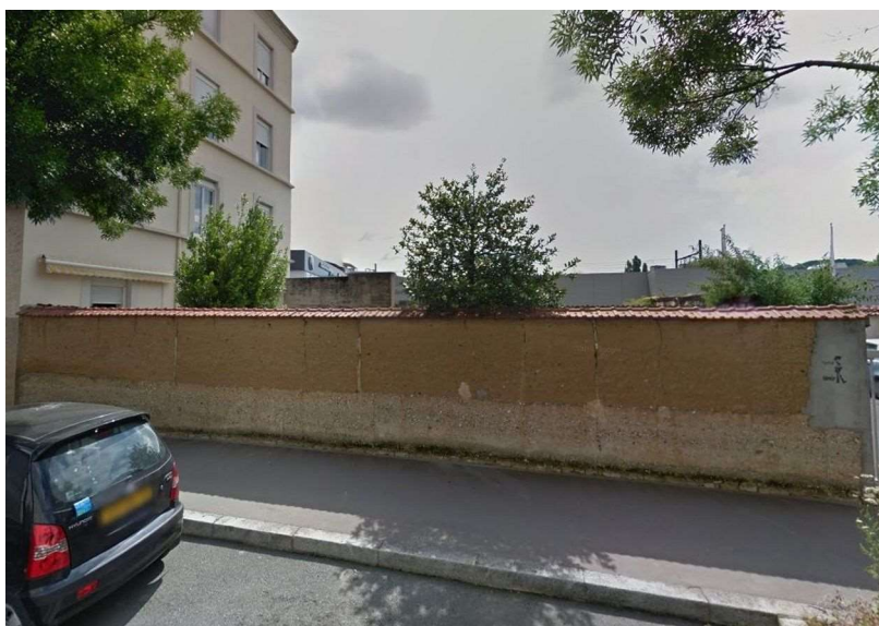
Illustration 220: Mur de clôture situé rue du Cèdre (Lyon 9 e , CL-353). Photo : Google.
