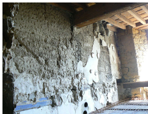
Illustration 105, 106 et 107 : Bâtiment de quatre niveaux situé au 24, montée Saint-Sébastien (CL-006, Lyon 1 er ). Pisé visible en façade sur rue pendant la réfection des enduits, trace de nombreuses modifications avec des matériaux variés : brique, moellon de pierre, bois. Photo de droite : pisé également repéré en niveau bas du mur de refend sud. Photos : A. Ménager (gauche) et E. Mille
