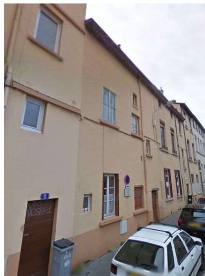
Illustration 173 : Immeuble de deux étages situé au 3, impasse Gord (Lyon 4 e , CL-132). État avant surélévation. Photo : Google, 2009.
