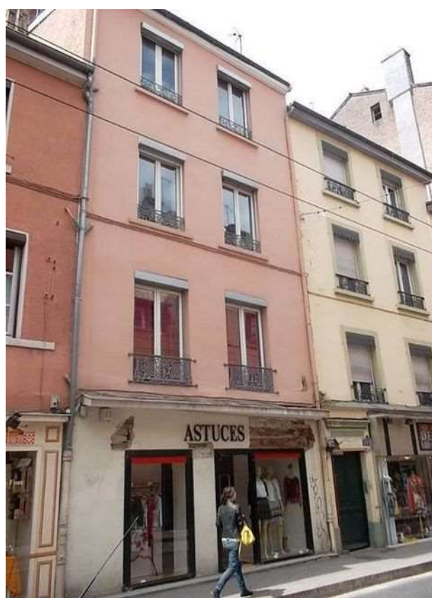
Illustration 68 : Immeuble de quatre niveaux situé au 67, Grande rue de la Croix-Rousse (Lyon 4 e ).
