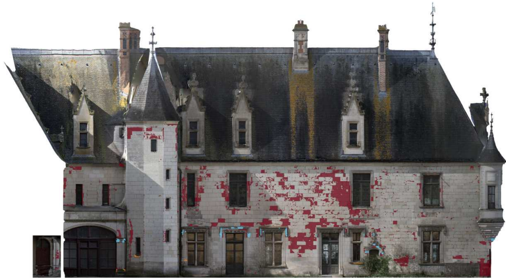
FIGURE 3.1 – Exemple d'annotations d'altérations réalisées manuellement par les experts en patrimoine : desquamation en plaque (annotée en rouge), desquamation en feuillet (annotée en orange), érosion (annotées en bleu clair) et pelage (annotées en rose clair).
