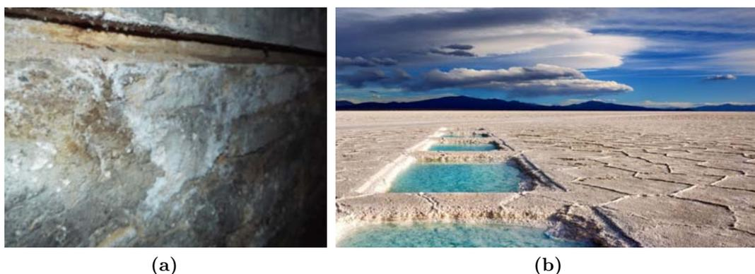
**Figure 1.7.** – Exemples de formation d'efflorescences. **(a)** : Dans la paroi interne d'un bunker à Juno Beach en Normandie, nous pouvons apercevoir des cristaux qui couvrent partiellement la surface du béton armé. **(b)** : Dans le désert de sel de Salinas Grandes à Jujuy en Argentine un ancien lac d'eau salée et actuellement en exploitation, nous pouvons remarquer des structures salines qui forment un pavage hexagonal sur toute la surface du désert<sup>1</sup>.
