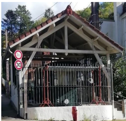
Figure 116 : Gare basse où se trouve la voiture 2 restaurée.
