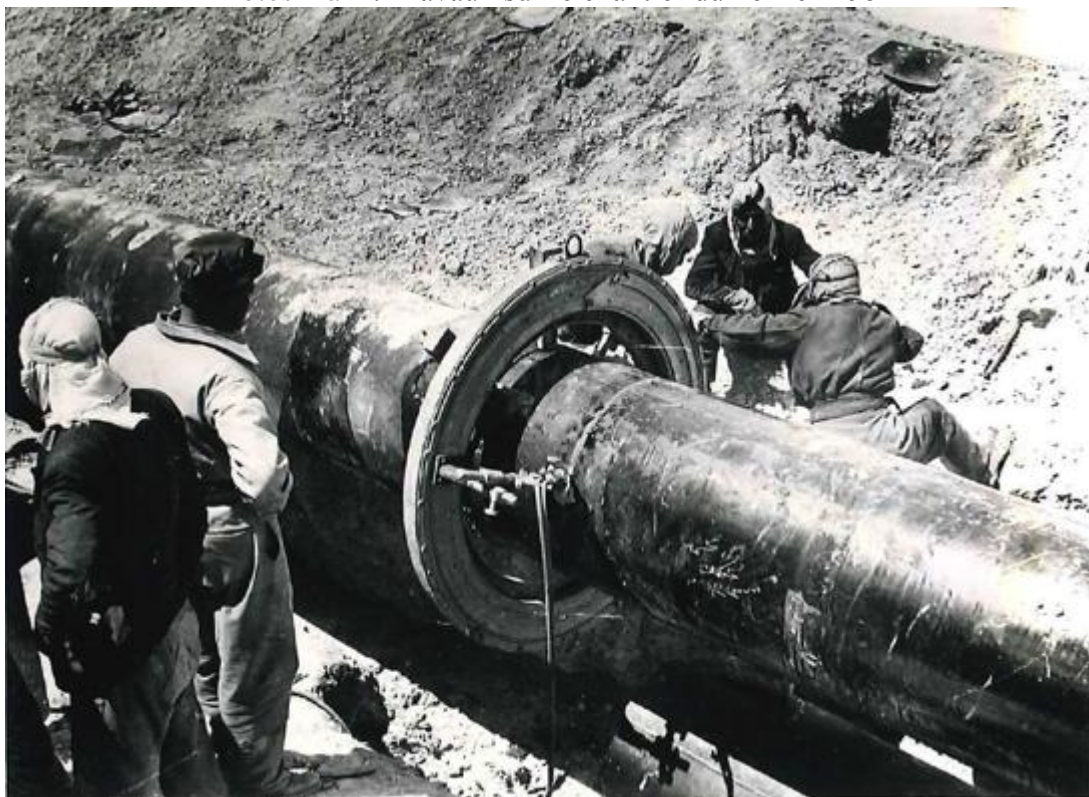
Photos 2 à 4 : Travaux sur le chantier du 26'' en 1951
