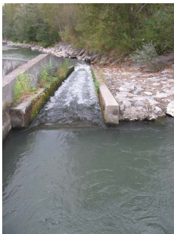
FIGURE 1.2 – Exemple de passe à ralentisseurs à Baudreix sur le Gave de Pau (photo : Dominique Courret).
