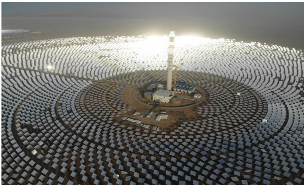
Figure 2 : Exemple de centrale à tour d'une capacité de 100 MW située dans le désert de Gobi à Dunhuang, Chine [12].
