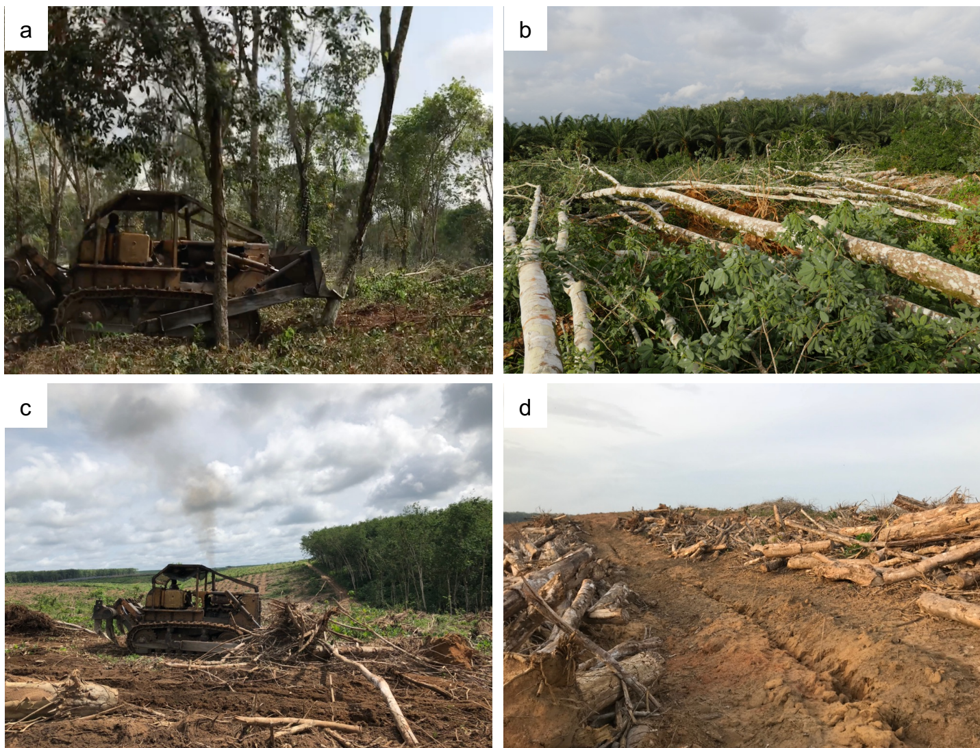
Photo 10 : « La replantation : un fonctionnement du sol perturbé ». Différentes étapes de la phase de replantation : abattage d'un vieux peuplement au bulldozer (a), résidus d'abattage laissés sur place après la coupe rase (b), andainage des résidus d'abattage dans la future interligne (c) et parcelle après le sous-solage à une dent avec les résidus d'abattage andainés dans l'interligne (d).
