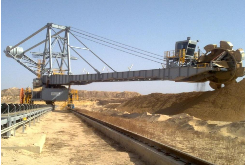
Figure 1-6 : Déstockage du phosphate à l'aide d'une roue-pelle
