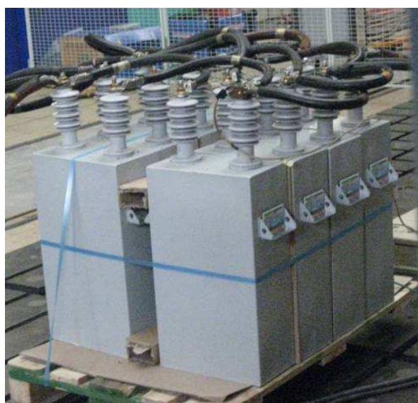
figure V.4 : Photo des condensateurs du filtre LC série de la maquette
