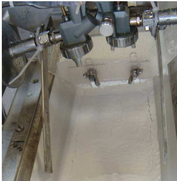
FIG. D.4: Photographie des buses de lavage du filtre.
