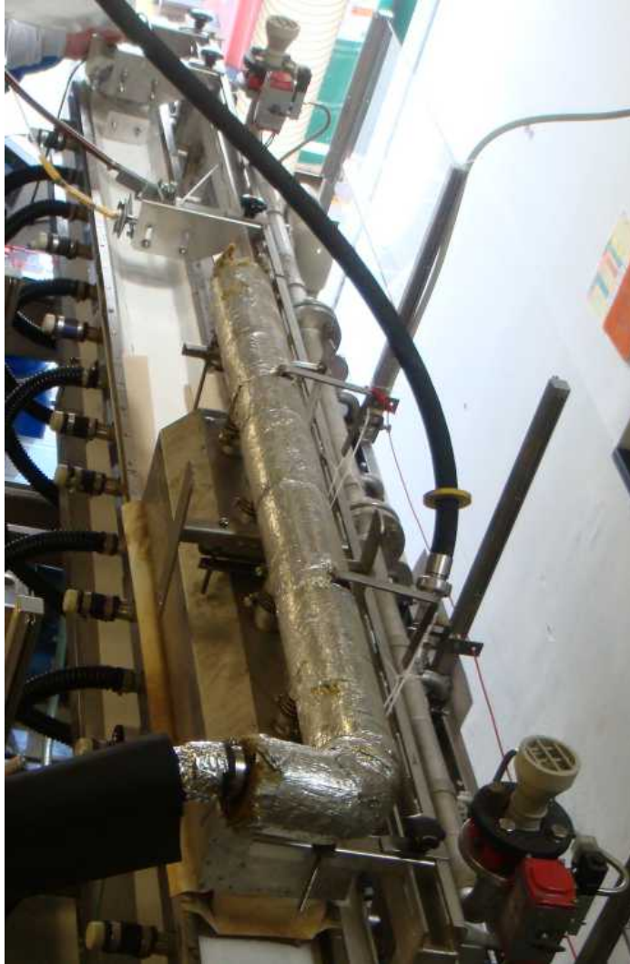
FIG. D.2: Photographie de l'ensemble du filtre.
