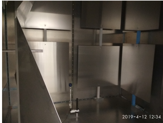
FIGURE 5.2 – Système de plaques métalliques dans l'enceinte d'une CRBM.
