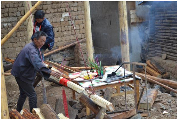
Photographie 24 - Hissage de la poutre faîtière symbolique (Wumu, 2018 - Photo ©Emmanuelle Laurent)
