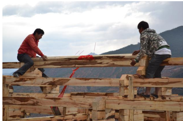
Photographie 23 - Fixation de la poutre faîtière symbolique au sommet de la charpente (Wumu, 2018 - Photo ©Emmanuelle Laurent)
