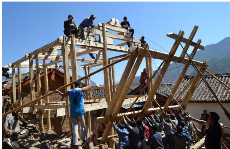
Photographie 26 - Dressage de charpente chez A-Qiang (Wumu, 2018 - ©Emmanuelle Laurent)
