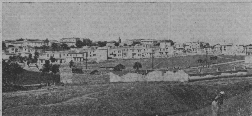
Le bel aspect des constructions du foyer des anciens combattants de Sétif (Isly-Photo).
