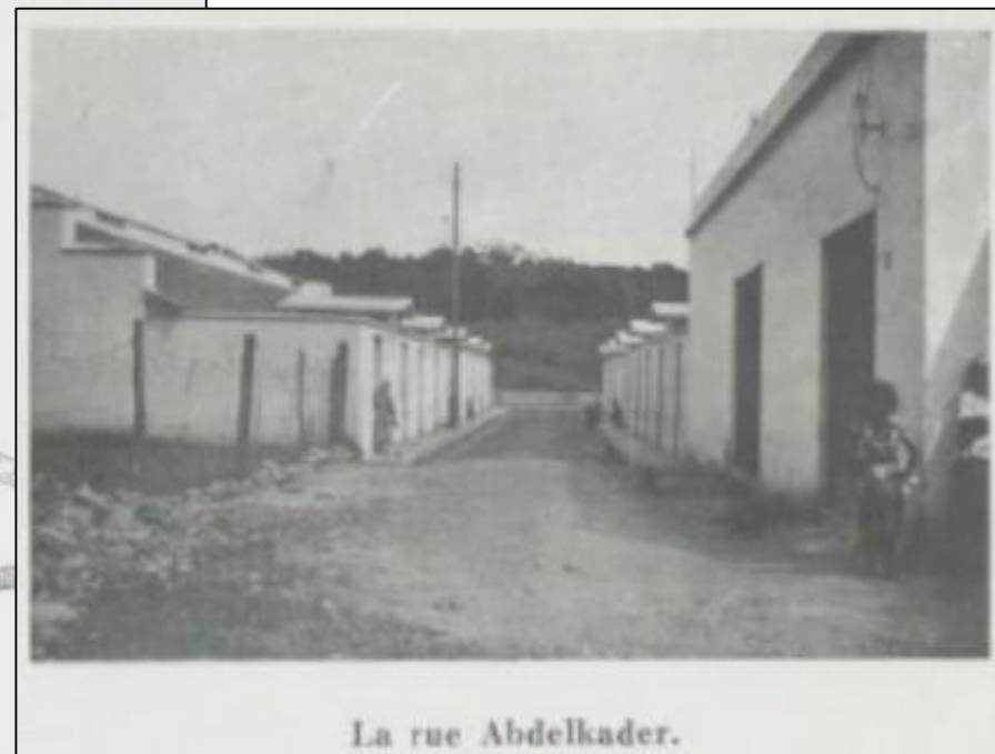
Photographie 23 – Staoueli, « cité indigène » (constructions achevées en octobre 1931)
