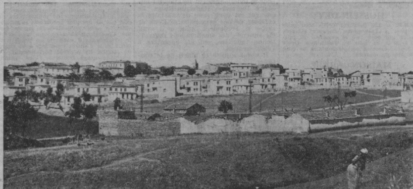
Le bel aspect des constructions du foyer des anciens combattants de Sétif (Isly-Photo).
