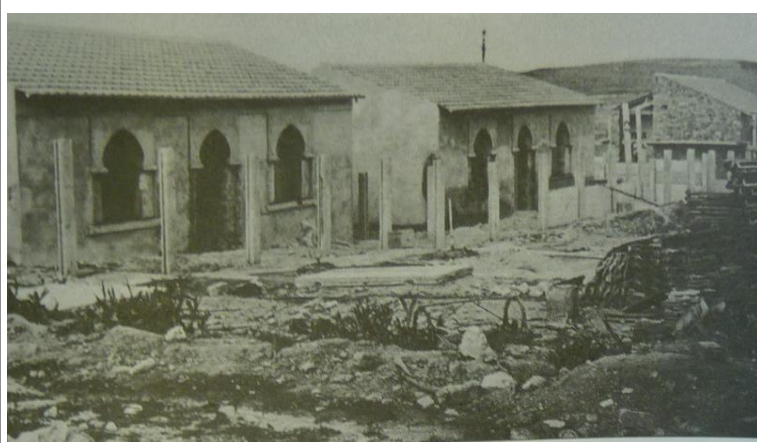
Photographie 4-5 – La cité Bel Air en construction, s.d.
