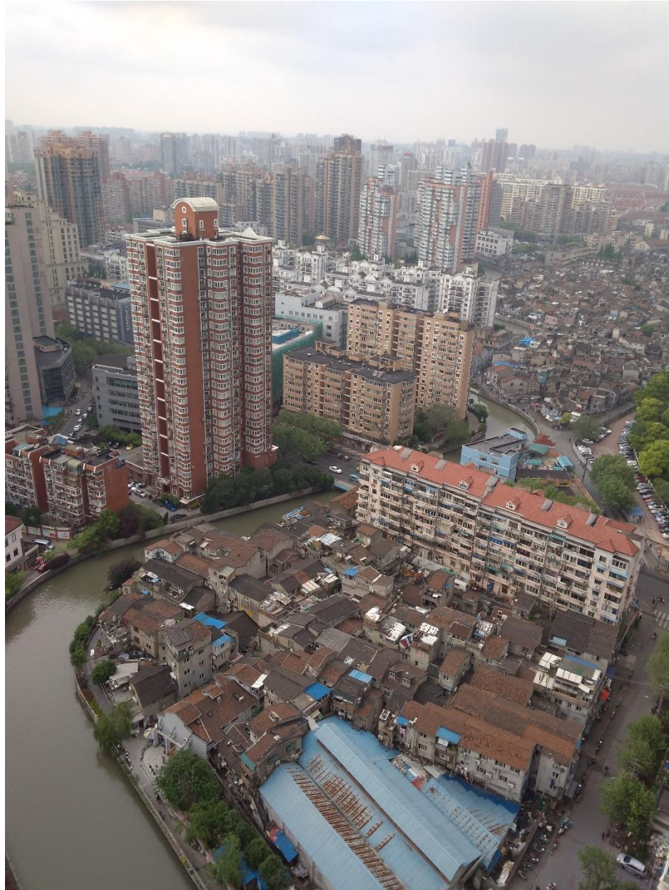
Vue d'un quartier shanghaien en cours de destruction
