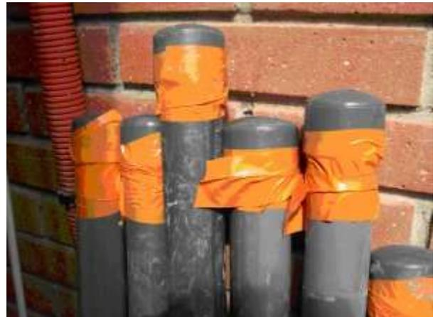
**Figure 36 : Bouchons assurant la limitation des échanges gazeux**
