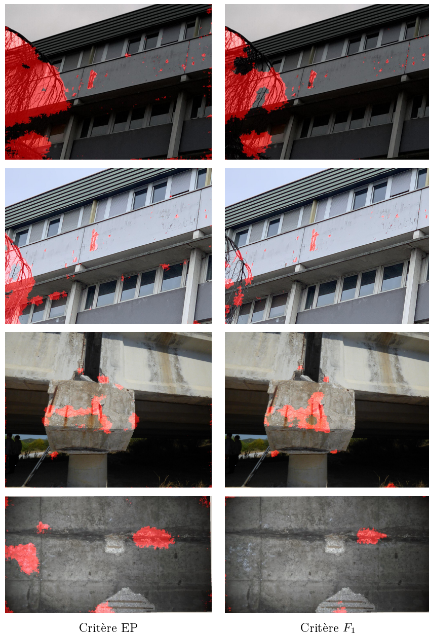
FIGURE 6.2 – Prédications du modèle appris sur le tunnel piéton – 1 ère ligne : Bâtiment universitaire (S); 2 ème ligne : Bâtiment universitaire (A); 3 ème ligne : CODEBRIM; 4 ème ligne : Rive-de-Gier.
