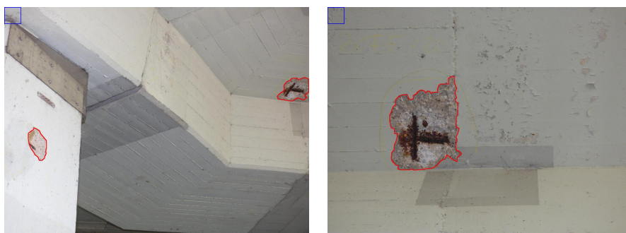
(b) Exemples issus de la base CODEBRIM (pris à l'échelle 1/4)
