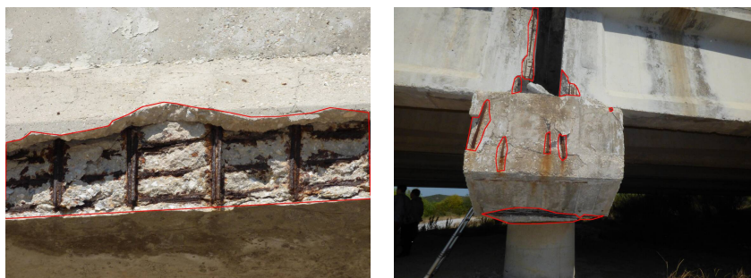
FIGURE 5.11 – Résultats obtenus pour la base CODEBRIM selon trois facteurs d'échelle – 1 ère ligne : vérité terrain (les fers apparents sont détournés en rouge).
