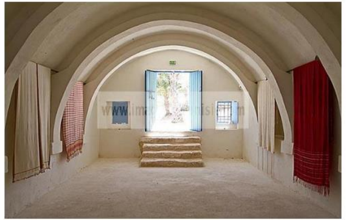
Figure 230 (de gauche) : les arcs-doubleau transversaux de Dar Martin. Source : Magazine : Maisons de Tunisie (2009)
