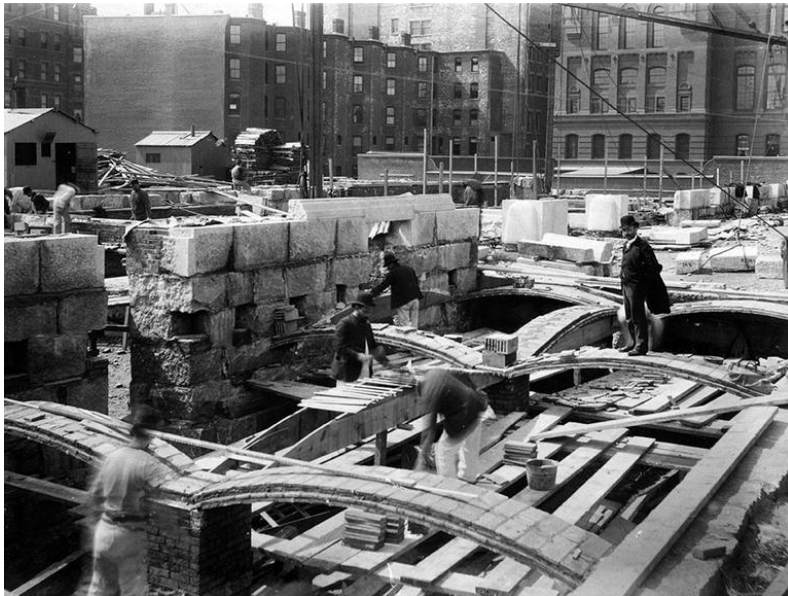
Figure 58: Photo montrant la présence de Rafael Guastavino sur chantier. Source : wbur.org/news/2013/01/10/guastavino-boston-library
