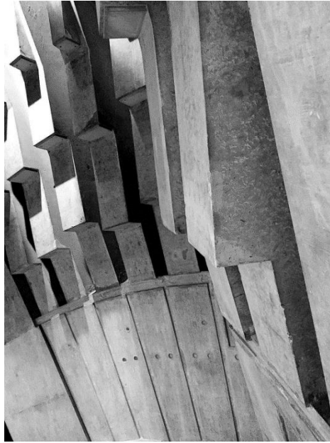
Figure 13: Détail de la fondation de la structure de la coque dans le hall principal d'Opéra de Sydney construit entre 1958 et 1973 montrant la répétition d'un système structurel basée sur des éléments de constructions identiques. Source : https://www.researchgate.net/publication/354537059_Tectonic_ecologies_in_Architecture
