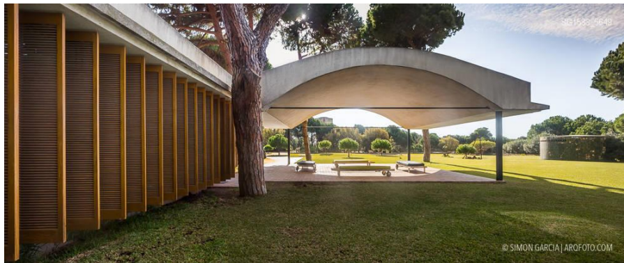
Figure 19: Image montrant l'ensemble presque flottant de la maison et les façades de la résidence qui sont libres de tout rôle structurel devenant ainsi tantôt des toiles de verre avec des treillis en céramique, tantôt des brise-soleils. Source : pinterest.es/pin/146437425369555543/
