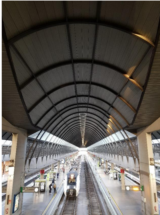
Figure 52: Gare ferroviaire Santa Justa à Séville. Source : photo de l'auteure (2021).
