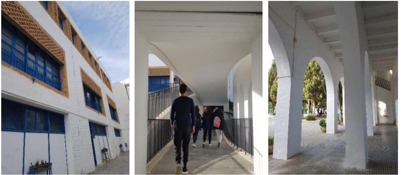
Figure 220: (allant de gauche à droite) : Photos montrant le claustra, la rampe, et les galeries d'arcades dans le projet. Source : photos personnelles.
