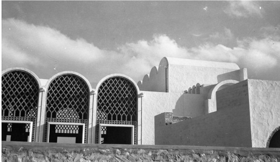
Figure 246: Photo montrant les claustras habillant les arcs. Source : expositions-virtuelles.citedelarchitecture.fr/EXPO-ZEHRFUSS/01-PARTIE-DOC15.html
