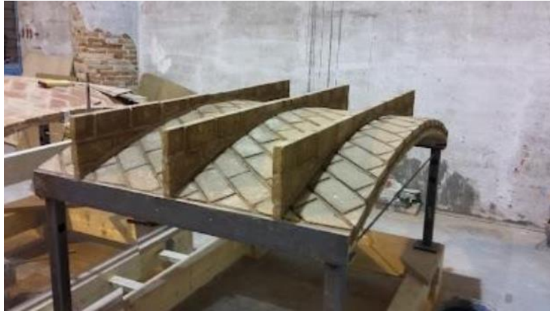
Figure 78: La voûte en BTC. Source : bovedacatalana.blogspot.com.
