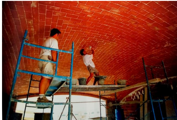
Figure 72: Photo montrant un atelier de peintres couvert par une large voûte qui s'étend sur 16m de long, construit par Jordi Domenech. Source : Livre : New traditional architecture, p.55.
