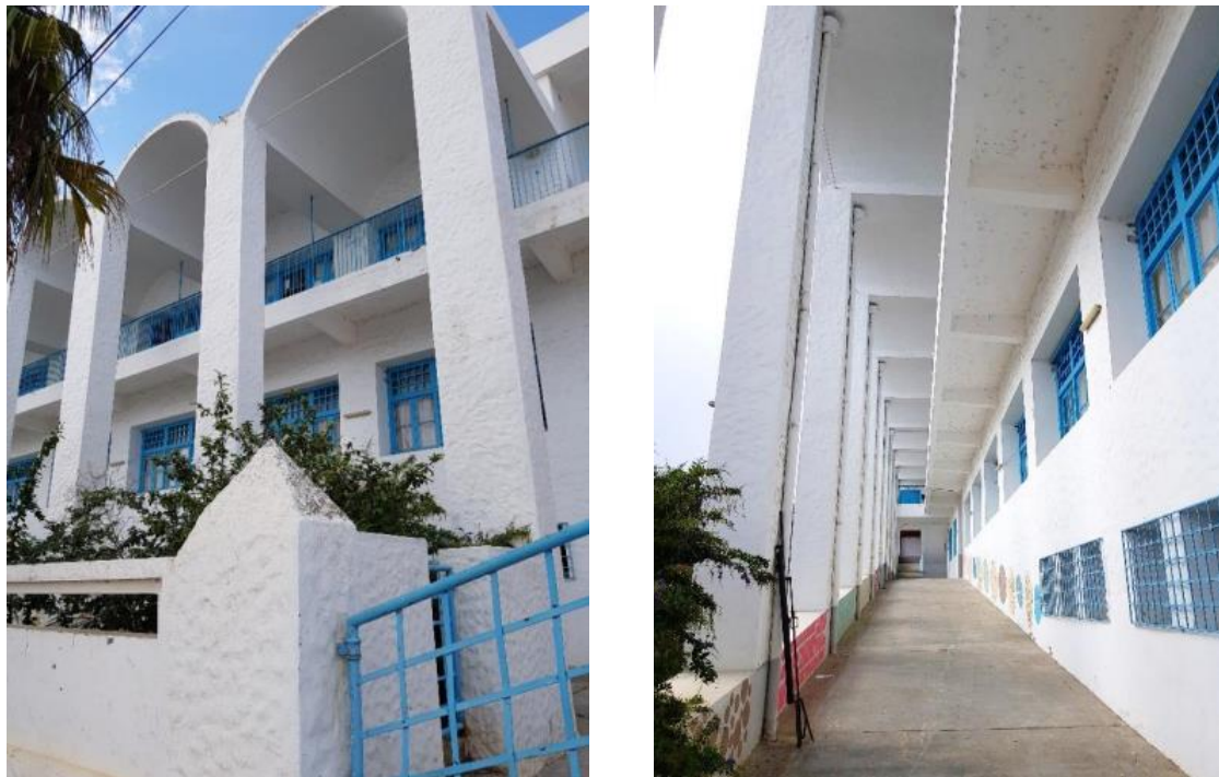
Figure 238: (allant de gauche à droite) : Photos illustrant le passage d'échelle de l'extérieur vers l'intérieur grâce à la rampe et la coursive de l'étage. Source : auteure (2019)
