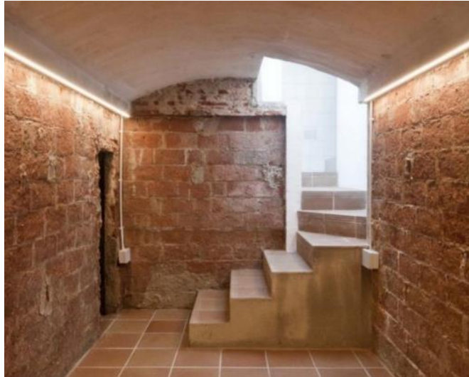
Figure 74: Vue intérieure de la maison (2017). Source : arcstudi.com/17sj
