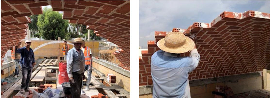
Figure 197: Photos montrant la participation des différents corps du métier sur le chantier et le montage de la voûte sans coffrage. Crédit photos : Pol Guillard.
