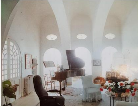
Figure 230 (de gauche) : les arcs-doubleau transversaux de Dar Martin. Source : Magazine : Maisons de Tunisie (2009)
