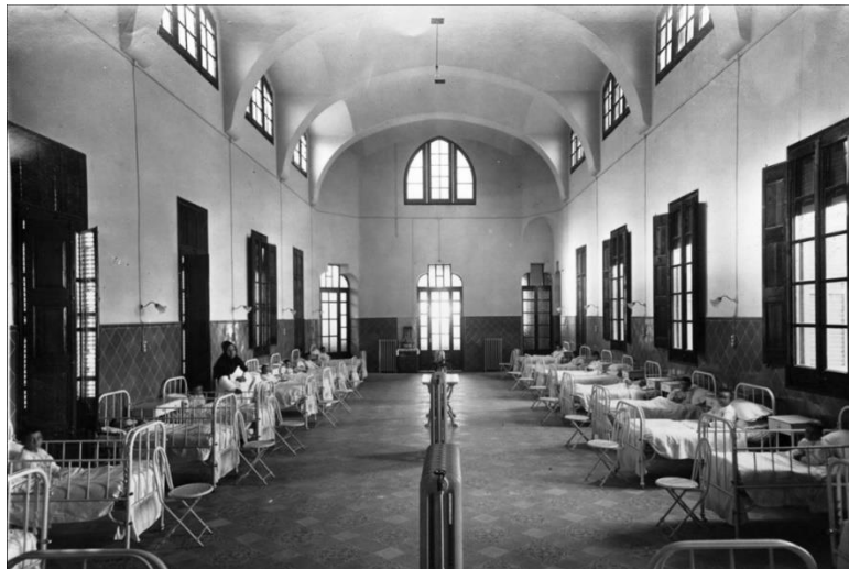
Figure 62: Hôpital de San Pablo à Barcelone construit avec des voûtes en tuiles cloisonnées de Domenech i Muntaner. Source : irbarcelona.org/barcelona-famous-buildings/recinte-modernista-hospital-sant-pau/
