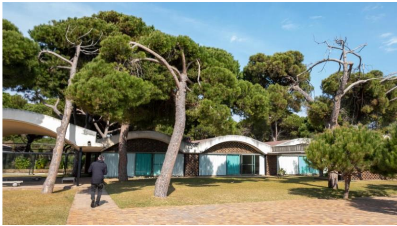
Figure 18 : La maison se situe entre une expression rythmique et presque classique des voûtes qui déterminent une expression rationnelle, et un dialogue harmonique avec son environnement naturel. Source : www.lavanguardia.com/local/baix-llobregat/20210323/6604582/govern-declara-cultural-interes-nacional-ricarda-prat-llobregat-casa-gomis.html
