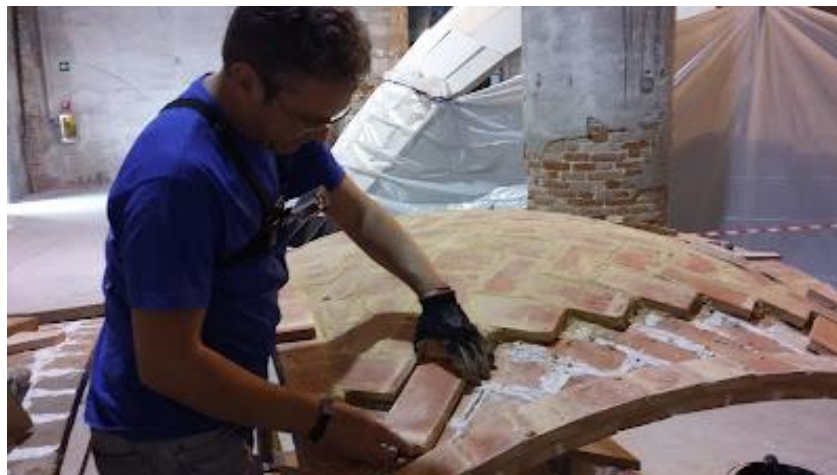
Figure 77: Salvador Gomis Avino en train de réaliser la voûte traditionnelle en céramique. Source : bovedacatalana.blogspot.com .
