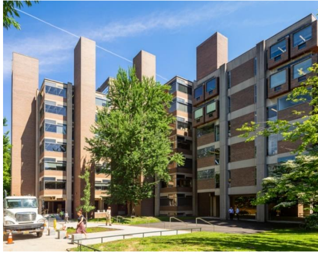
Figure 17: Centre de recherches médicales Newton-Richards, Pennsylvanie aux États-Unis, montrant l'utilisation de la structure creuse à toutes les échelles comme générateur potentiel de l'espace intérieur et extérieur. Source : sosbrutalism.org/cms/18801956
