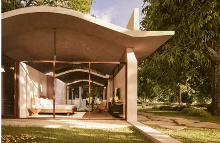
Figure 145: Une photo de la maison montrant une clarté du système constructif préfabriqué. Source : revue GA houses 2021.
