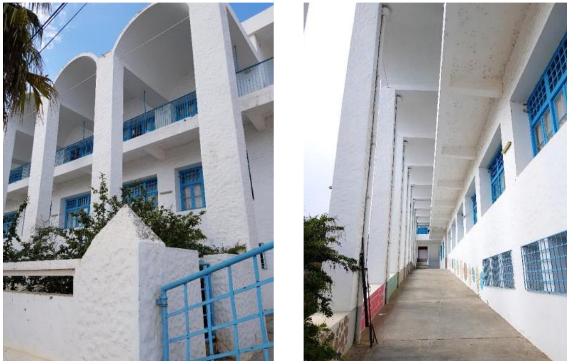
Figure 238: (allant de gauche à droite) : Photos illustrant le passage d'échelle de l'extérieur vers l'intérieur grâce à la rampe et la coursive de l'étage. Source : auteure (2019)
