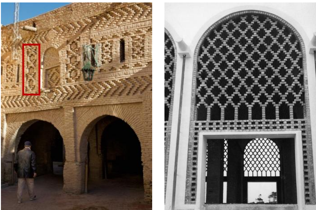
Figure 247 (Photo de gauche) montrant les briques pleines percées de petites fentes à Tozeur. Source : aramcoworld.com/Articles/May-2020/Brickwork-in-the-Land-of-Palms . Interprétation des formes et des couleurs : auteur.
