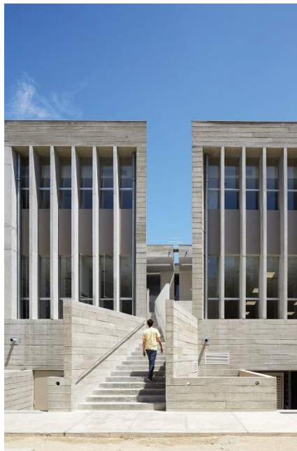
Figure 124 : Photo exposant une des entrées de l'université. Source : barclaycrousse.com/#/university-facilities-udep/
