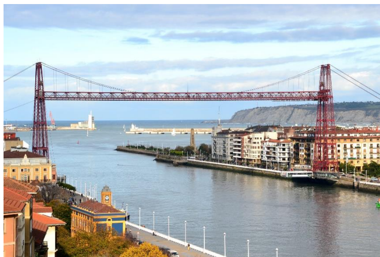
Figure 47: Le pont de Biscaye à Bilbao. Source : https://commons.wikimedia.org/wiki/File:Bizkaia_zubia_-_Puente_Bizkaia.jpg
