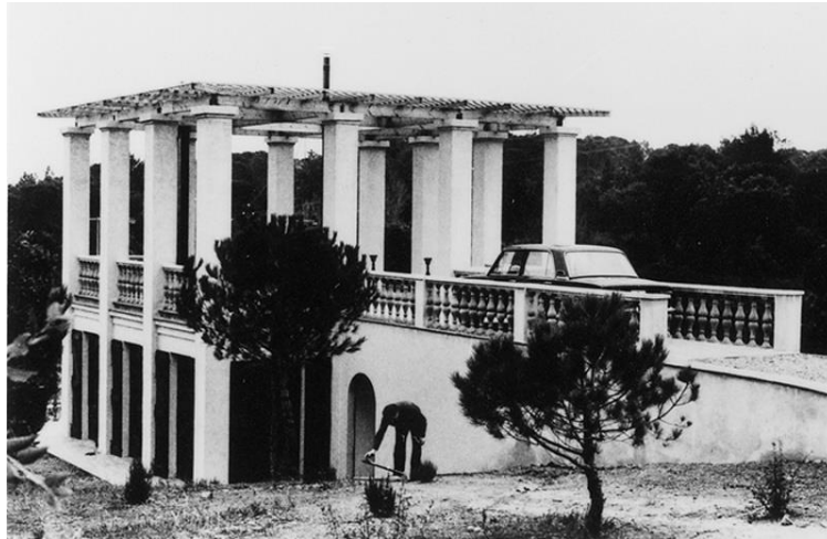
Figure 28: La Georgina Belvédère. Source : arquitecturacatalana.cat/es/obras/belvedere-georgina
