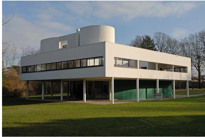
Figure 99 : Villa Savoie, Le Corbusier. Source : villa-savoie.fr/en/Explore/History-of-the-monument
