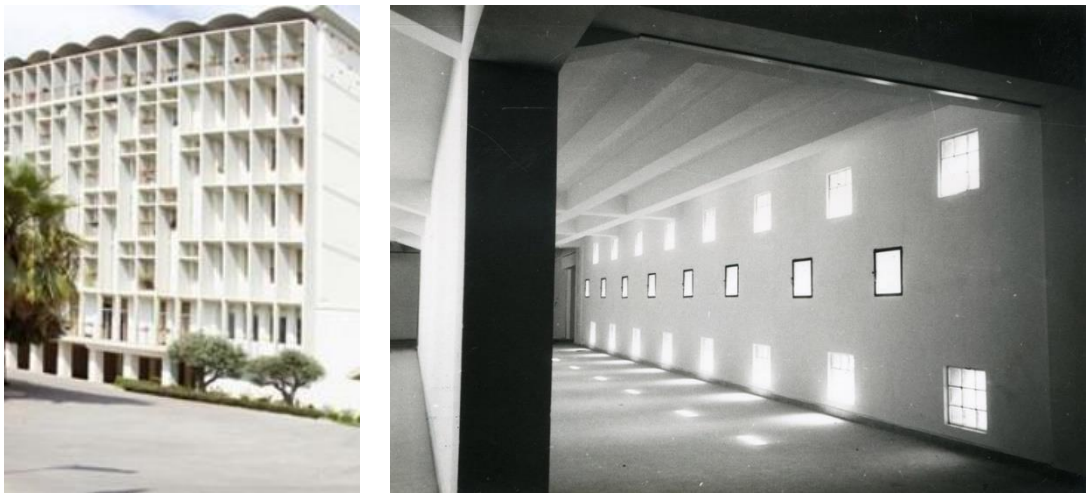
Figure 212 (de gauche) : photo d'une élévation de la régie qui nous fait rappeler la cité radieuse de Le Corbusier à Marseille. Source : google.com/imgres?imgurl=https%3A%2F%2Fwww.rltt.com.lb%2FDocumentImages
