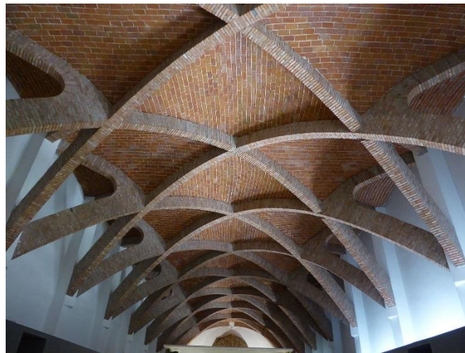
Figure 66: Photo du musée de l'Amérique à Madrid (1954) par Luis Moya représentant le système constructif des voûtes en tuiles pas très couteux. Source : ommons.wikimedia.org/wiki/File:Bóveda_tabicada .
