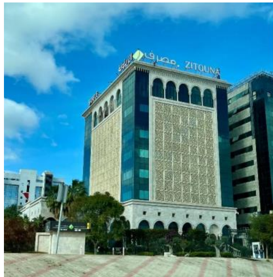
Figure 188: Photo d'une banque à Tunis (2009) présentant des éléments traditionnels sur la façade : arcs, moucharabiehs, colonnes avec du verre comme matériau moderne. Source : photo de l'auteure (2022).
