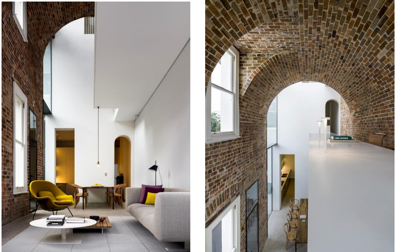
Figure 138: Photos montrant la double hauteur de la voûte en brique. Source : dettorrearchitects.com.au/italianate-house-surry-hills
