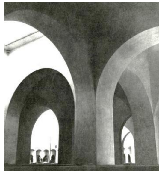
Figure 172: Une vue sur la voûte d'arête dans le marché de Bizerte Zarzouna (1945-1946) réalisé par Bernard Zehrfuss, Jean Drieu La Rochelle et Jason Kyriacopoulos. Source : expositions-virtuelles.citedelarchitecture.fr/ EXPO-ZEHRFUSS/01-PARTIE-DOC04.html
