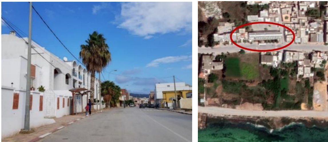
Figure 233: Photos montrant l'emplacement de l'école à Ghar El Melh, Bizerte. Sources (photo de gauche) : auteure (2019), (photo de droite) : Google Earth (2021)
