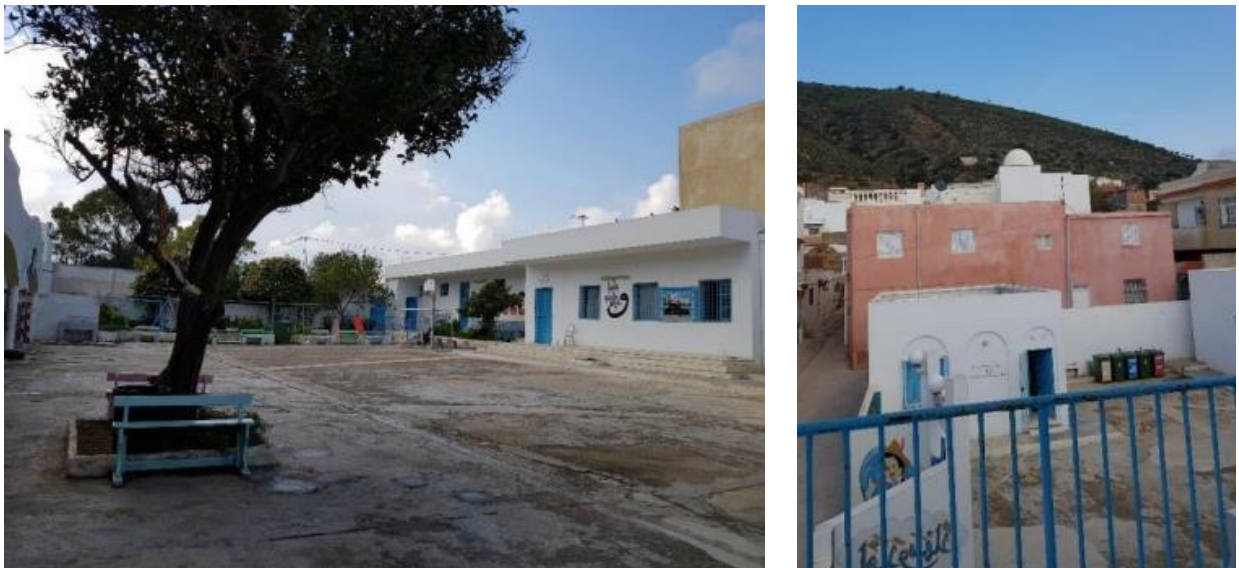
Figure 242: Photos montrant l'extension de l'école. Source : auteure (2019).
