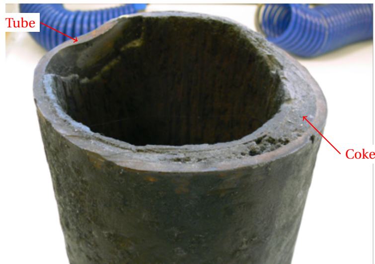
FIGURE 8: Dépôt de coke dans un tube de four de raffinerie
