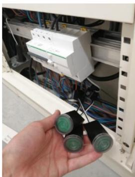
**Figure 4.15.** Photos de l’installation des capteurs E-Cube ZB35A0 pour la lampe UV mercure (triphasée) directement sur le tableau électrique.
