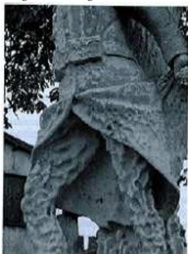
Dégradation due au sel d'un statue près de la Rochelle Rijijiers et al, Magnetic Resonance Imaging , vol.3, 273-576(2005)
