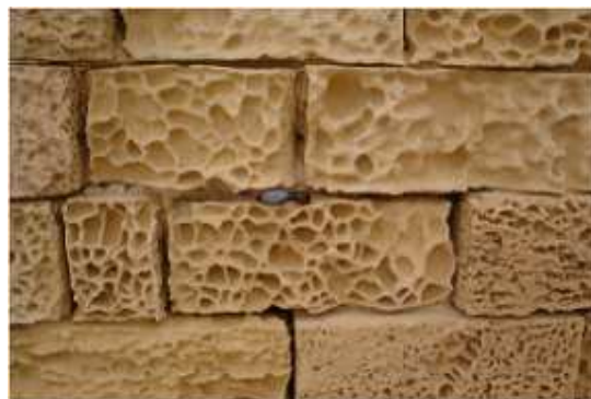
Alvéolisation induite par des cycles de cristallisation http://en.wikipedia.org/wiki/weathering
