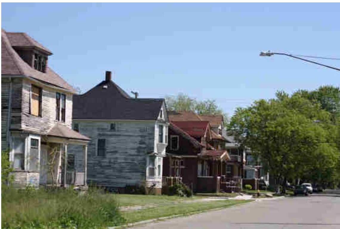
Canfield Street, une rue de Jefferson-Mack bordée de maisons unifamiliales, abandonnées pour la plupart.
