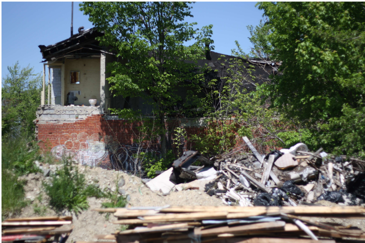
Une maison abandonnée et en ruine à Jefferson-Mack, désossée, envahie par la végétation et bordée d'une décharge sauvage. Source : F. Paddeu, 2012.
