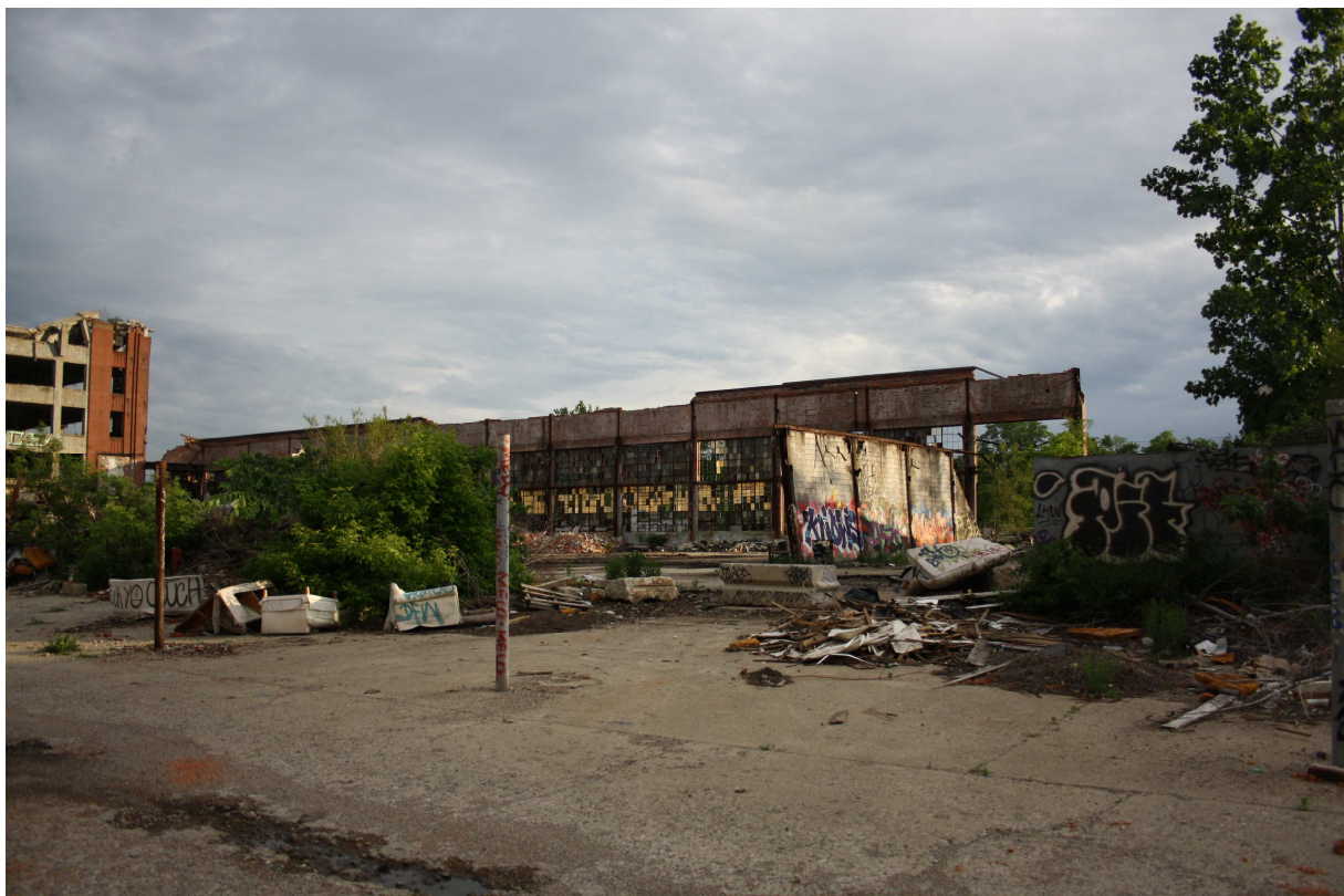
Ruines couvertes de graffitis de la Packard Plant, dans l'East Side. Source : F. Paddeu, 2013.
