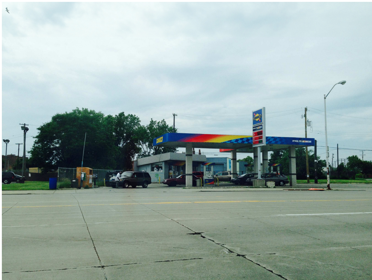
Station essence Sunco, située au bord de l’avenue Gratiot, au nord du quartier de Jefferson-Mack. Source : C. Ruggeri, 2015.
