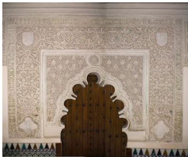
31. Arc de la Cour Arabe donnant sur la Chapelle Dorée, Tordesillas
