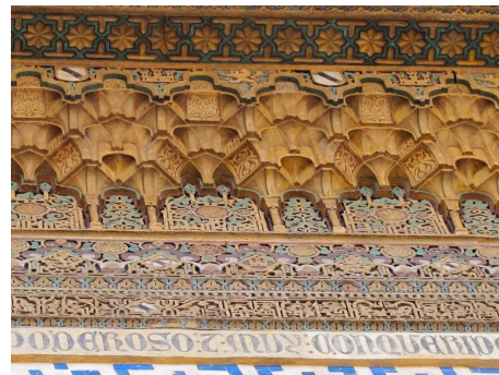
49. b. Détail de la façade, mocárabes
