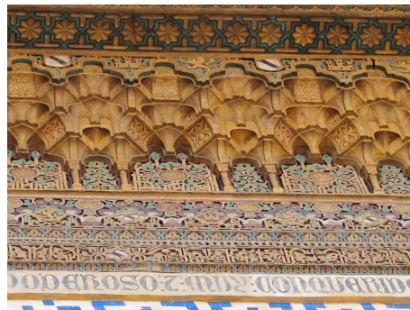
49. b. Détail de la façade, mocárabes
