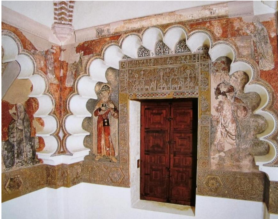
26. Vestibule du Palais de Tordesillas Photographie de Patrimonio Nacional
