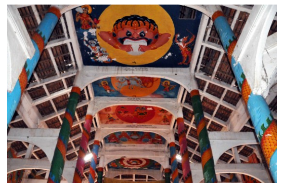
Charpente en béton armé. Nef centrale
