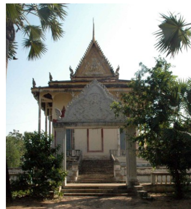
Sanctuaire. Côté ouest
