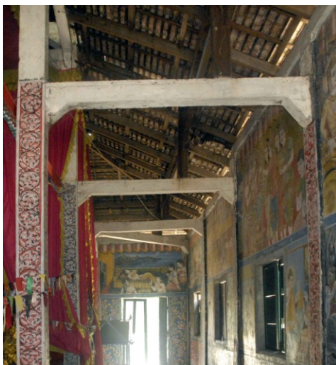
Intérieur du sanctuaire. Piliers et tirants en béton armé de la nef latérale sud
