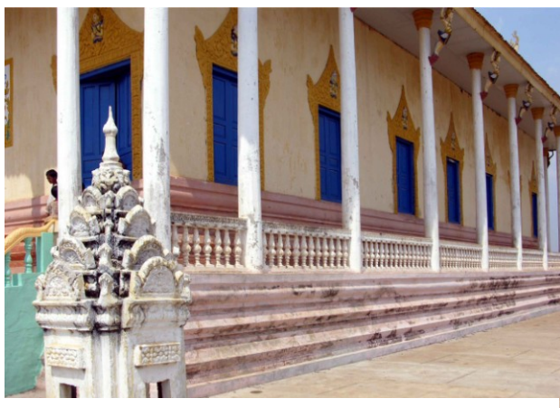
Soubassement mouluré du côté sud et abri de
