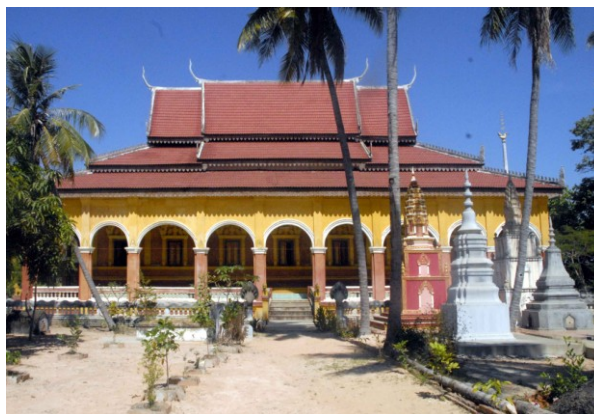
Sanctuaire. Côté sud
