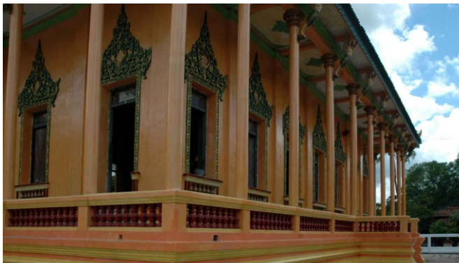
Soubassement mouluré de la galerie et l'escalier d'accès du côté sud
