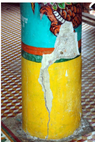
Fissures dans les colonnes et les pilastres en 2005
