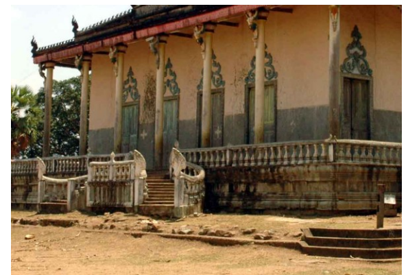
Vue du côté nord en 2005, montrant les restes de la terrasse, le soubassement de la galerie, le perron et les degrés en éventail
