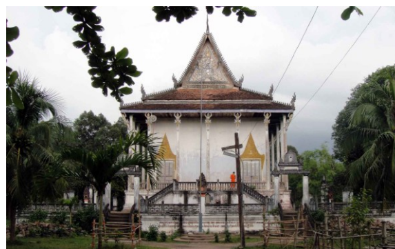
Sanctuaire. Côté ouest
