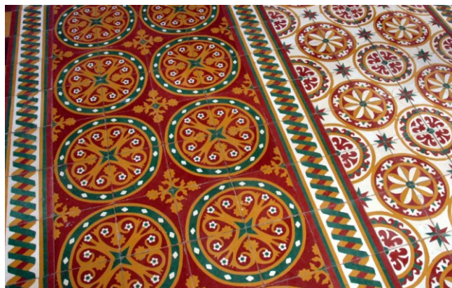
Sol en carrelage ancien, à gauche, et moderne, à droite, dans la nef centrale
