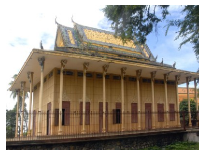
Sanctuaire vu du sud
