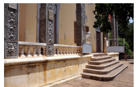
Degré d'accès à la galerie, côté ouest
