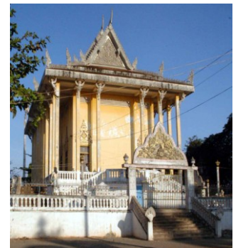
Sanctuaire vu de l'ouest
