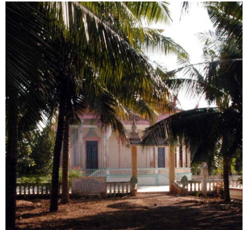
Sanctuaire. Côté ouest
