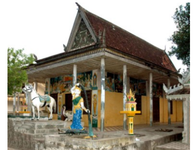
Sanctuaire vu du nord-est
