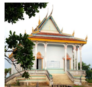
Sanctuaire vu de l'ouest
