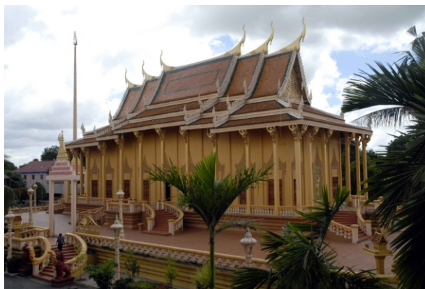
Vue du nord du sanctuaire en 2011, montrant les perrons doubles à degrés incurvés de la terrasse et de la galerie
