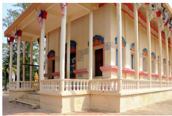
Sanctuaire. Angle sud-ouest
