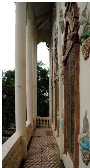
Galerie pourtournante Premier niveau
