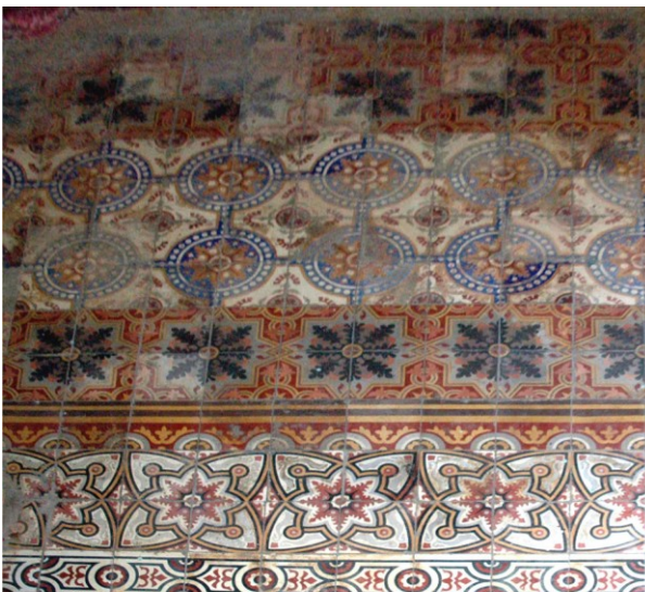
Carrelage ancien des nefs latérales
