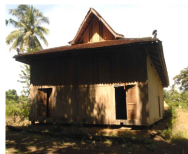
Sanctuaire vu de l'ouest
