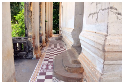
Galerie et degrés d'accès au sanctuaire. Côté ouest
