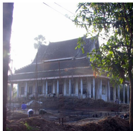
Sanctuaire vu du nord. Au premier plan, les travaux de construction du nouveau sanctuaire en 2005
