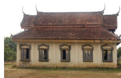
Sanctuaire vu du sud
