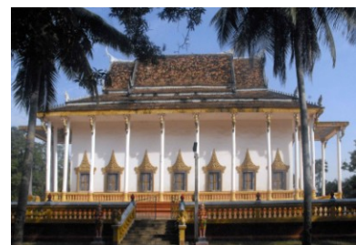
Sanctuaire vu du sud
