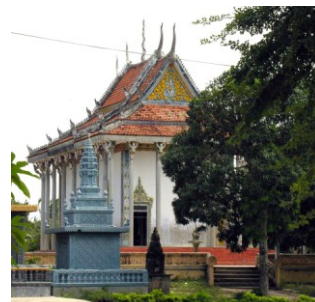
Sanctuaire vu de l'ouest
