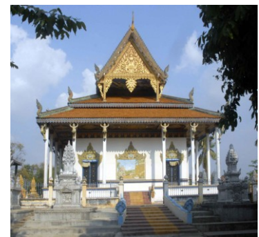
Sanctuaire vu de l'ouest
