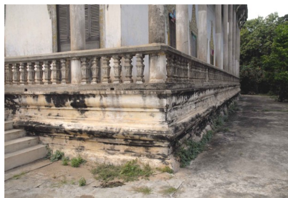
Soubassement mouluré du côté nord
