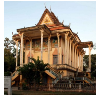
Sanctuaire vu de l'ouest
