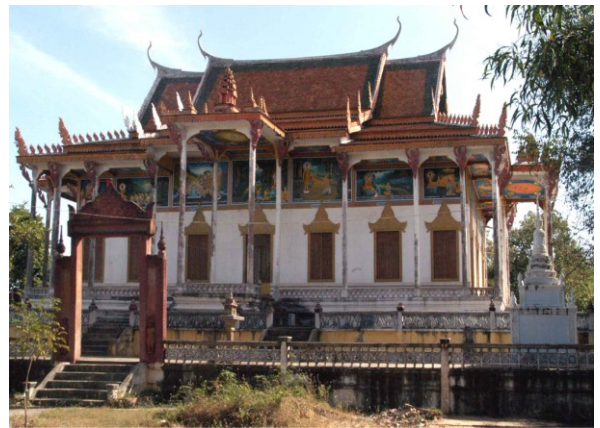
Sanctuaire. Côté nord
