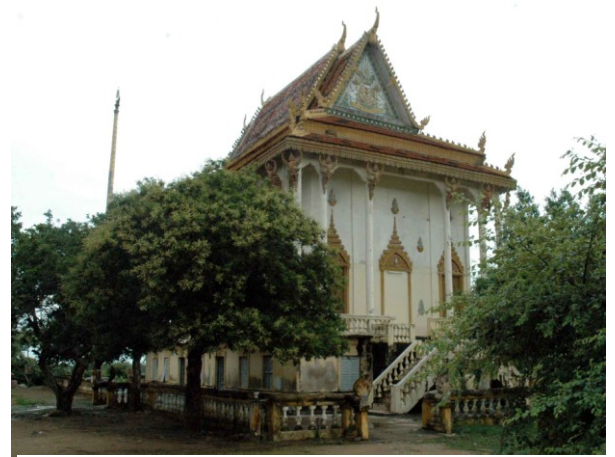
Sanctuaire vu de l'ouest
