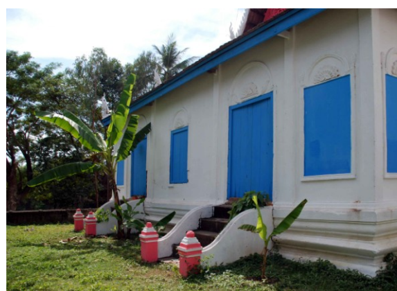
Sanctuaire. Escaliers d'accès côté oriental en 2007.
