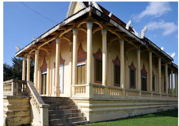
Vue du nord-est en 2011, montrant les arcs portés par les colonnes de la galerie
