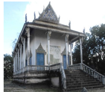
Sanctuaire vu de l'ouest
