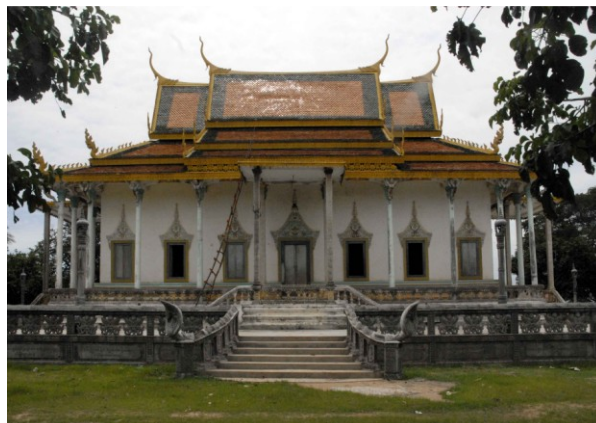
Sanctuaire vu du sud
