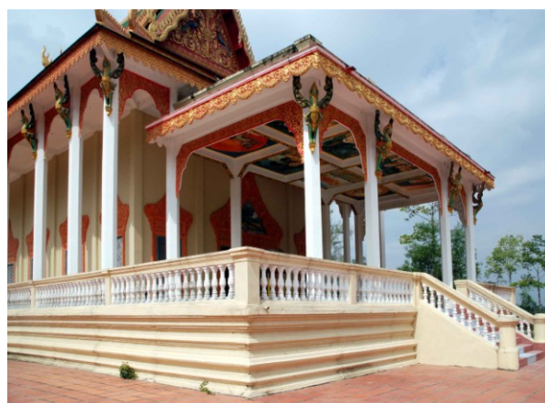
Côté oriental en 2007. Porche, degré d'accès et soubassement mouluré de la galerie
