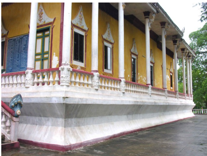
Soubassement mouluré de la galerie Côté sud
