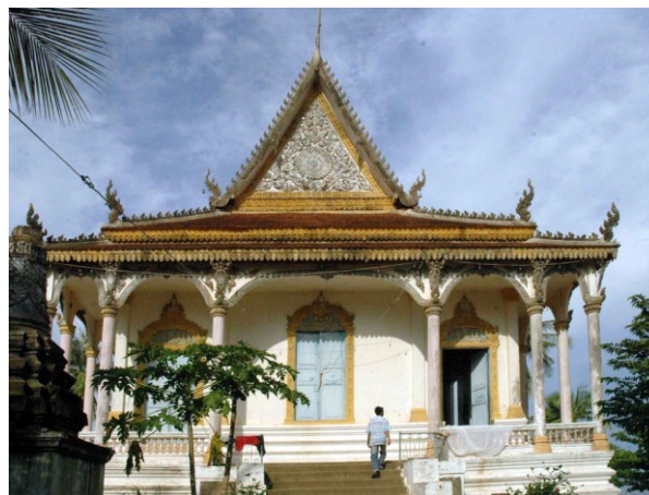
Sanctuaire. Côté ouest
