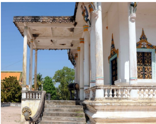
Vue du soubassement de la galerie et du perron double couvert occidental
