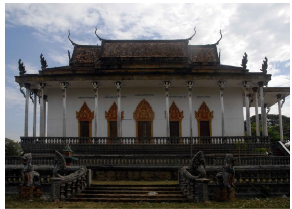
Sanctuaire. Côté nord
