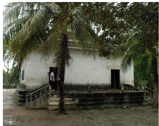
Sanctuaire. Côté ouest
