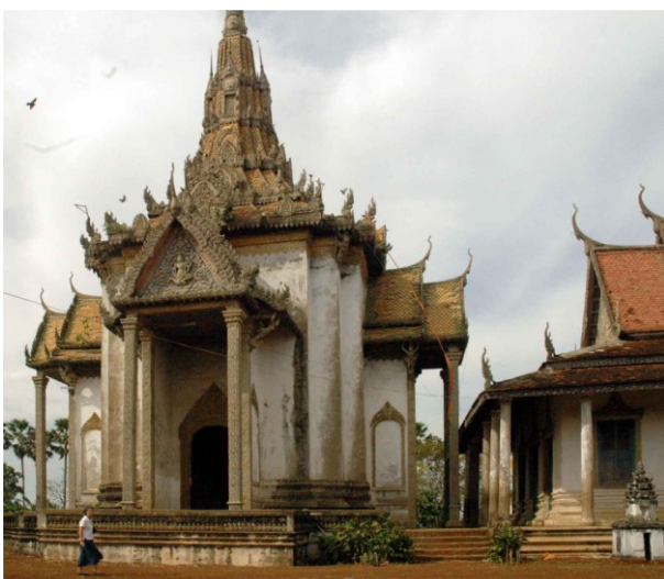
Edifice placé à l'ouest du sanctuaire, sur la même terrasse
