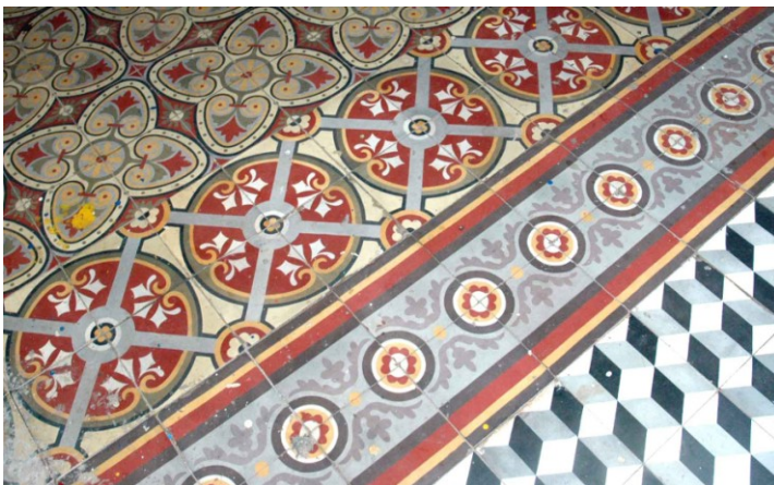
Diversité des carreaux anciens en ciment compressé
