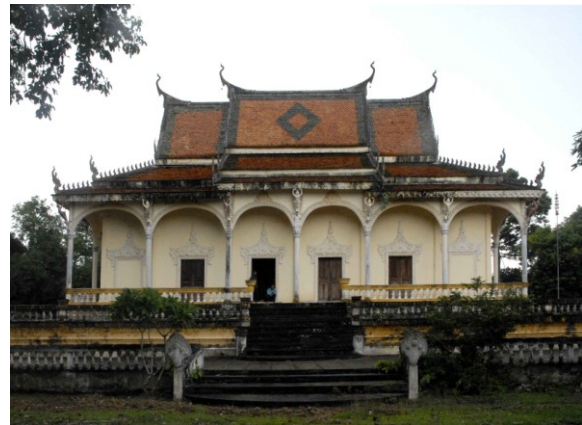
Sanctuaire vu du sud
