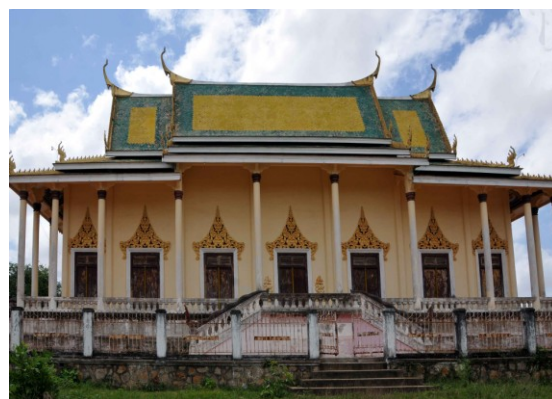
Sanctuaire. Côté nord
