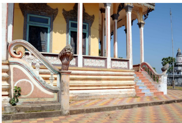
Vue du soubassement de la galerie et des murs d'échiffre des degrés des perrons avec une queue de naga en volute
