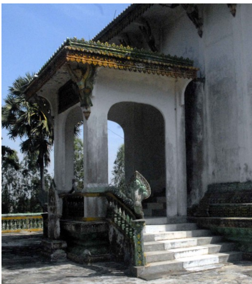
Perron double couvert du côté ouest
