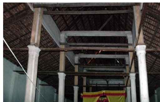
Structure en béton armé de la nef centrale
