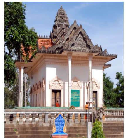
Sanctuaire. Côté ouest
