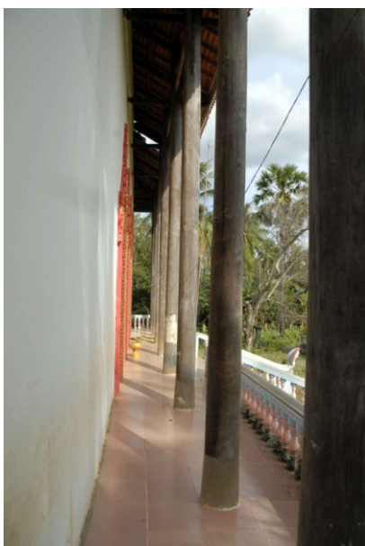
Galerie pourtournante du sanctuaire. Colonnes en bois, sur socle en béton, placées aux 2/3 de la largeur de la galerie sud
