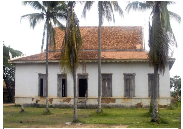
Sanctuaire vu du sud
