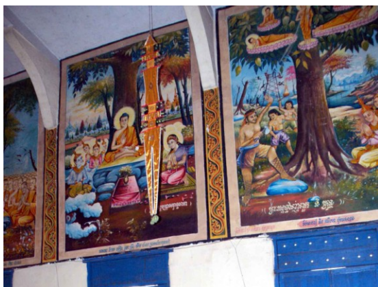
Vue des pilastres et des consoles supportant les poutres en béton armé créant l'unique nef du sanctuaire
