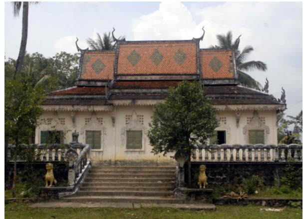
Sanctuaire. Côté sud
