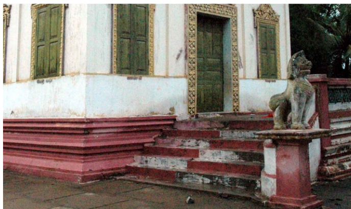
Détail du soubassement de l'angle sud-est et du perron oriental
