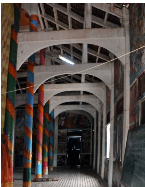
Charpente en béton armé. Nef latérale sud
