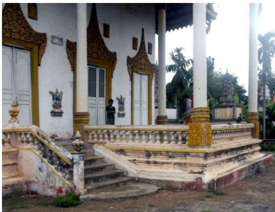
Côté oriental en 2011. Accès à la galerie
