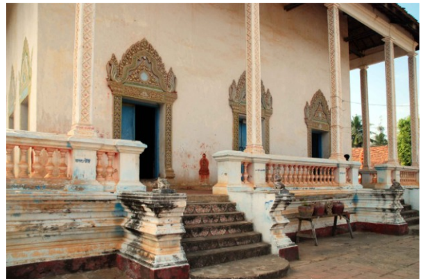
Vue du côté oriental montrant les deux escaliers d'accès à la galerie et une feuille de simā scellée sur le mur extérieur entre deux portes
