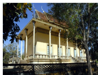
Sanctuaire vu du sud
