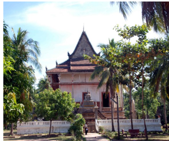
Sanctuaire. Côté ouest
