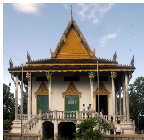
Sanctuaire. Côté ouest
