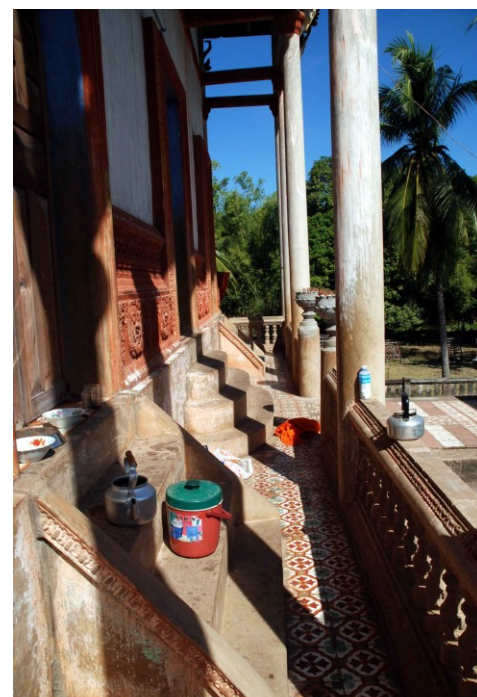
Galerie pourtournante. Les trois degrés d'accès du côté oriental
