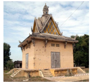
Sanctuaire vu du sud
