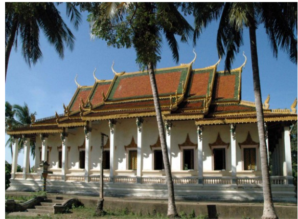
Vue du côté sud.
