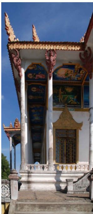
Colonnes, arcs et soubassement de la galerie, côté ouest
