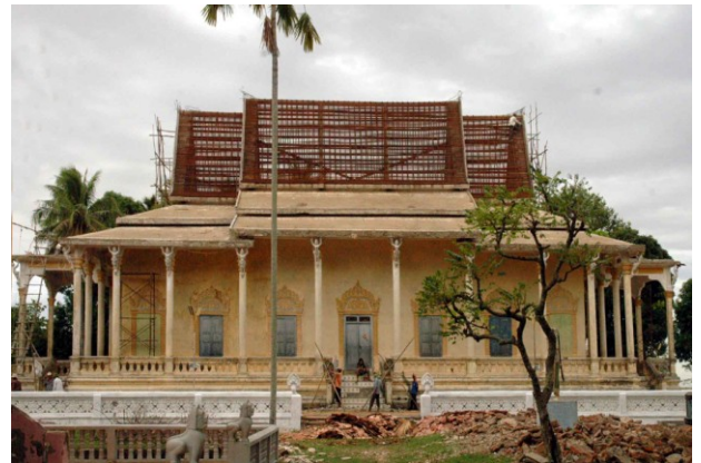
Sanctuaire. Vue du sud en décembre 2005 montrant les travaux de réfection du toit et la couverture en béton armé des versants en pente douce
