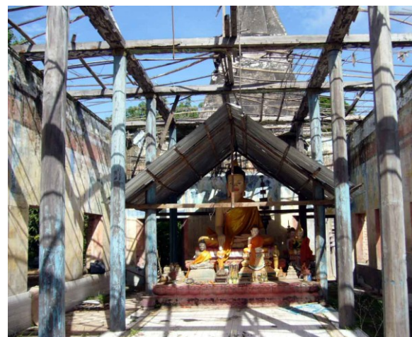
Intérieur du sanctuaire. Protection sommaire de l'autel
