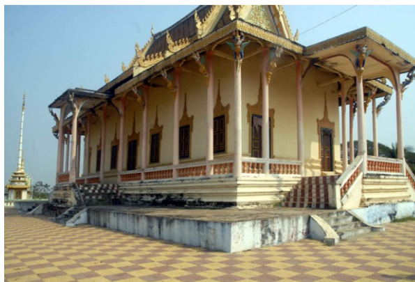
Vue du nord-ouest, en 2011, montrant la deuxième terrasse et ses degrés ainsi que les perrons doubles couverts de la galerie
