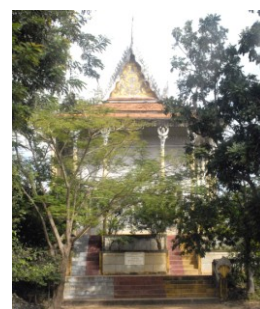
Sanctuaire vu de l'ouest
