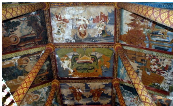
Plafond en béton armé à poutre apparente
