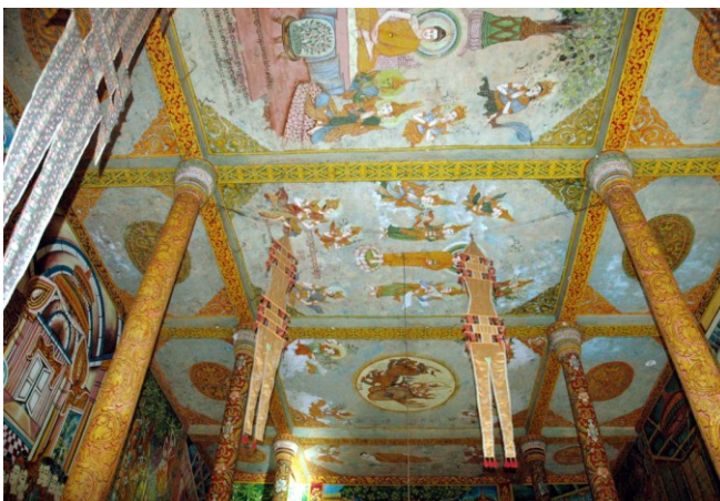
Plafond de béton armé à poutres apparentes
