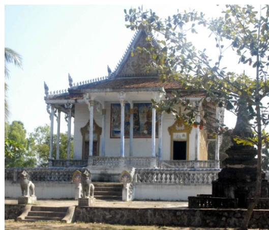
Sanctuaire vu du côté ouest
