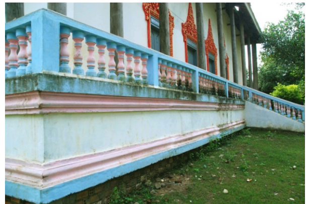
Vue de l'angle sud-ouest du soubassement de la galerie et de l'escalier sud
