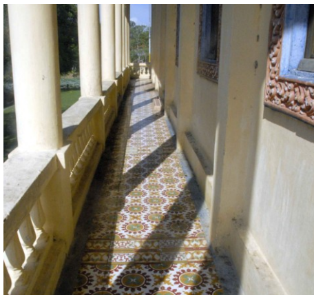
Côté sud de la galerie. Détail du sol ancien en carreaux de ciment compressé
