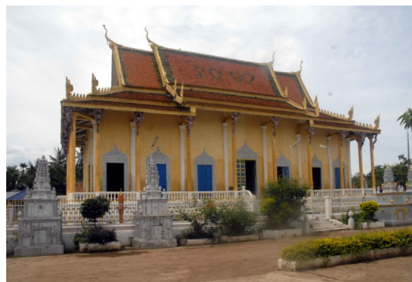
Sanctuaire vu du sud
