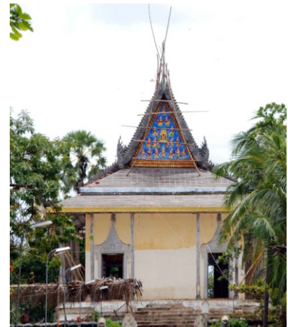
Sanctuaire. Côté ouest avec le fronton portant la date de 1899, en septembre 2010
