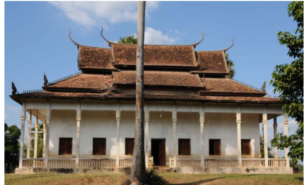
Sanctuaire vu du sud
