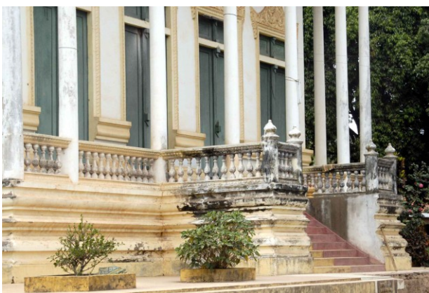
Soubassement et mur d'échiffre de l'escalier ouest
