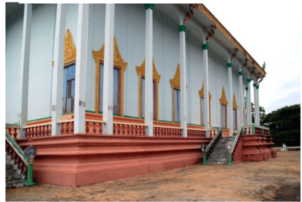
Sanctuaire. Côté sud
