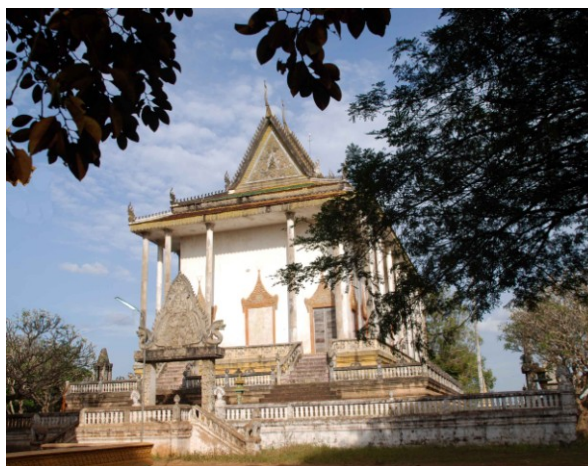
Sanctuaire. Côté ouest
