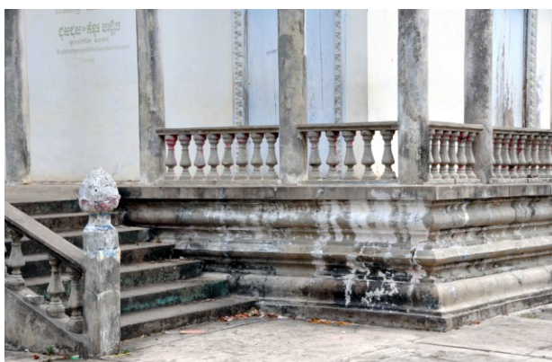
Soubassement de la galerie et degré du perron ouest
