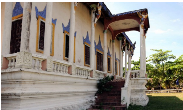
Vue du soubassement de la galerie et du perron nord
