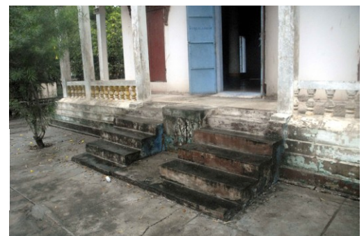
Degrés d'accès à la galerie sur le côté oriental
