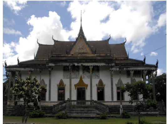
Sanctuaire. Côté nord
