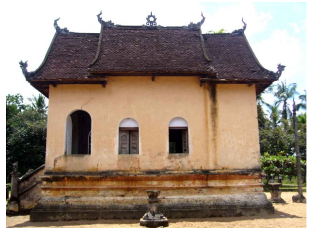
Sanctuaire. Côté nord
