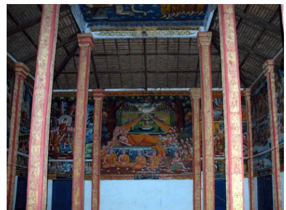
Vue de l'intérieur du sanctuaire, côté est, montrant les piliers, les pilastres, la charpente en bois apparente dans la première travée du plafond de la nef centrale
