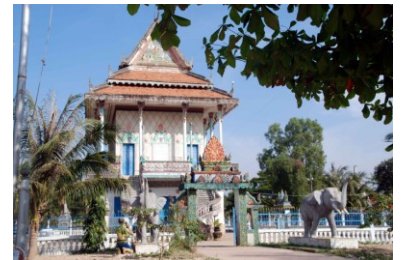
Sanctuaire vu de l'ouest
