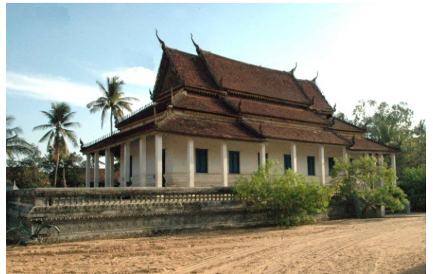
Sanctuaire vu du sud
