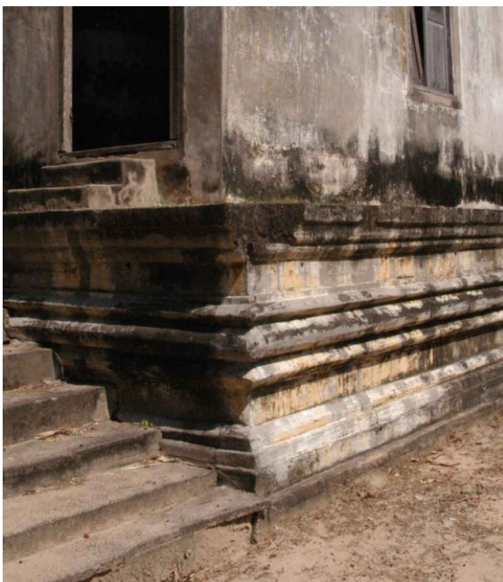
Détail du soubassement mouluré, angle sud-ouest
