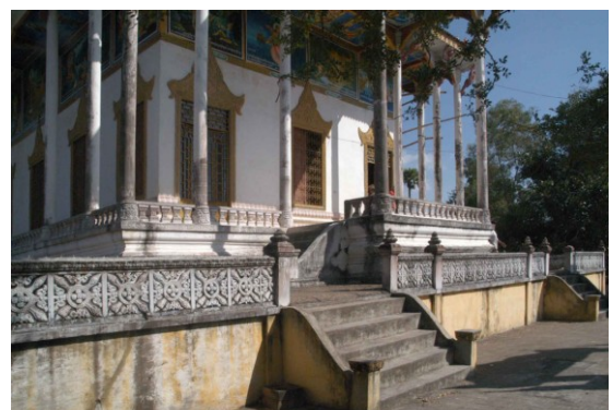
Degrés de la seconde terrasse et perron double couvert du côté ouest
