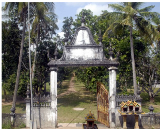
Portique nord de la terrasse, vu de la galerie
