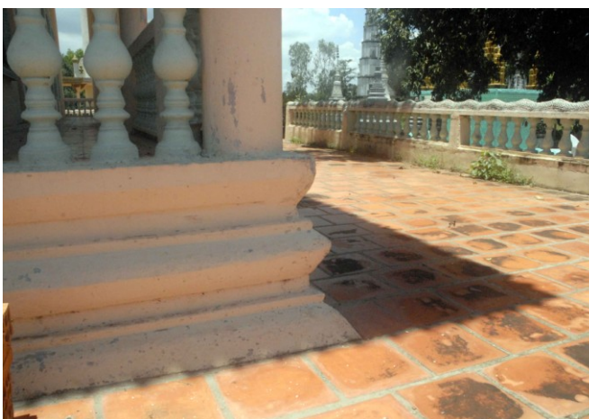
Terrasse et soubassement mouluré de la galerie
