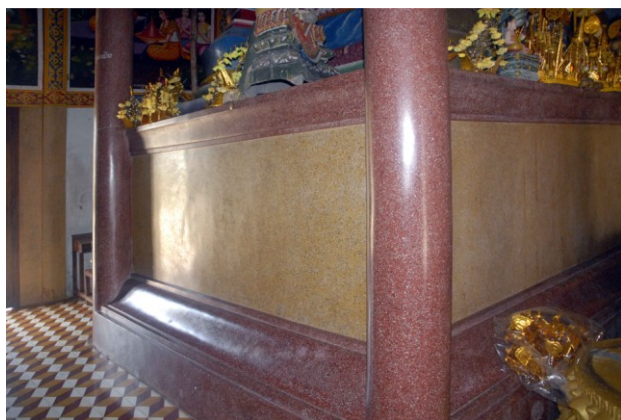
Revêtement de terrazzo de la base de l'autel et de deux colonnes
