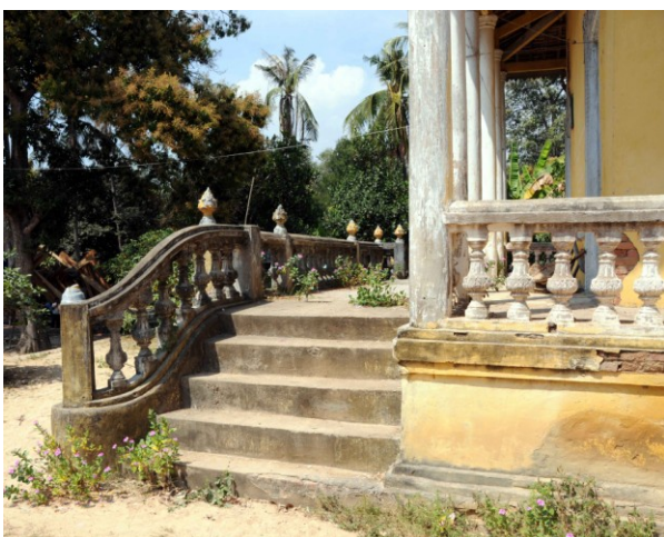
Vue du soubassement de la galerie et du degré droit évasé du perron double, angle sud-ouest
