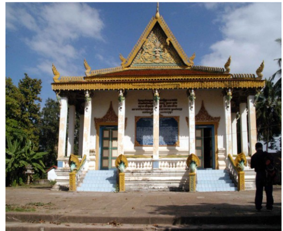
Vue du côté ouest
