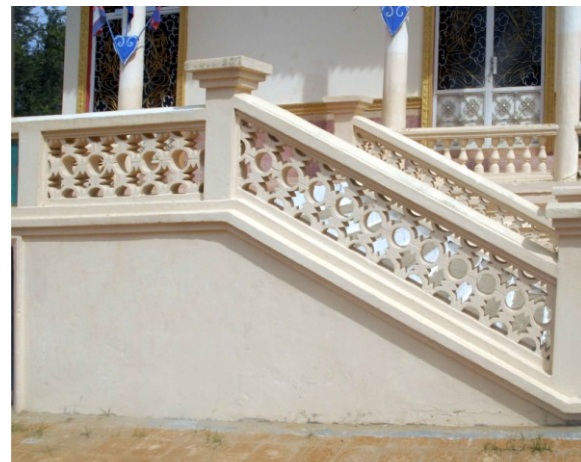
Rampe en béton moulé du perron ouest
