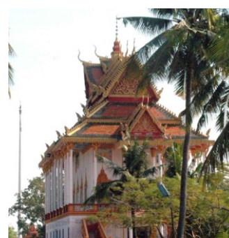
Sanctuaire vu de l'ouest
