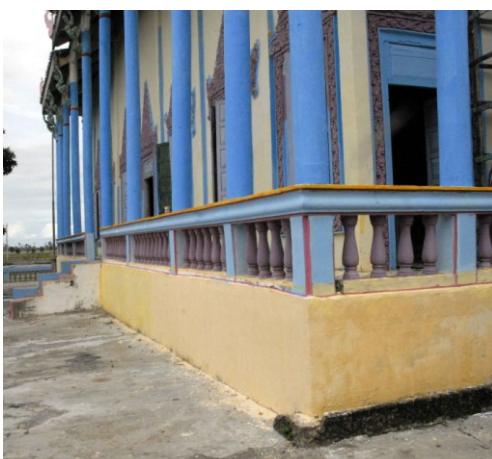
Soubassement à l'angle nord-ouest
