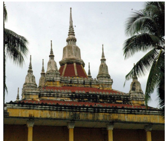
Sanctuaire. Détail du toit
