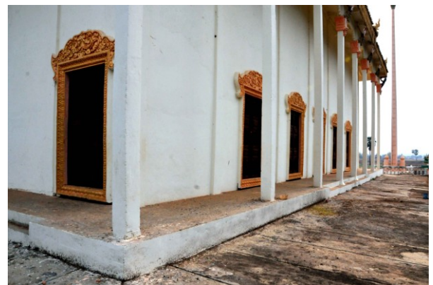
Sanctuaire. Côté sud
