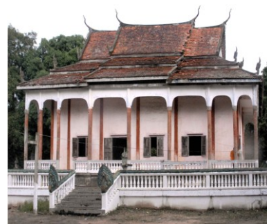
Sanctuaire vu du sud
