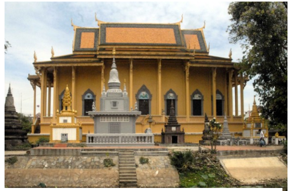
Sanctuaire vu du sud
