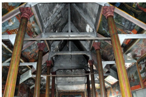
Intérieur du sanctuaire. Charpente en béton armé
