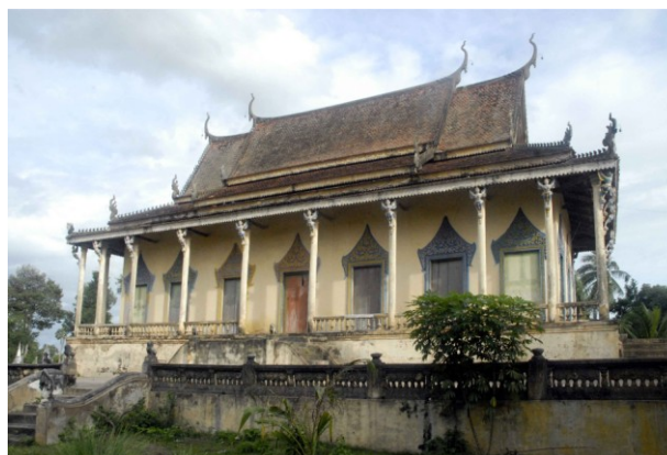
Sanctuaire vu du sud
