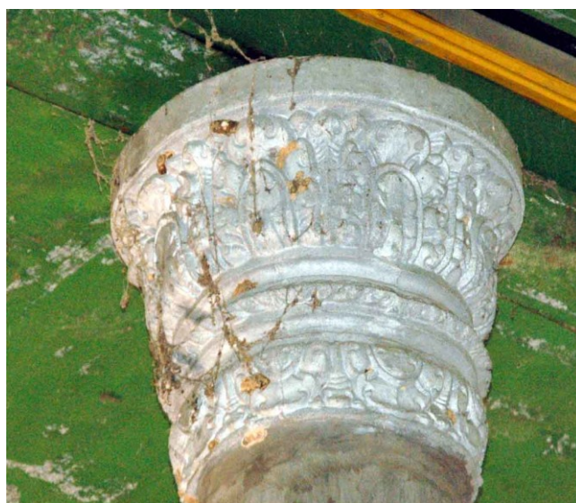
Chapiteau en béton moulé
