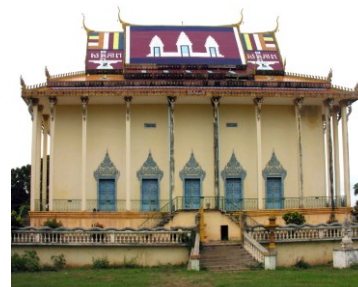
Sanctuaire vu du sud
