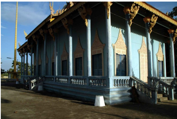
Vue du côté nord montrant la modénature du soubassement de la galerie et les escaliers d'accès
