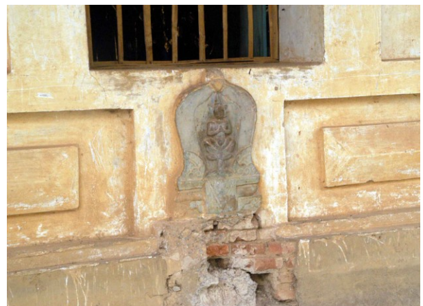
Détail du mur sud du sanctuaire, montrant une feuille de sīmā scellée en-dessous d'une baie et les briques sous le revêtement.
