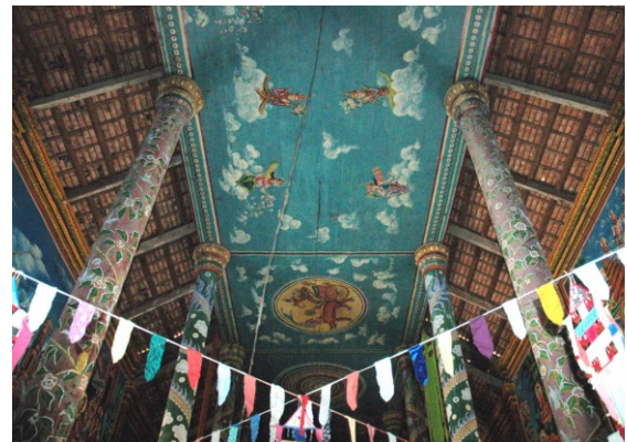
Intérieur du sanctuaire. Vue de la charpente en béton armé et du plafond en bois de la nef centrale
