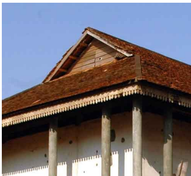
Vue montrant le fronton en retrait sur la croupe ouest et son tympan de planches, ainsi que les traces d'impact de balles résultant des conflits
