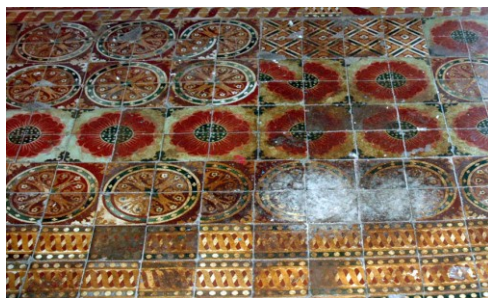
Sol en carreaux de ciment de récupération
