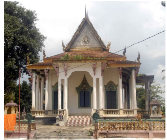
Vue du côté ouest du sanctuaire montrant le perron couvert, ses colonnes gémellées portant des arcs et les 5 marches d'accès carrelées de carreaux anciens en ciment compressé
