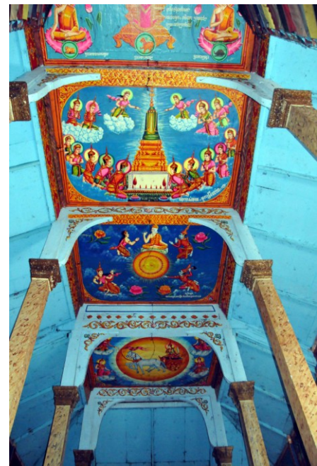
Sanctuaire. Arcs en béton armé supportés par les piliers de la nef
