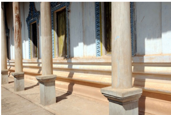
Galerie pourtournante du côté ouest. Colonnes sur haut socle carré et pseudo-soubassement mouluré
