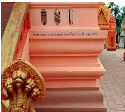
Moulure du soubassement de la galerie pourtourante
