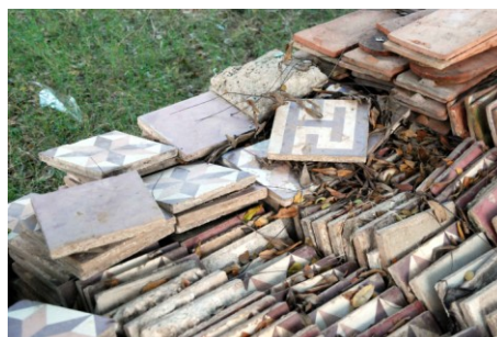
Carreaux de ciment compressé récupérés et conservés pour la reconstruction du sanctuaire
