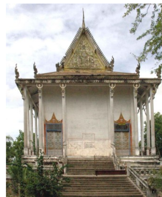
Sanctuaire vu du côté ouest
