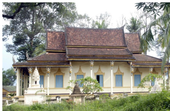
Sanctuaire. Côté sud
