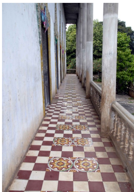
Sol en carreaux de ciment de la galerie nord
