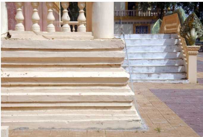
Soubassement de la galerie
