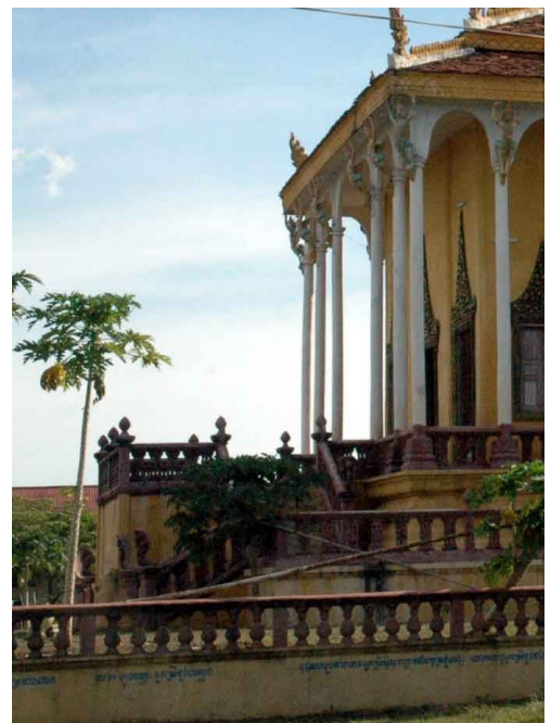
Terrasses, perron et galerie du côté oriental
