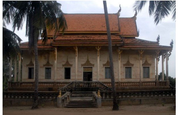
Sanctuaire vu du sud
