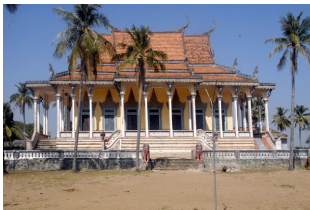
Sanctuaire vu du sud
