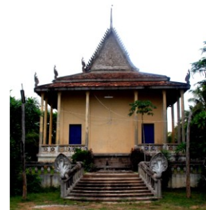
Sanctuaire vu du côté ouest
