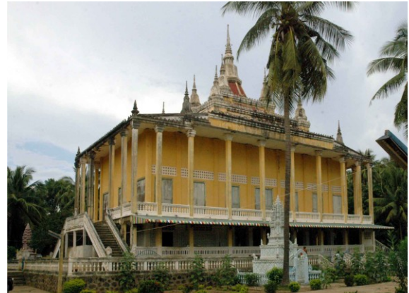
Sanctuaire vu du sud
