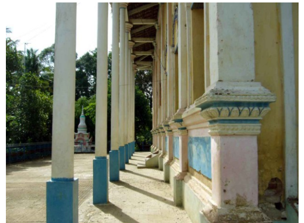
Vue de la galerie pourtournante, côté sud, montrant le décor mouluré du soubassement et des pilastres, l'absence de balustrade et l'avancée de l'escalier d'accès au sanctuaire
