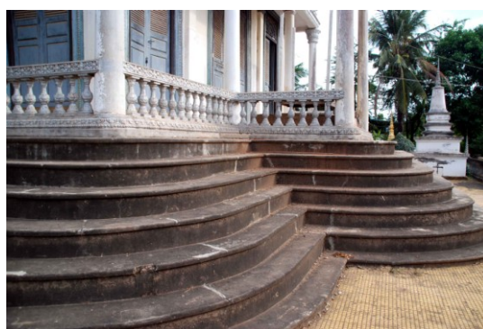
Emmarchement de la galerie Angle nord-ouest
