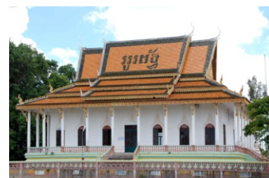
Sanctuaire vu du sud
