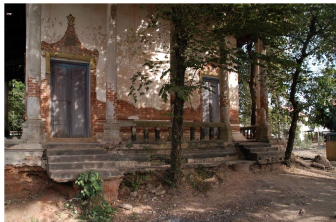
Côté ouest, absence de terrasse et creusement de l'eau sous les degrés d'accès au sanctuaire
