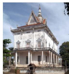
Sanctuaire vu de l'ouest
