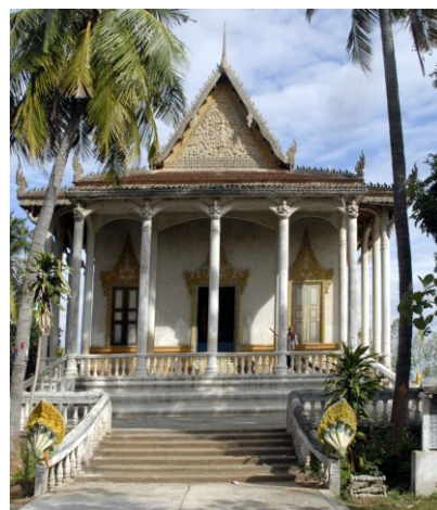
Sanctuaire. Côté ouest
