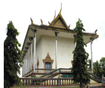
Sanctuaire vu de l'ouest
