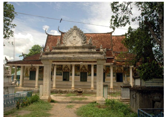
Sanctuaire. Côté nord
