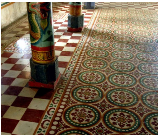
Sol ancien de la nef latérale nord et de la nef centrale Colonnes en bois peint et leur socle
