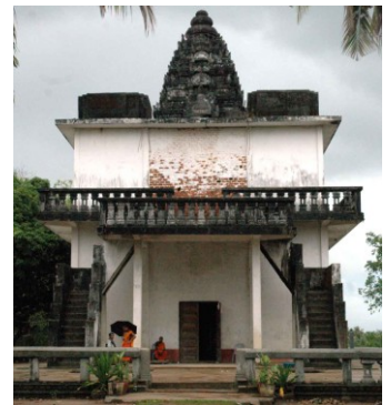
Sanctuaire vu de l'ouest
