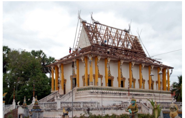
Sanctuaire vu du nord-est, pendant la réparation de la toiture
