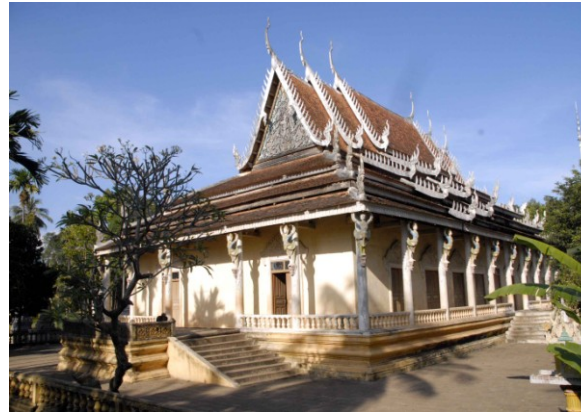
Vue du sud-ouest.
