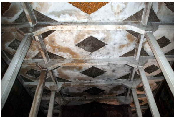
Vue du plafond du sanctuaire en béton armé
