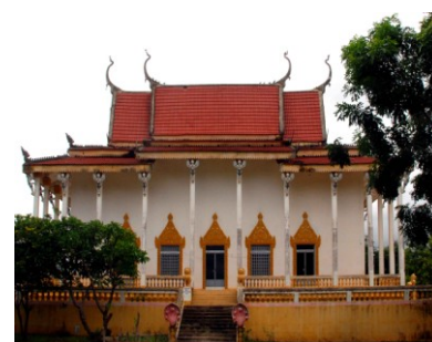
Sanctuaire vu du sud
