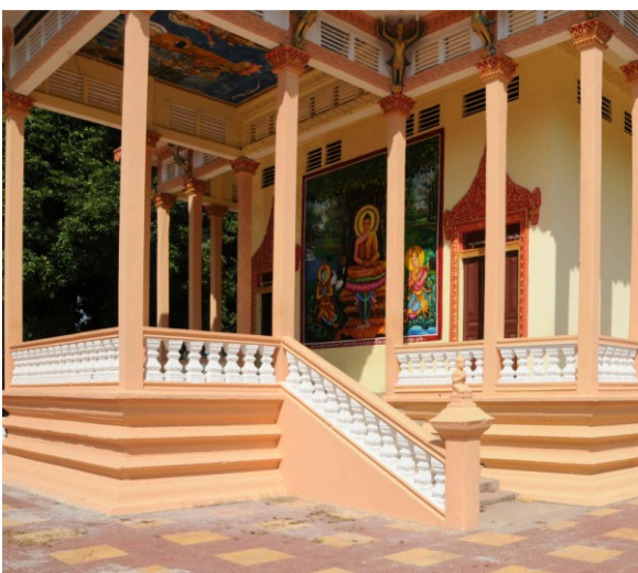
Sanctuaire. Détail des moulures du soubassement de la galerie et du perron double occidental
