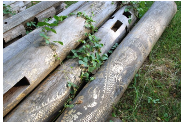
Détails des mortaises et de la décoration des colonnes du sanctuaire
