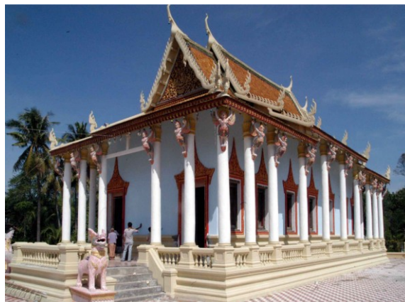
Sanctuaire vu du côté ouest
