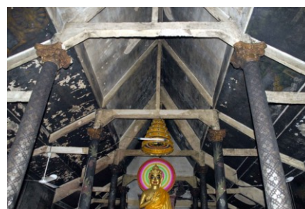
Intérieur du sanctuaire. Charpente en béton armé
