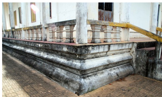
Soubassement mouluré de la galerie
