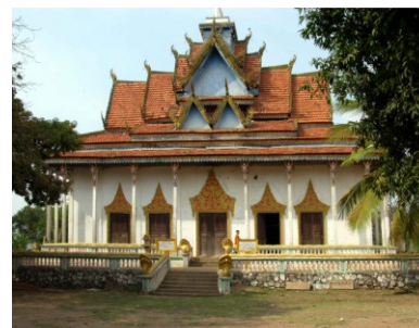
Sanctuaire vu du sud
