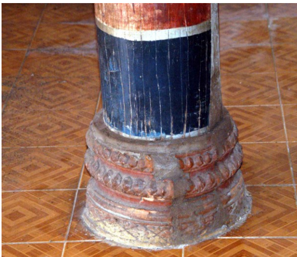
Base en béton moulé d'une colonne en bois
