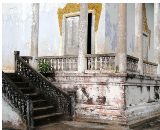
Degré du perron double et soubassement mouluré de la galerie. Angle sud-ouest
