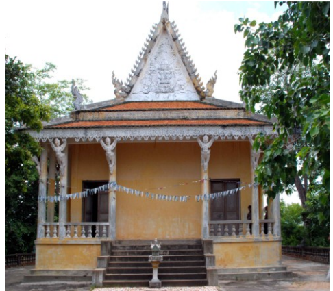
Sanctuaire. Côté ouest
