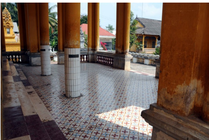
Vue du grand porche oriental en 2011 et des trois marches d'accès sur tout la longueur du côté est
