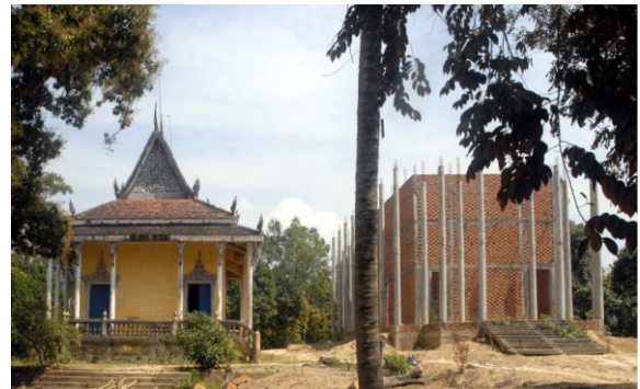
Sanctuaire vu de l'ouest. Au sud le nouveau temple en construction
