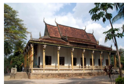
Sanctuaire vu du sud
