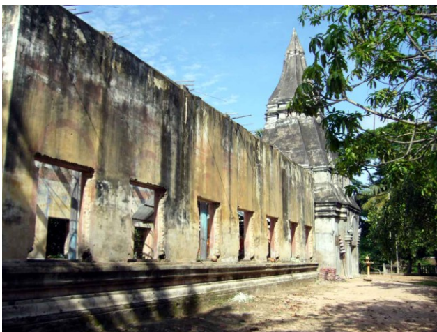
Vue du côté nord montrant le caitya à l'ouest du sanctuaire
