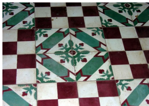
Sol du sanctuaire en carreaux de ciment anciens
