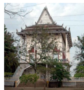
Sanctuaire vu de l'ouest
