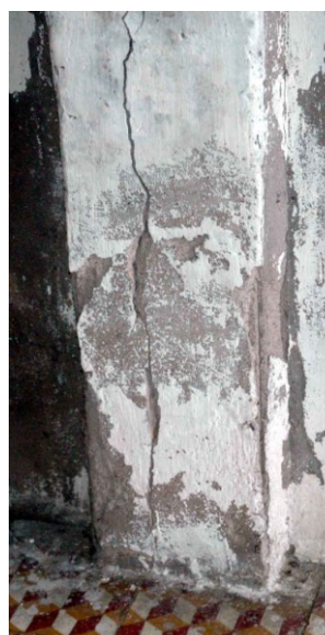
Fissures dans les colonnes et les pilastres en 2005
