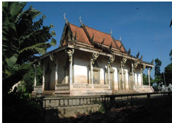
Vue du sud-ouest
