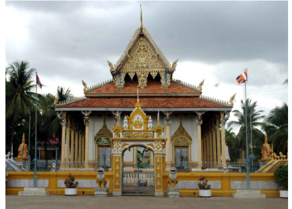
Sanctuaire vu de l'ouest
