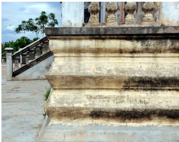
Soubassement de la galerie Côté ouest
