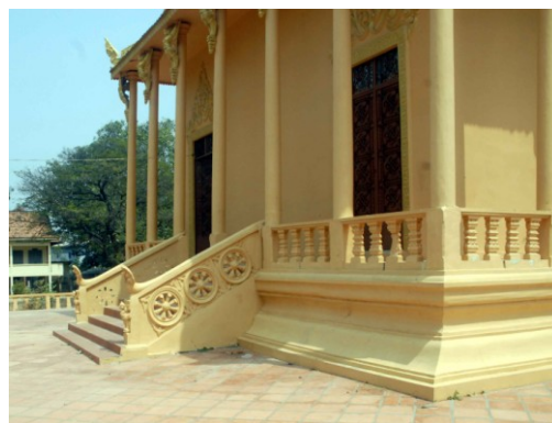
Modénature de la galerie et mur d'échiffre de du degré ouest
