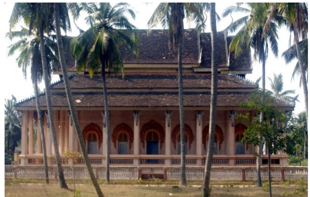
Sanctuaire. Côté nord
