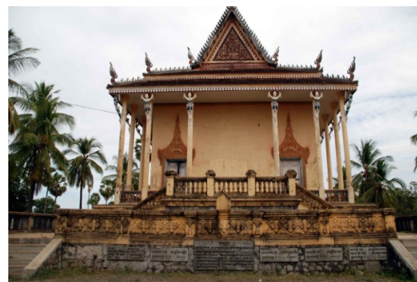
Sanctuaire. Côté ouest
