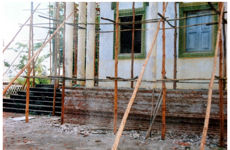
Vue de l'angle nord-est de la galerie montrant le soubassement en briques sans enduit et les degrés rectangulaires du perron oriental, en 2005
