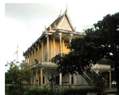
Sanctuaire vu de l'ouest
