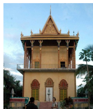
Sanctuaire vu de l'ouest
