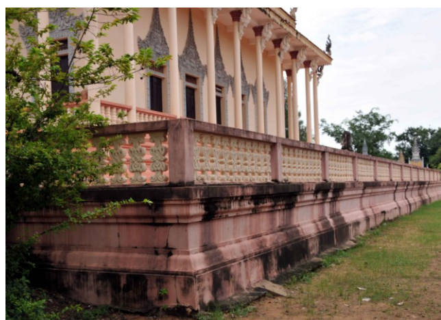
Soubassement mouluré de la terrasse, côté sud, en 2001
