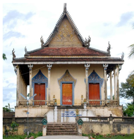
Sanctuaire. Côté ouest
