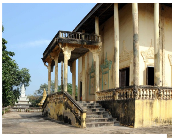
Perron double couvert du côté ouest
