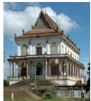
Sanctuaire vu de l'ouest
