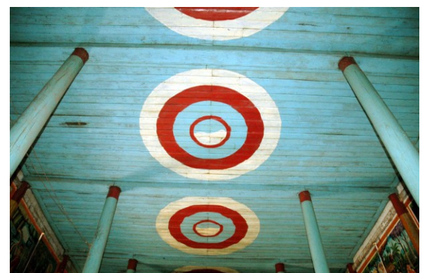
Plafond en planches, orné d'un décor peint géométrique
