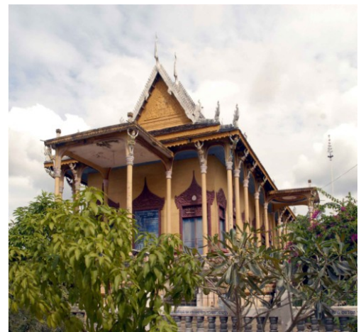
Sanctuaire. Côté ouest
