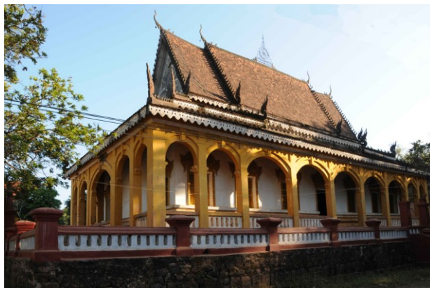
Sanctuaire vu du sud
