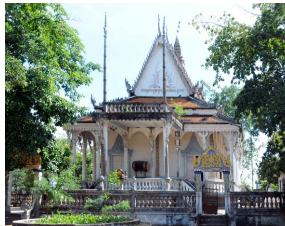
Sanctuaire. Vue du côté oriental montrant les petits portiques de la terrasse
