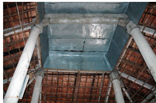
Revêtement en métal du plafond de la nef centrale
