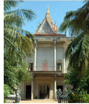
Sanctuaire vu de l'ouest
