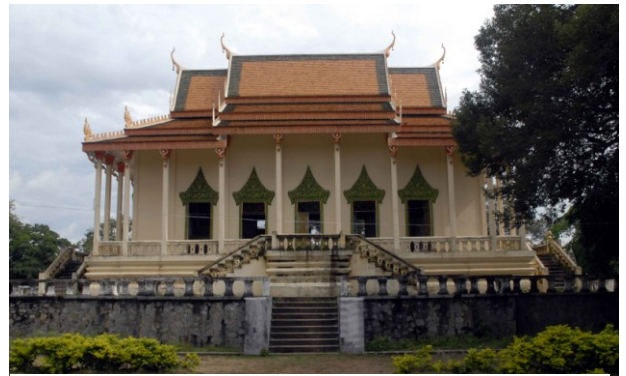
Sanctuaire vu du sud
