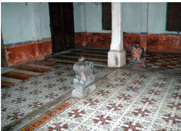
Carreaux de ciment compressé et feuilles de sīmā de la banquette de la nef centrale
