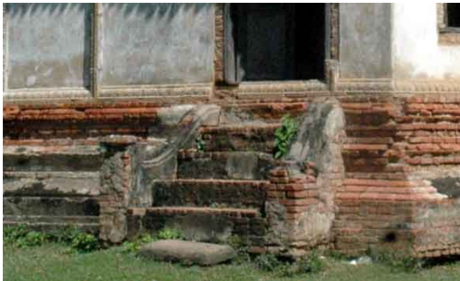
Détail de la rampe incurvée du degré sud-ouest et du soubassement construit en briques ayant perdu son revêtement
