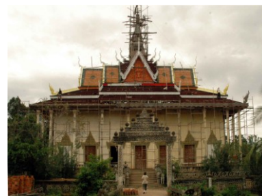
Sanctuaire vu du sud
