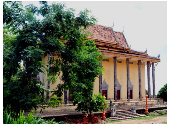
Sanctuaire vu du sud en 2011
