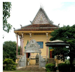
Sanctuaire vu de l'ouest
