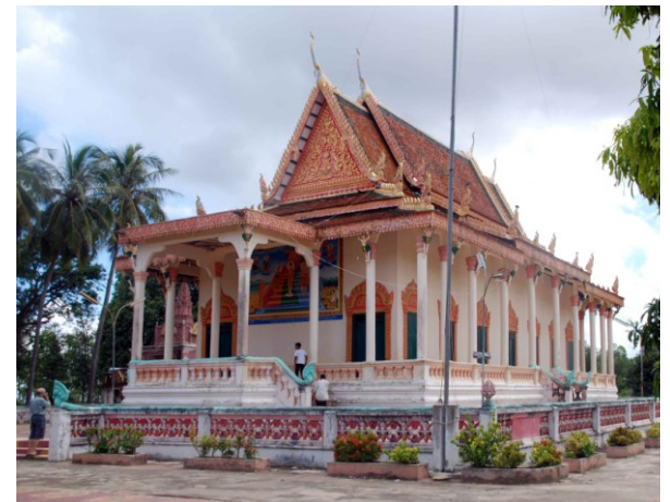
Sanctuaire. Vue du sud-ouest en 2010, après rénovation
