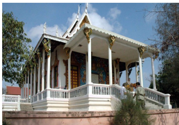
Vue à partir de la première terrasse, en 2005, montrant le perron couvert du côté oriental et la découpe du soubassement de la galerie,
