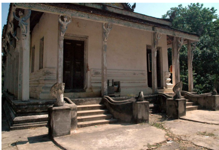
Degrés d'accès à la galerie, côté ouest
