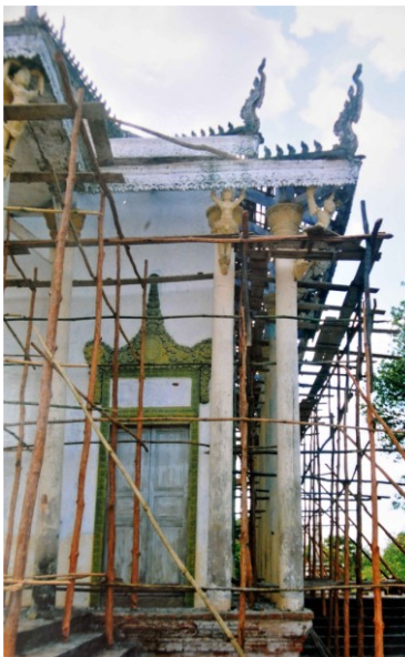
Vue de la galerie nord montrant l'étroitesse de la galerie sans balustrade et les degrés du perron nord, en 2005
