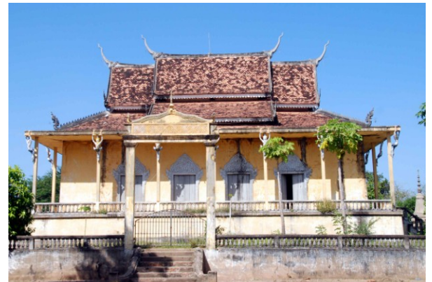
Sanctuaire. Côté sud
