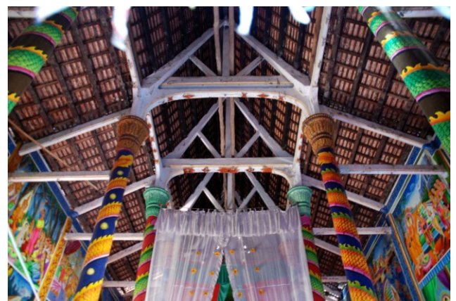
Intérieur du sanctuaire. Charpente en béton armé
