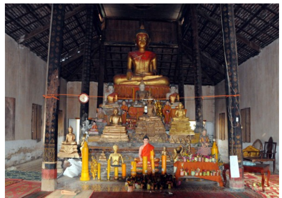
Intérieur du sanctuaire montrant l'inclinaison des colonnes
