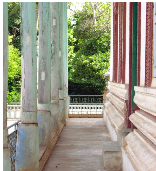
Colonnes de bois sur socle de la galerie et pseudo-soubassement mouluré
