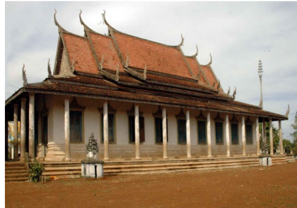
Sanctuaire vu du sud
