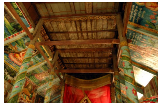
Plafond en bois, incliné dans les nefs latérales
