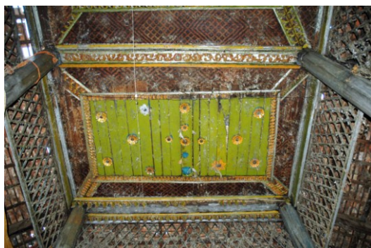
Plafond en bois de la nef centrale
