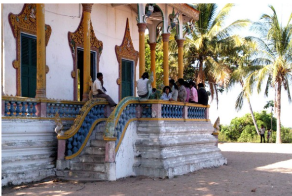
Sanctuaire, côté est. Détail du perron double et du soubassement de la galerie
