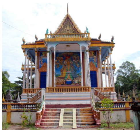
Sanctuaire. Côté ouest
