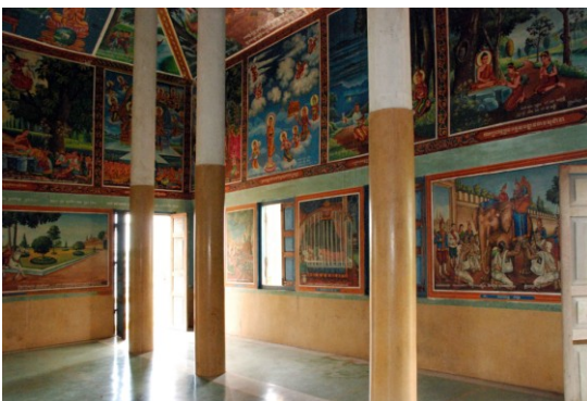
Intérieur du sanctuaire. Revêtement en terrazzo de la partie inférieure des colonnes et des murs
