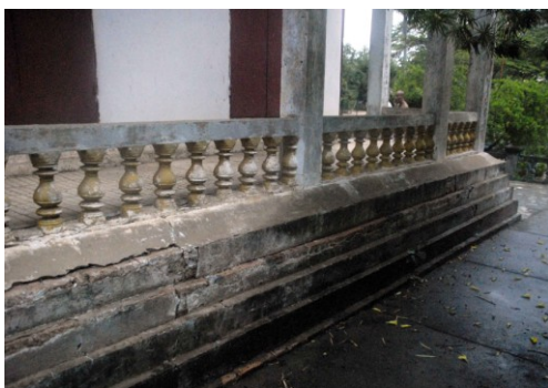
Soubassement de la galerie. Côté nord
