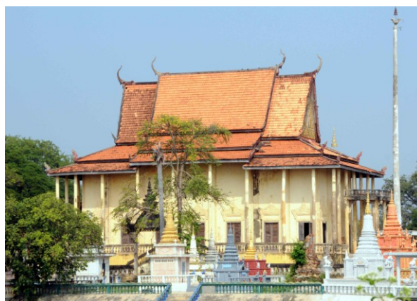
Sanctuaire vu du sud
