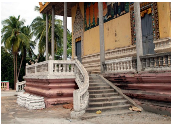
Degrés évasés du perron ouest, après la rénovation de 2007
