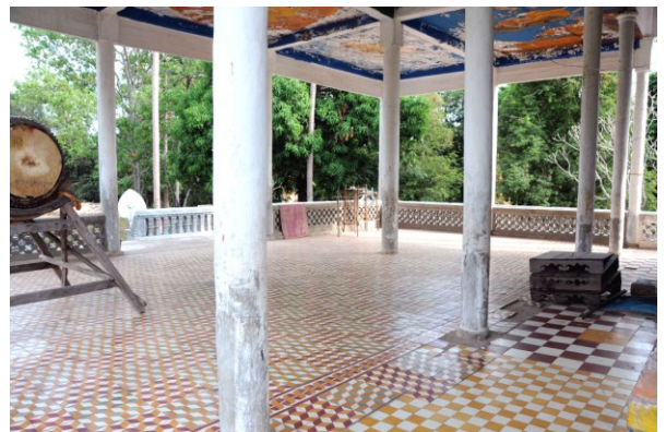
Sanctuaire. Porche du côté oriental, vu du sud
