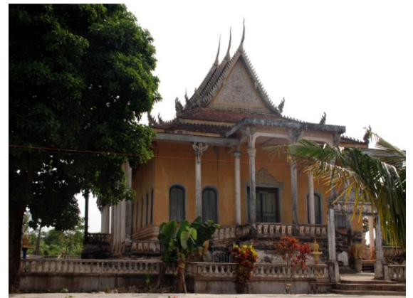
Sanctuaire vu du côté ouest
