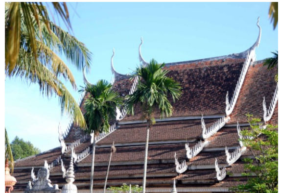
Détail du toit, côté nord.
