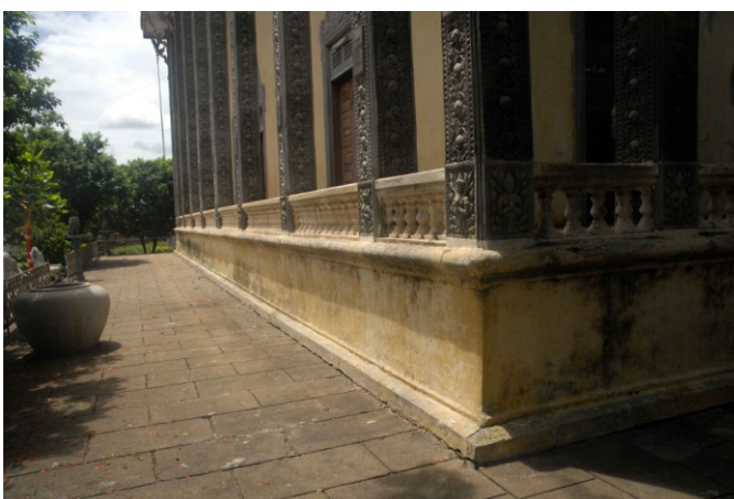
Soubassement mouluré de la galerie, côté sud
