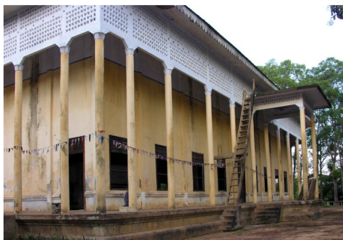
Vue du côté sud montrant le soubassement, le perron double couvert et le bandeau supporté par les colonnes
