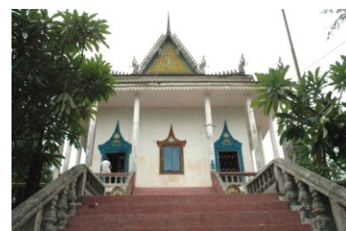
Sanctuaire vu de l'ouest
