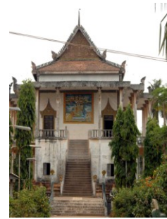
Sanctuaire vu de l'ouest
