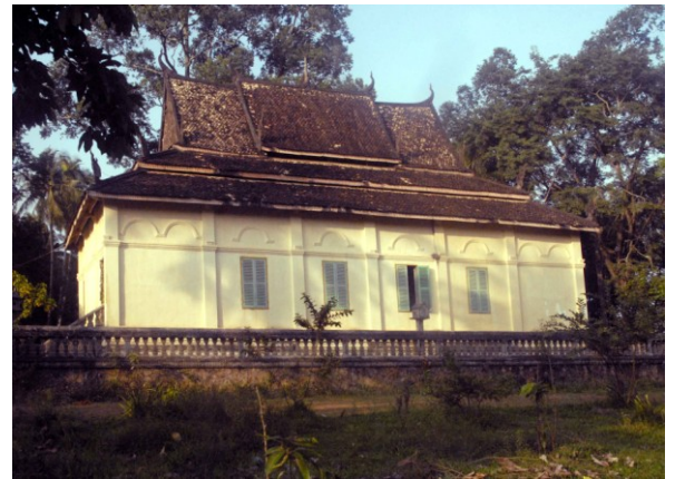
Sanctuaire vu du sud
