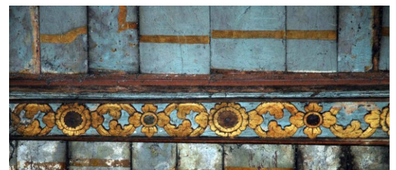
Détail du plafond. Poutre sculptée
