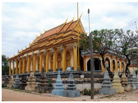
Sanctuaire. Porche à arcades vu du sud-est
