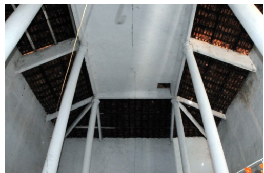
Charpente en béton armé
