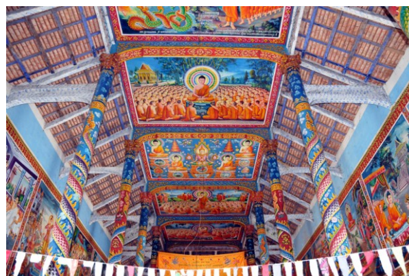
Intérieur du sanctuaire montrant la charpente en béton armé
