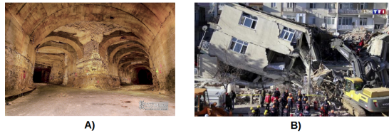
FIGURE 1.5 – A : Carrière souterraine de calcaire (60 hectares) à Conflans Sainte Honore, Herblay [5]. B : Carrière et effondrement d'une maison à Casablanca suite à de forte précipitation [30].
