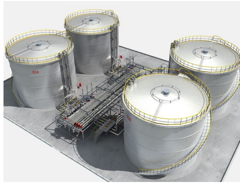
FIGURE 1.4 – Citerne de stockage à inspecter.
