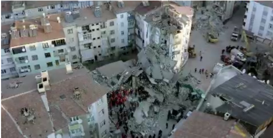
FIGURE 1.7 – Image aérienne d’un séisme de magnitude 6,8 en Turquie, dans une zone urbaine [110].
