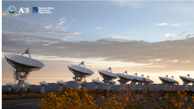
Figure 1.2 – Le Very Large Array telescope (VLA) est un radiotélescope interféromètre, en service depuis 1980, situé au Nouveau-Mexique, aux États-Unis. Il est composé de 27 antennes paraboliques de 25 mètres de diamètre, qui peuvent être disposées selon quatre configurations différentes. Il couvre une gamme de fréquences allant de 74 MHz à 50 GHz.
