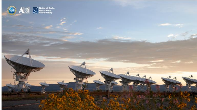
Figure 1.2 – Le *Very Large Array telescope* (VLA) est un radiotélescope interféromètre, en service depuis 1980, situé au Nouveau-Mexique, aux États-Unis. Il est composé de 27 antennes paraboliques de 25 mètres de diamètre, qui peuvent être disposées selon quatre configurations différentes. Il couvre une gamme de fréquences allant de 74 MHz à 50 GHz.
