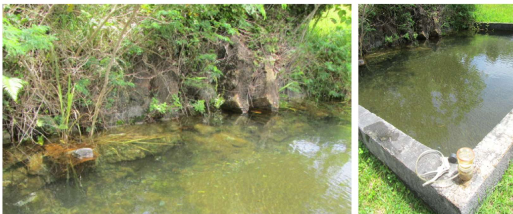
Figure 13 : Le captage d'Oumagne alimenté par l'eau qui suinte au travers de la péridotite.
