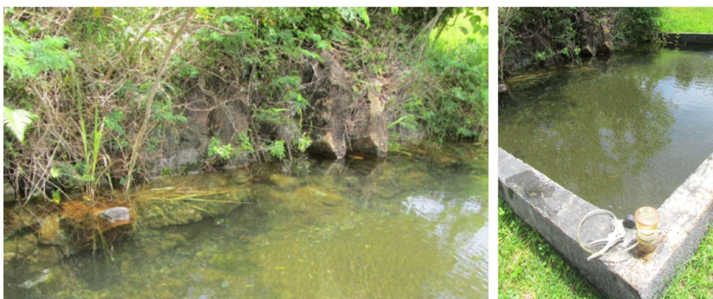
Figure 13 : Le captage d'Oumagne alimenté par l'eau qui suinte au travers de la péridotite.
