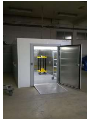
BANC DE FLUAGE A L'INTERIEUR DE LA CHAMBRE
