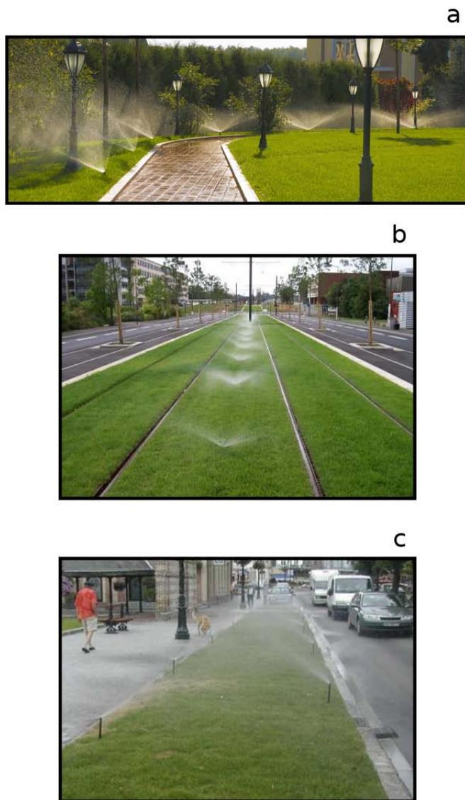
FIGURE 6.5 – Exemples de réseaux d’asperseurs installés en milieu urbain, dans un square (a), sur des lignes de tramway (b), dans une rue (c). Source : [www.sirev.fr](http://www.sirev.fr)
