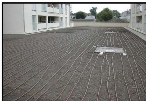
FIGURE 6.6 – Exemple de goutteurs en ligne installés pour une toiture végétalisée (Source : [sirev.fr](http://sirev.fr))
