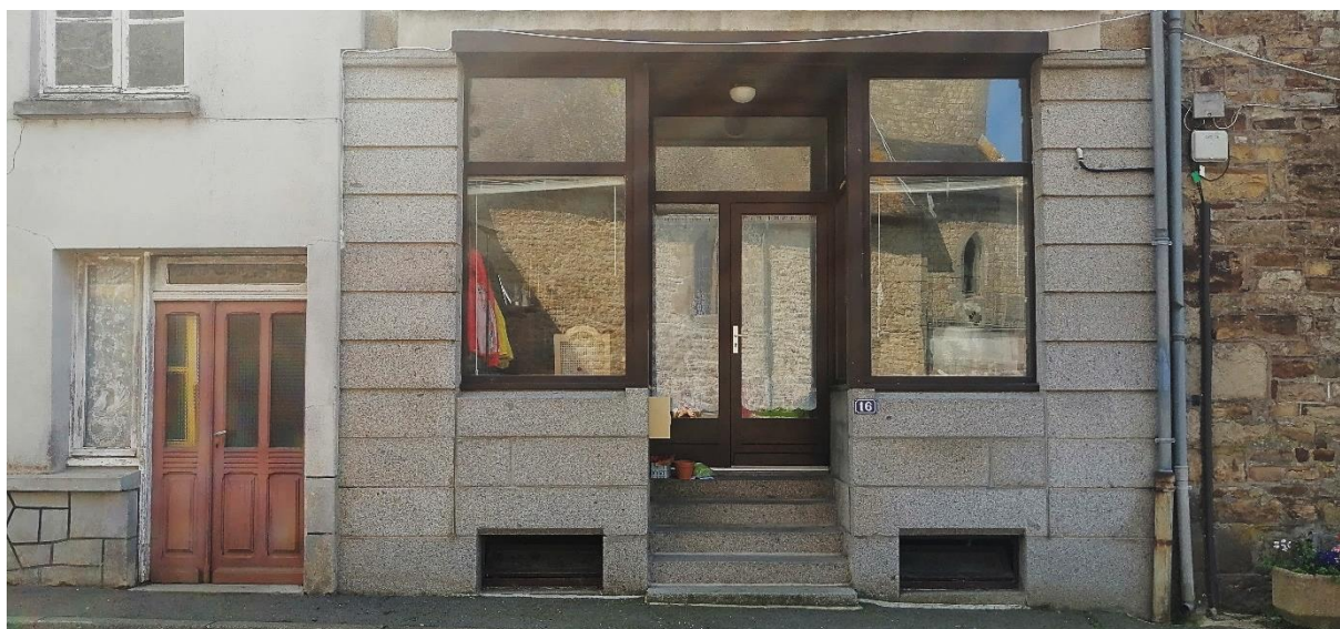
Photographie 33 - Ancien commerce transformé en logement à Saint-Georges-de-Rouelley (A. Graby, 2021)
