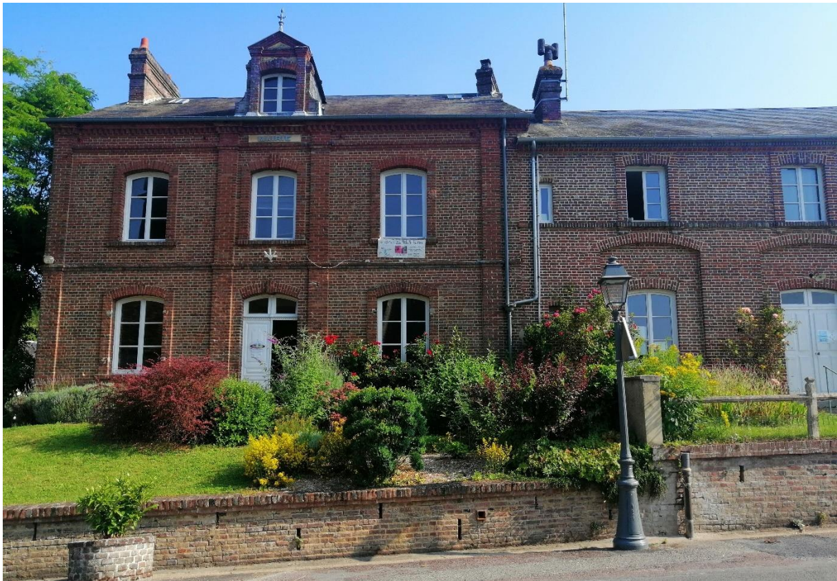
Photographie 21 - Exemple de bâtiment en briques augerons - ancienne mairie de Courtonne-la-Meurdrac (A. Graby, 2021)
