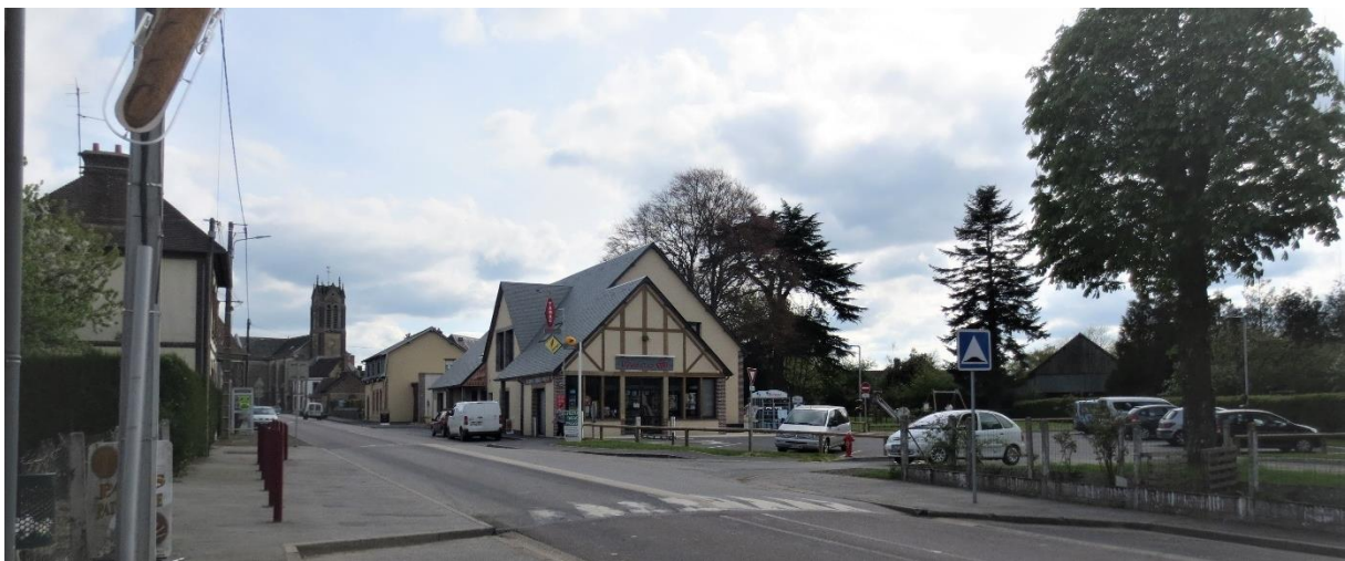
Photographie 35 - Parking du pôle commercial de Crulai (A. Graby, 2018)
