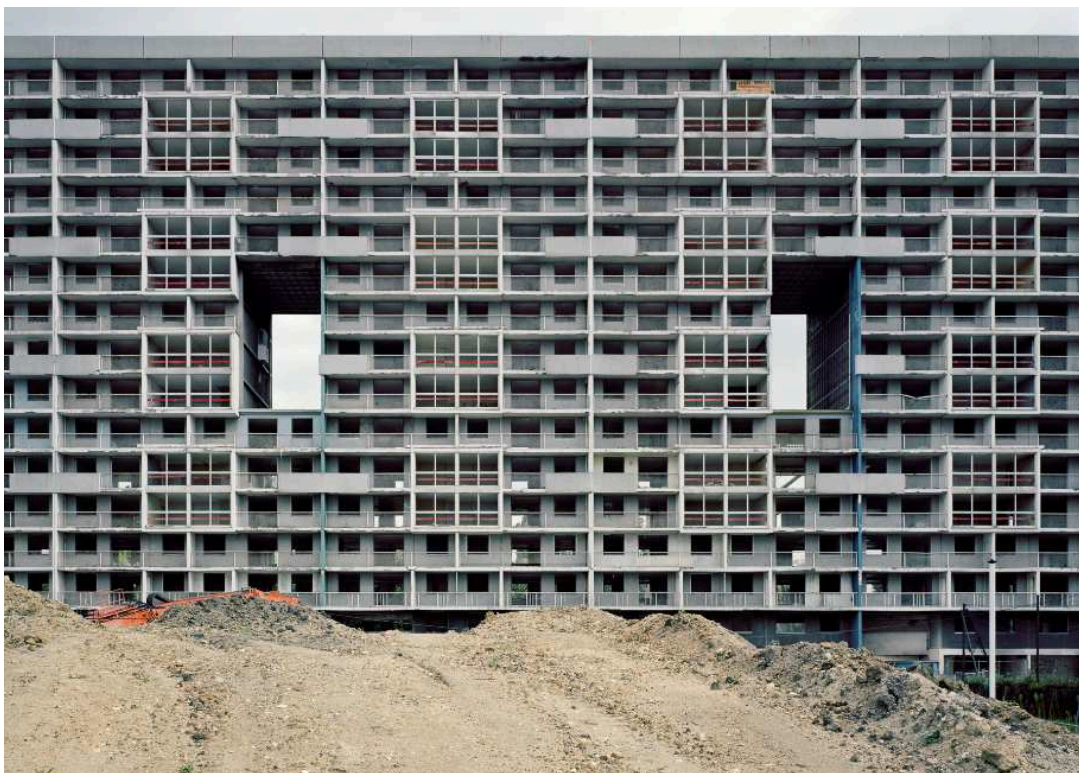
Photographie 18 : La Courneuve (Seine-Saint-Denis), La Cité des 4 000. Démolition par grignotage de la barre Balzac, le 20 juillet 2011, photographie Martin Argyrolo
