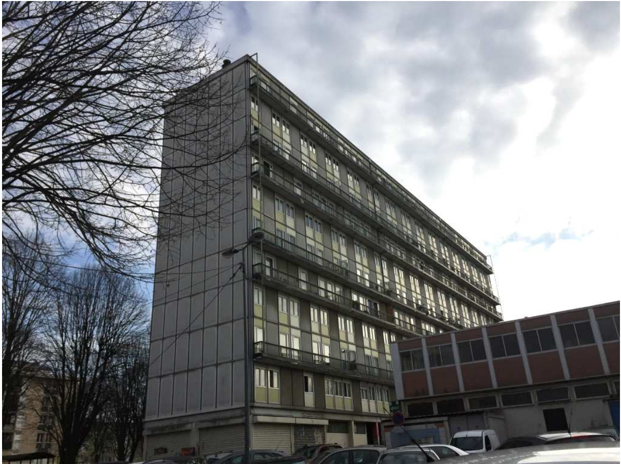
Photographie 36 : Façade Est de la barre Fragonard, photographie prise par l'auteure le 23 février 2017
