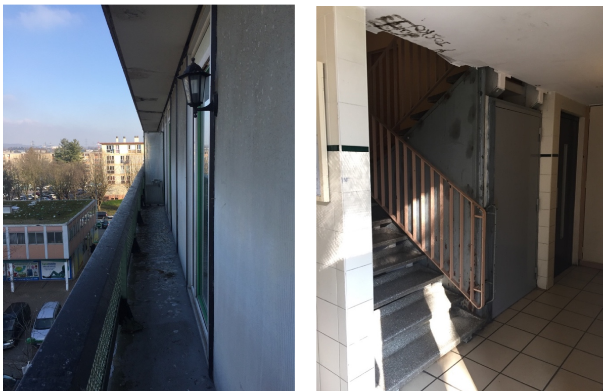
Photographie 37 : Balcon et entrée de la barre Fragonard, photographies réalisées par l'auteure en mars 2016
