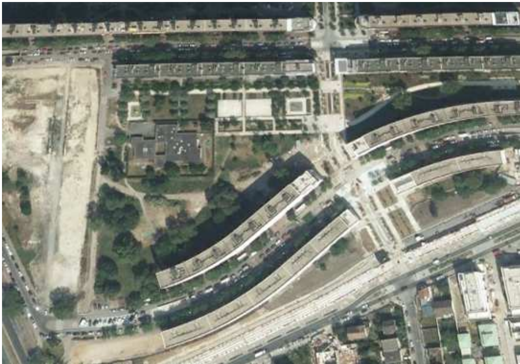
Photographie 20 : Après la démolition de quatre barres dans le quartier du Luth à Gennevilliers afin de désenclaver le quartier 79
