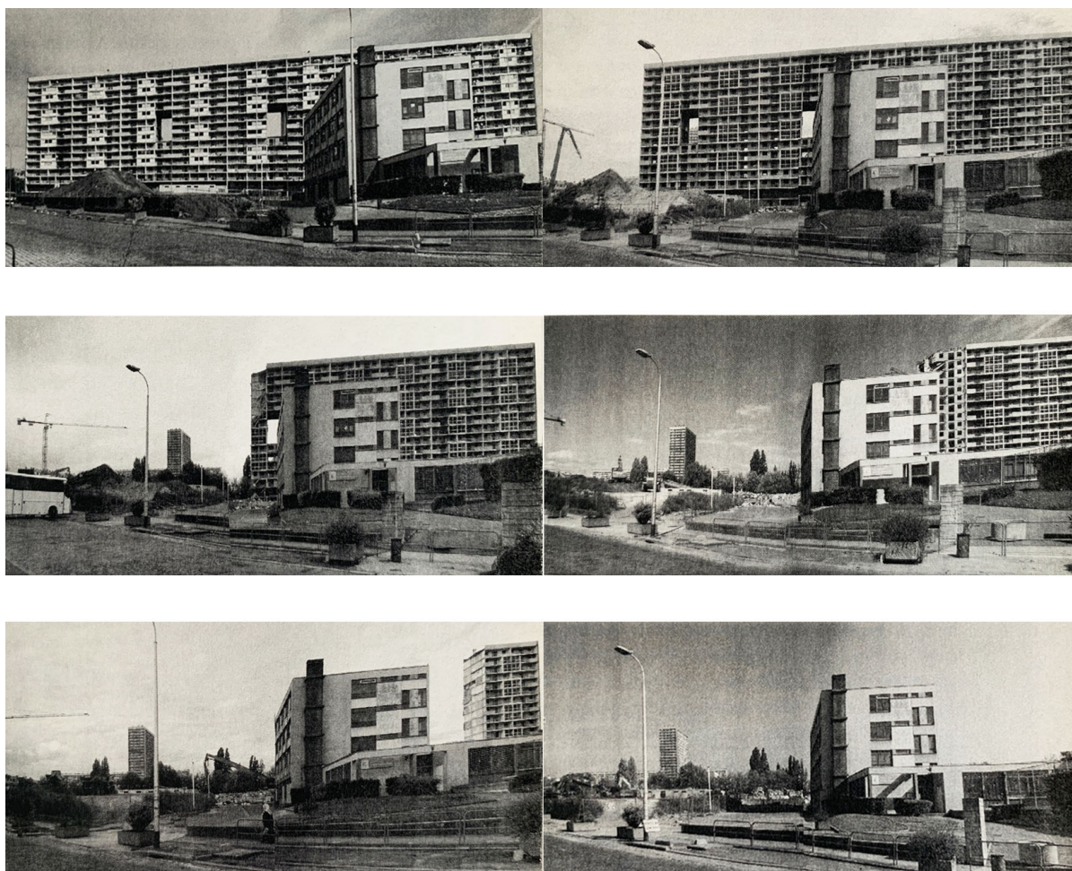
Photographie 14 : Déconstruction de la barre Balzac à La Courneuve, photographies prises respectivement le 2 avril, 2 mai, 2 juin, 2 juillet, 2 août et 2 septembre 2011, (De Biase 2014 : 81)
